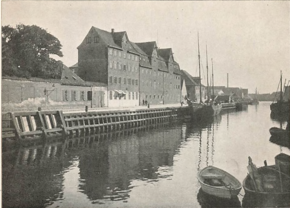
Udsigt mod Nord fra Snorrebroen over Christianshavns Kanal. (Fotoferet 1905 af G. L. Grove).
