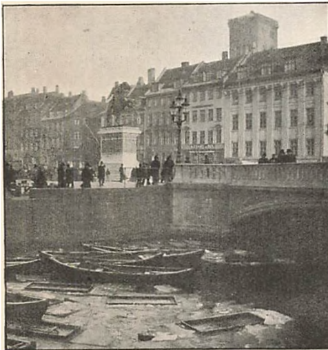
Slotsholmskanalen med den ny Højbro.
