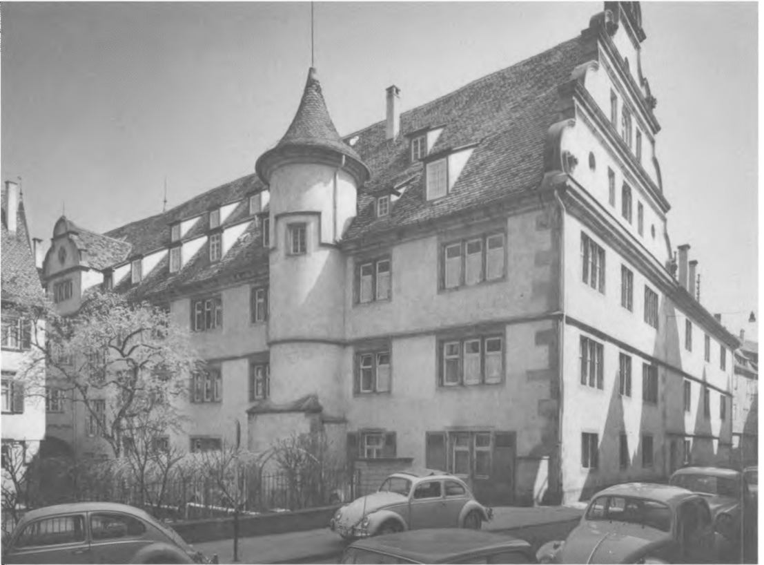
Collegium Illustres bevarede bygningskompleks fra slutningen af 1500-tallet, hvor den katolske Wilhelmsstiftelse har haft til huse siden 1816. Hell fot. 1974 for Landesdenkmalmamt Baden-Württemberg.
