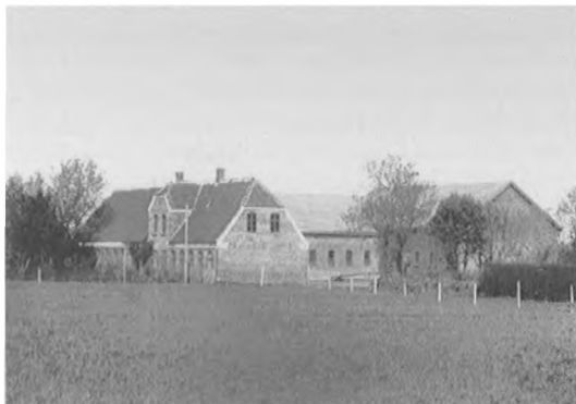
En trelænget gård fra før 1925. Det tegldækkede stuehus har (vistnok) en gang haft stråtag. I staldbygningerne er der plads til 20 køer og laden var den største i Aal sogn. Gården brændte ved lynnedslag i 1945, men blev genopbygget.
