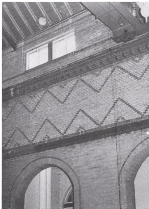
De flisebelagte mure. Th. øverst i billedet ses kørekranens ene hjul over den tandsnitprydede betonbjælke og mønstermuringen.
