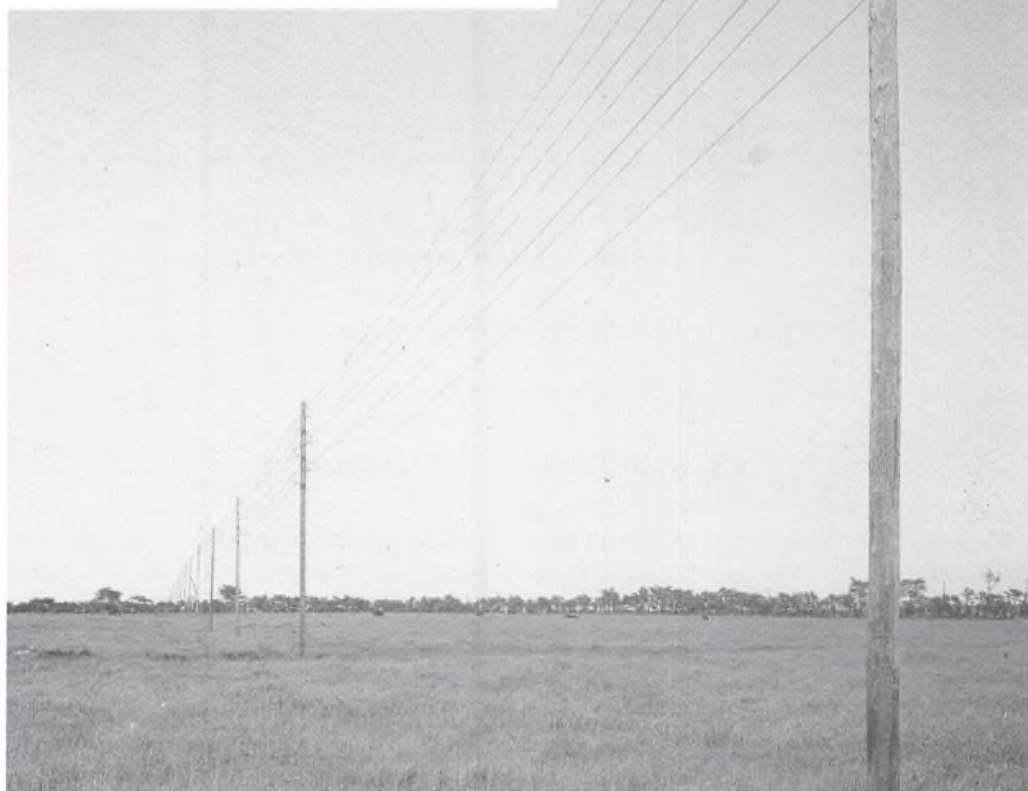
Elmasterne erobrede landskabet. Transformatorårnene th. dukkede op. Øverst et tårn af jernbeton ved Oust Mølle. Betontårnene havde rødt paptag, grønne døre og luger. Nederst: Rødt teglstentårn ved Lystrup.
