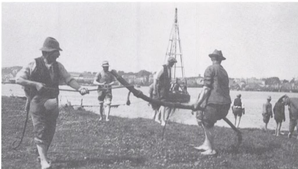
'Titusind Volt nu sprutter fra Randers til Hadsund', skrev Westergaard. Forud for denne konstatering lå utallige beregninger og et utroligt slid. Billederne viser søkablets udlægning og ilandtagning ved Hadsund.
