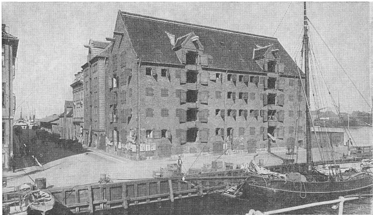
Suhrs pakhhus, Nyhavn 71. Det blev i 1805 bygget af to ejere, O. B. Suhr og kaptajn J. Ludvigsen. De byggede et dobbelt pakhhus og delte det derefter ved lodtrækning. O. B. Suhr vandt pakhuset ud mod Nyhavn, mens pakhuset nordfor blev Ludvigsens. Billedet her stammer fra år ca. 1900. (Københavns Bymuseum.)
