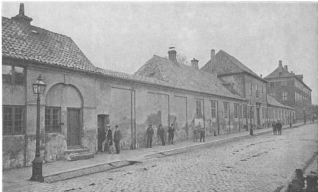
Professorboligen og muren, der adskilte Nyhavn fra Botanisk Have, som dengang lå bag Charlottenborg. Siden 1883 har den store, røde udstillingsbygning ligget på størstedelen af det område, der ses på det gamle fotografi fra omkring 1870.
