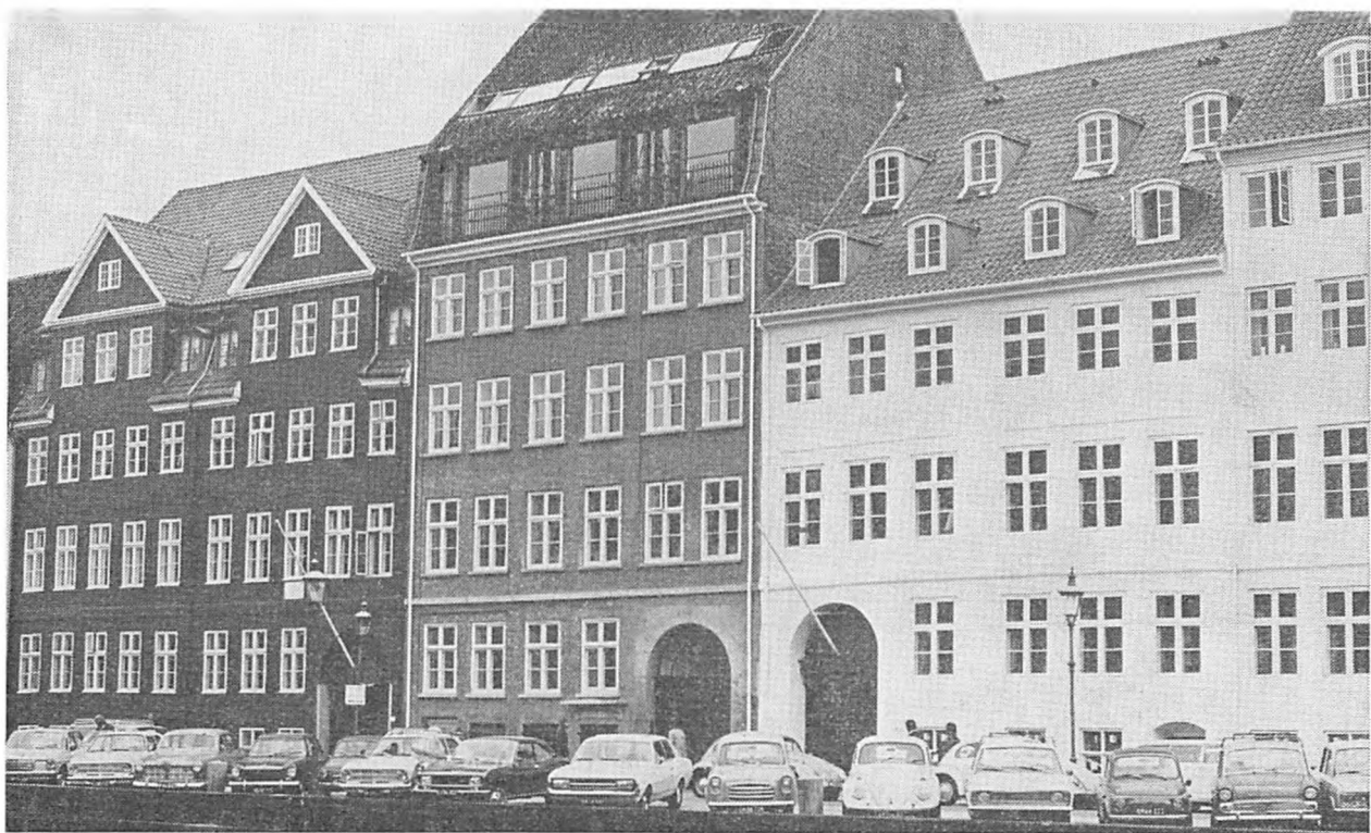
Nationalbankens hus endnu engang. Foroven har man lavet en gæstelejlighed til bankens tilrejsende. Man har brudt mønstret i tagrækken ved at lave en moderne glasetage og med en række glasinduer i selve taget.
