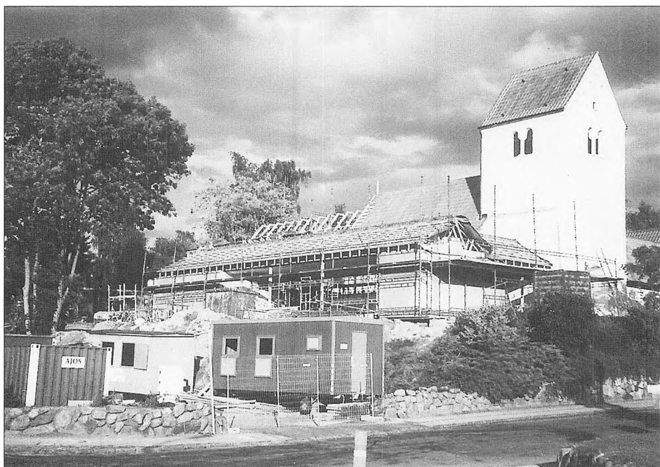
Byggeaktivitet i sommeren 1997. Kirkens nordfløj er ved at være under tag.
