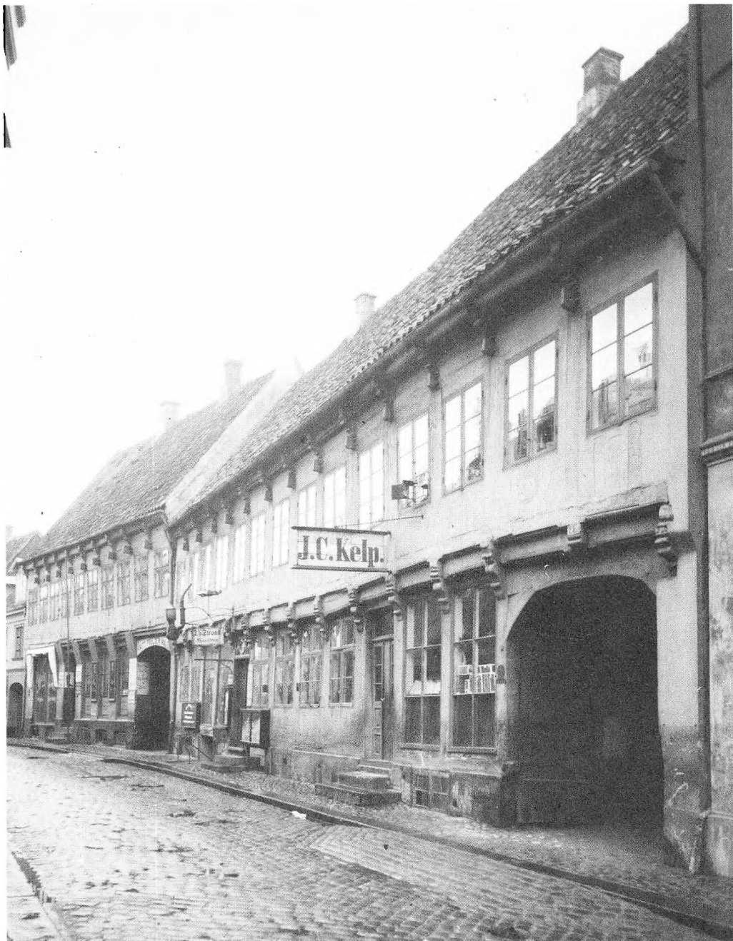
Brødregade 23-25, nr. 23 nedrevet. Begge bygninger er fra 1660erne, identiske i opbygning og med kraftigt markerede tagskægsled. Zehngraf fot. ca. 1896.
