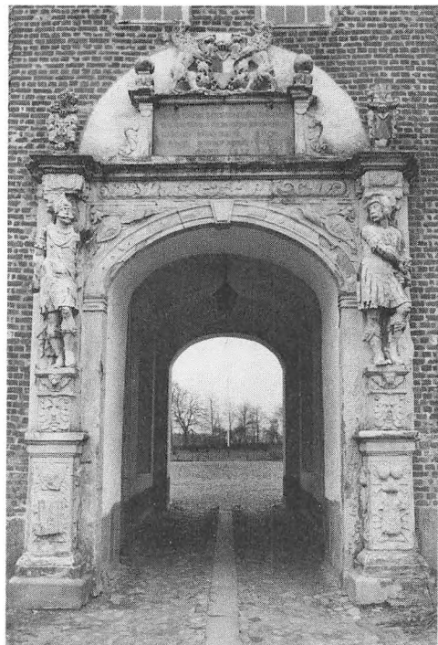
Portvogterne i portalen fra Ulstrup Slot fra 1620, udført i sandsten.
