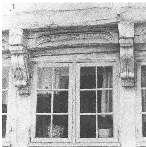
Strandgade 27. Rigt udskårne fyldholter og knægte er ikke usædvanlige for de store, østdanske gårde.
