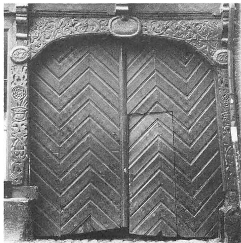
Farvergården, Kirkegade 9, nedrevet. Gården blev opført i 1725 som en knægtbygget gård med snirklede skærier på såvel porthammer som portstolper. Zehngraf fot. ca. 1896.
