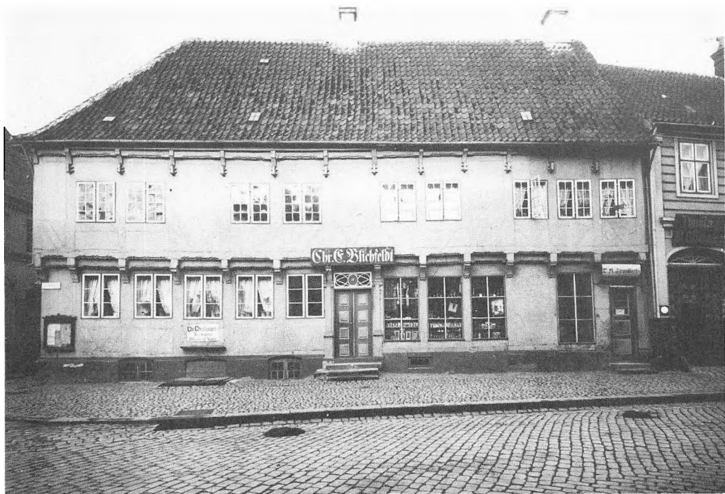
Storegade 14, nedrevet. Bemærk, at tagkægsleddet dekorativt gentager overgangsleddet, selv om det konstruktivt er ganske anderledes opbygget. Zehngraf fot. ca. 1896.
