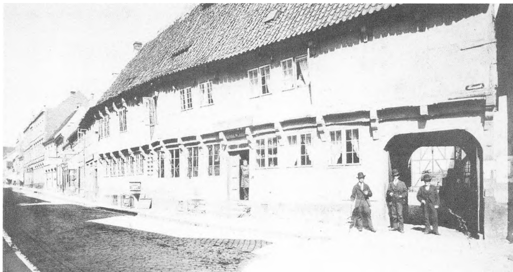
Torvegade 21, nedrevet. Længens fem nordre (venstre) fag har tidligere stået med gavl mod gaden. Taget er her vendt, men stikbjælkerne over tagskægsknægtene vidner om en tidligere fremkraget gavl over disse fag. Zehngraf fot. ca. 1896.
