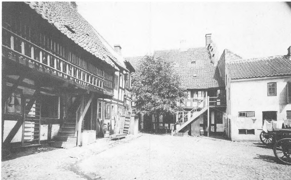
Gårdinteriør fra Påskesønnernes Gård. Bindingsværksbygningerne er formentlig fra 1700tallet, ligeså ludebygningen på det grundmurede hovedhus. Zehngraf fot. ca. 1896.
