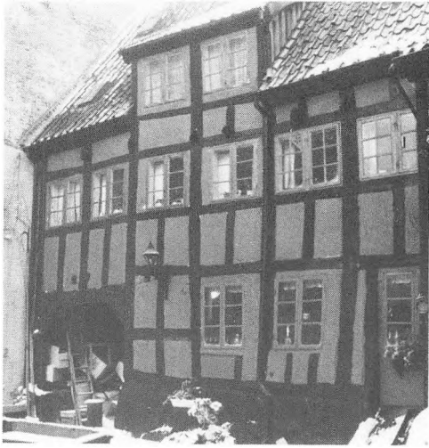
Vestergrave 48, gårdsiden med de formodede genanvendte højstolper.
