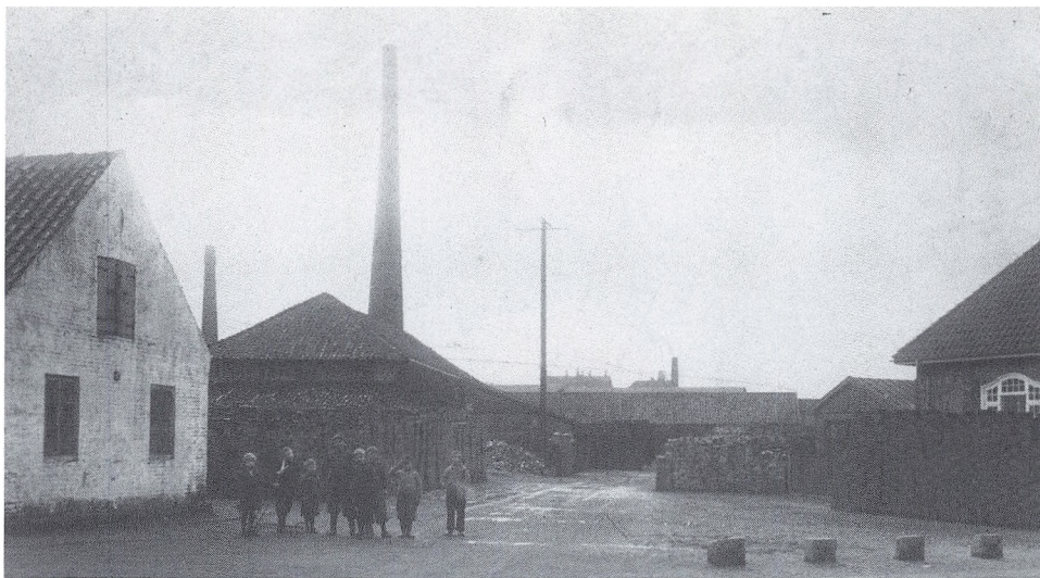
Struer Teglværk producerede sten til byens huse i ca. 100 år, fra 1830'erne til 1936. Struer voksede frem omkring teglværket, som derved kom til at dele byen i en østlig og en vestlig del. Østergade var med sine mange handlende den streng, der bandt byen sammen. Foto fra 1920'erne.
