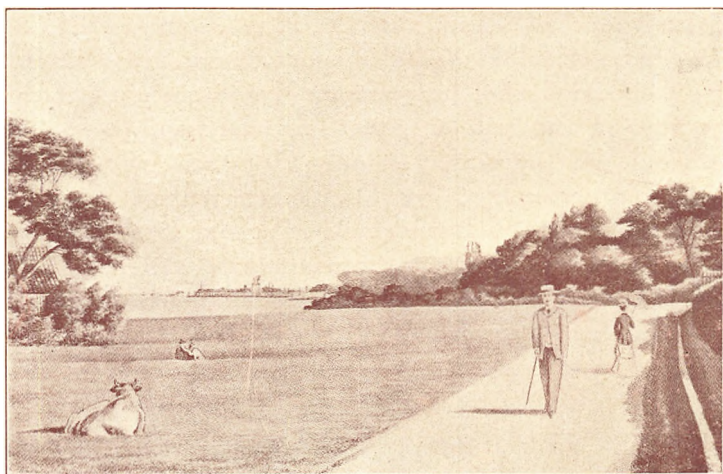
Strandpromenaden ud for Rosenvænget. 1880. (I Baggrunden ses Orlogsværftet)
