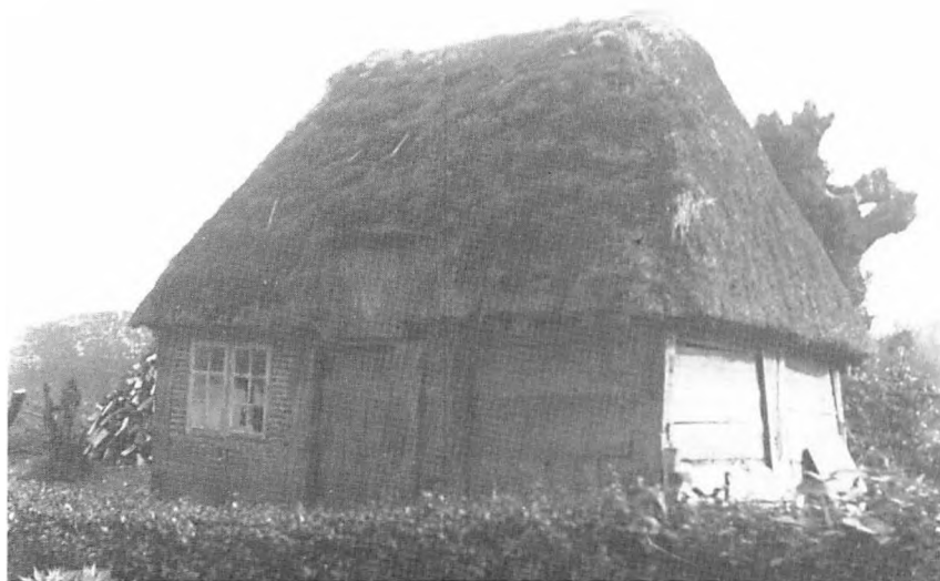
De fleste håndværkere var småkårsfolk, der boede i ganske små huse eller lejligheder. Dette hus fra Barsmark var bolig og værksted for en træskomager. Selv her ser man, at selve beboelsesrummet var bygget i grundmur, mens husets anden ende var i bul. Foto af Jes M. Holdt 1935, Historiske Samlinger.
