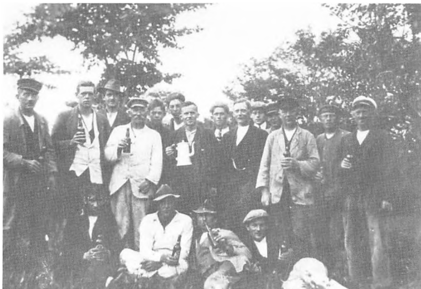
Standsforskellen mellem gårdmænd og arbejdere havde længe været en hindring for et effektivt dansk nationalt arbejde, men ved opførelsen af forsamlingshuset var begge grupper med. Arbejderne bidrog således med deres arbejdskraft ved byggeriet. Her ses nogle af dem ved rejsegildet i 1930. Det er fra venstre Johs. Dinesen, Jes Boysen, Nomanni, Jørgensen, Ernst Dahlquist, Peter Bryld, ?, Hans Boyesen, Jens Degn, Carsten Jensen, Hans Knudsen, tømrermester Christiansen, Peter Boisen og Aug. Svenesen (alle tre siddende) samt Iver Iversen. Fot. i Lokalhistorisk samling, Løjt.
