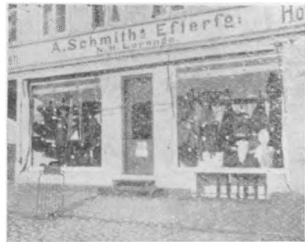
N. H. Lorange's Møbellorretning.
