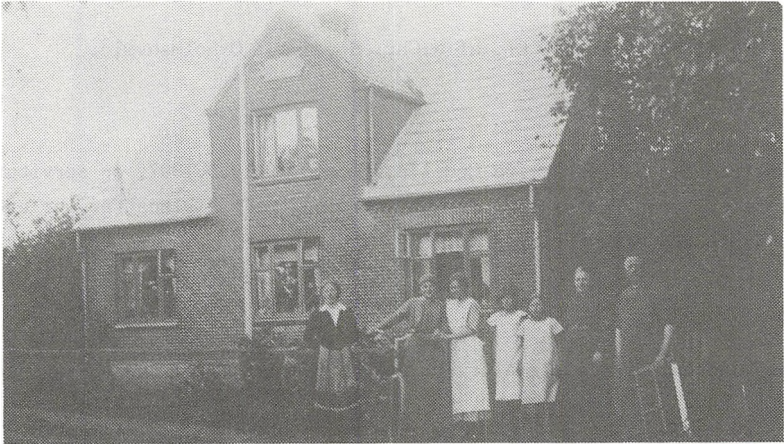
Elbjergvej 53. Foran huset står flere Katstrupborgere bl.a. karetmageren Jørgensen med kone o.a.
