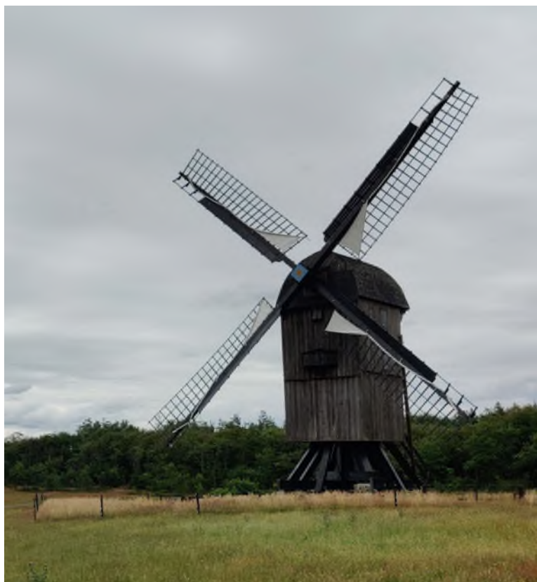
Dunkær Mølle var en vindmølle og fra 1600-tallet, hvor familien først ses på møllen og frem, skete der en udvikling af mølleteknologien. Denne stubmølle fra Hjerl Hede er en af de ældste typer.
