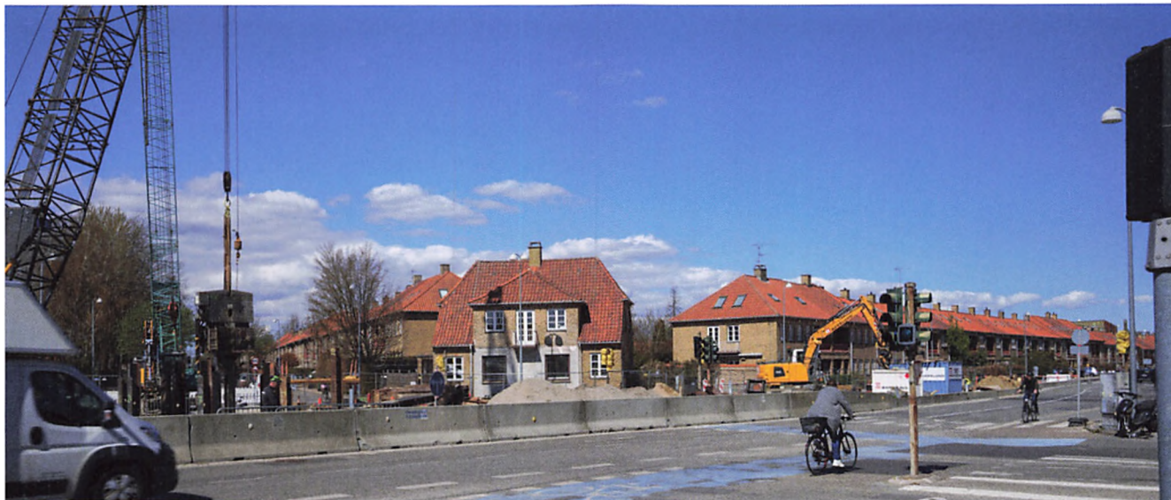
Københavns Letbane under anlæggelse maj 2021. Krydset Buddingevej-Christian X's Allé (foto: Henning Andersen).
