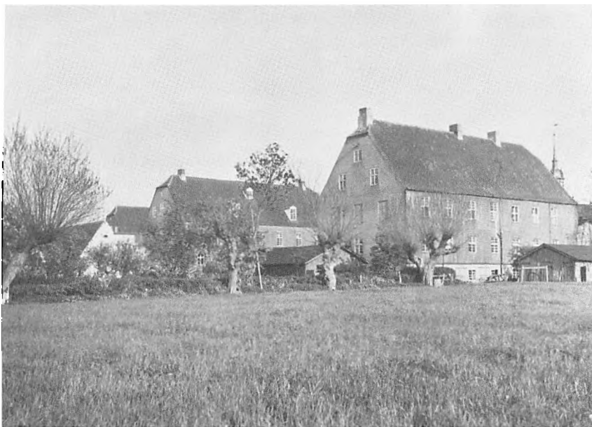
Enkehusets og Søstrehusets bræddebeklædte sidefløj set fra nordvest. HHE foto 1946.
