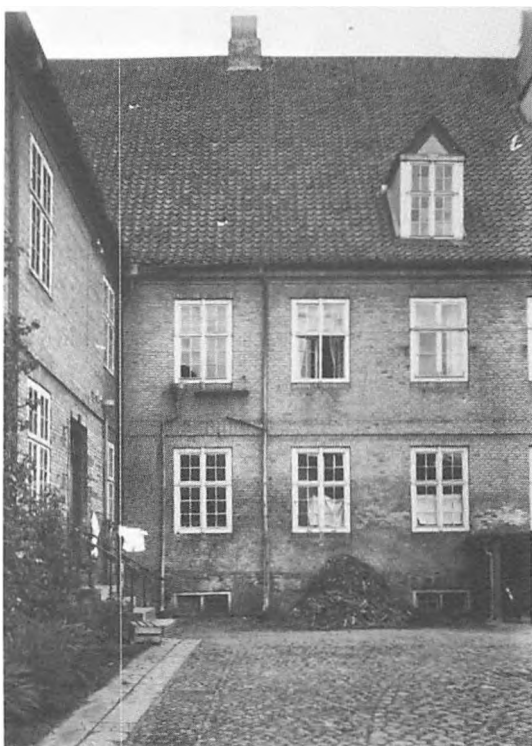
Hjørne af Brødrhusets gård med de oprindelige indad- gående vinduer. HHE foto 1946.
