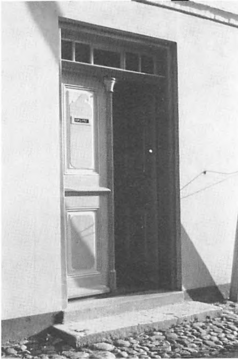
Lindegade 10 (Ø.kv. 1), gadedør 1773. HHE foto.
