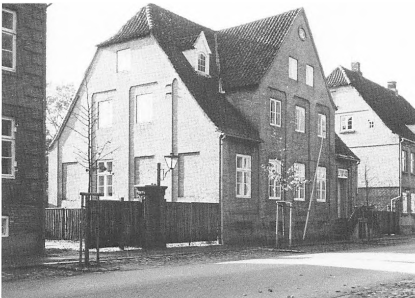
Lindegade 26 (V.kv. 5) opført 1773 for Brødremenighedens forstander Jonathan Briant. HHE foto 1982.
