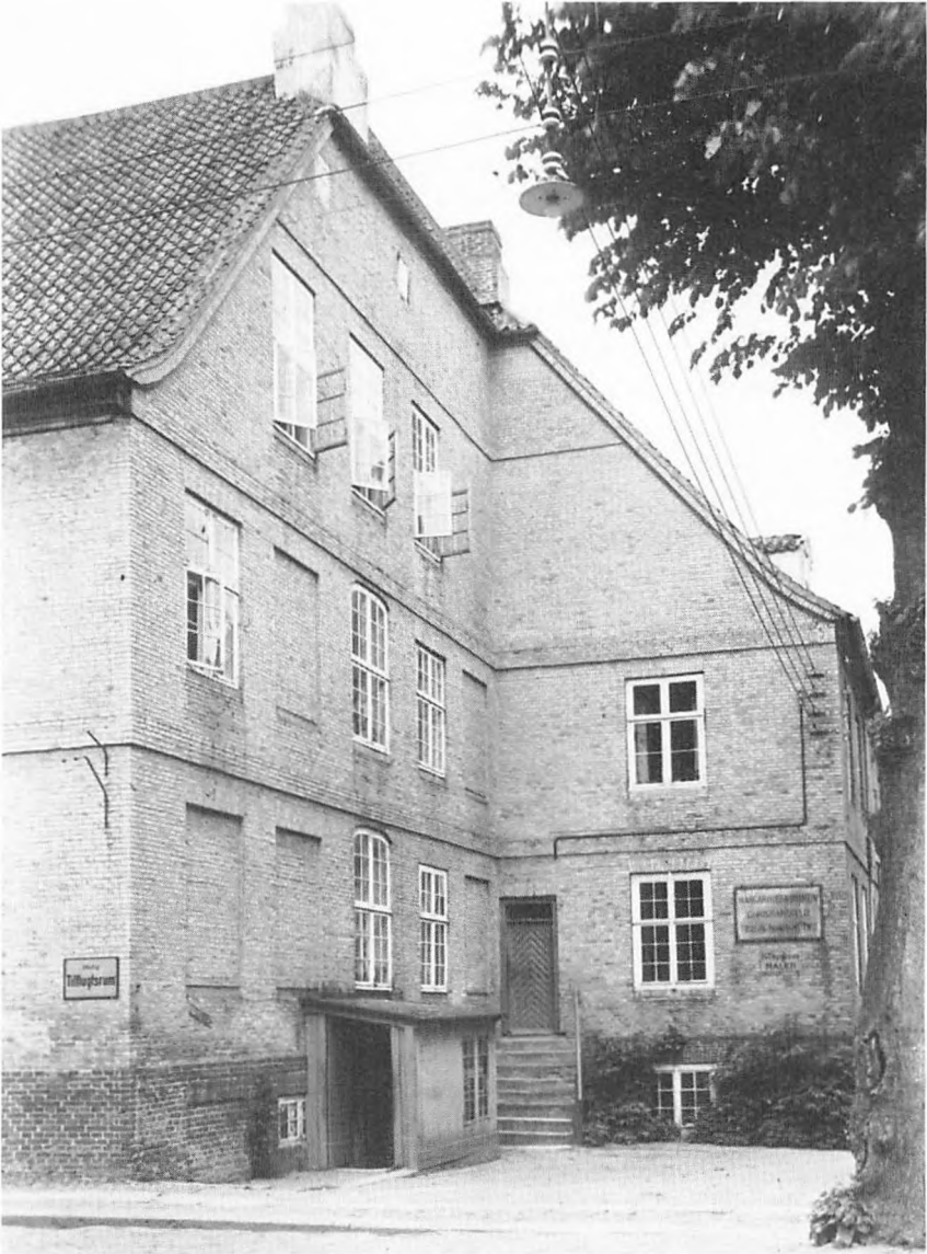
Sammenbygningen mellem Søstrehusets østgavl og den i 1784 påbegyndte østfløjs nordgavl. Bemærk østgavlens kurvehanksbuede vinduer, der belyser hovedbygningens midtergang samt de glatte murede etagebånd. HFE foto 1946.
