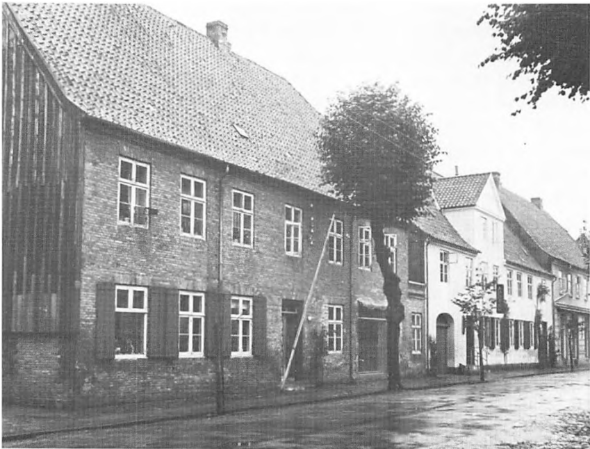
Lindegade 19 og 21. Lindegade 19 er bygget som énetages skolebygning og blev opgivet som skole i 1788 og ombygget til et tofamiliehus, i 1797 forhøjet til to etager. HHE foto 1946.
