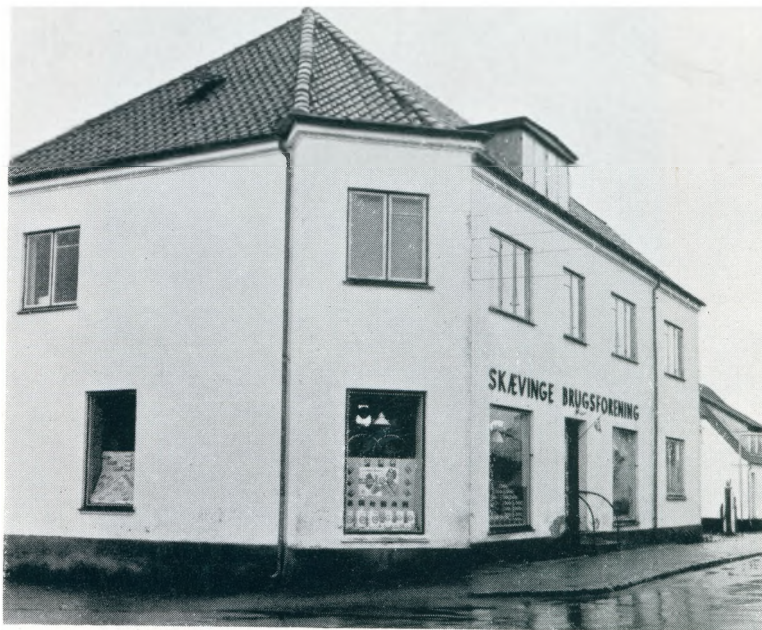
Skævinge brugsforenings hovedbygning, opført 1936.
