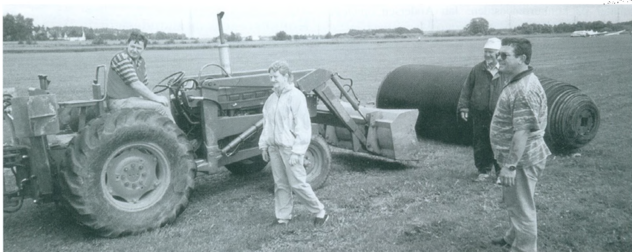
Søren Grum i gang med rørlægning af Aas Å. På billedet ses Jette Grum-Schwensen og Steen Løvig.
