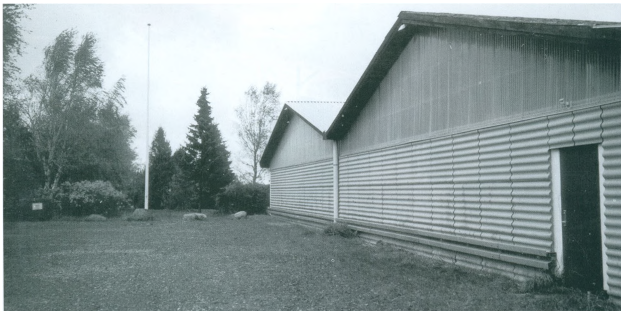
Den nye facade på hangarens vestvendte mur i Jens Roslings design.
