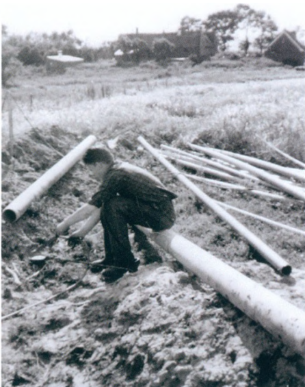
Jens i gang med nedlægning af vandfør 1963
