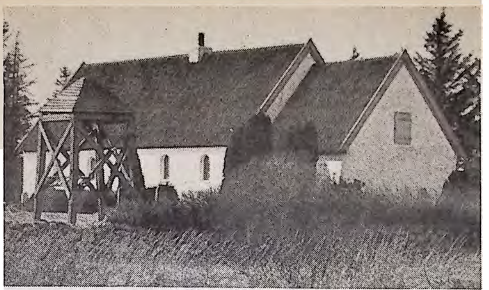
Raabjerg kirke ligger i en såkaldt ødemark. Kun ganske lidt bebyggelse i nærheden: et par gårde og enkelte huse. Kirken er sikkert opført i 1200 tallet på overgangen fra romansk til gotisk stil, hvilket ses af, at korbuen er spids. Den er bygget af munkesten på en sylde af rå kampesten.
