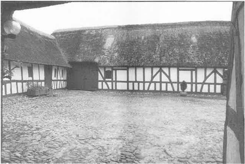
Gård i Katvehave ved Husby. Længen modsat portåbningen er en sulelænge, hvilket ses på den specielle skråbåndskonstruktion. Skråbåndene støtter vægstolpen i det fag, hvor sulen står.
