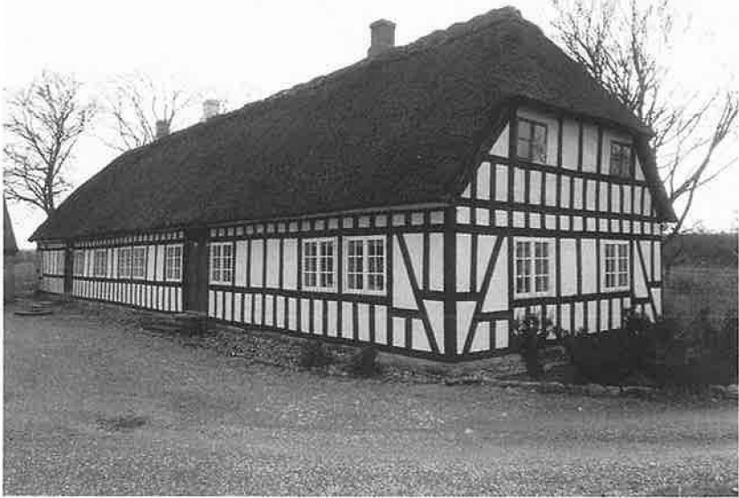
Enghavegård i Bro ved Brenderup er opført i typisk nordvestfynsk bindingsværk, hvor æstetikken er prioriteret næsten lige så højt som det konstruktive (»dokkerfrisen« og de specielle hjørnefagsafslutninger).
