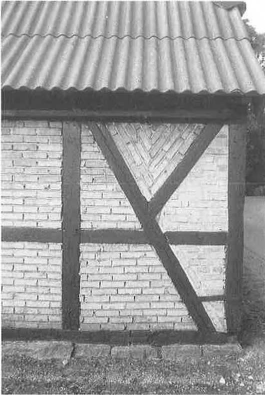
Gård i Viby på Hindsholm med en hjørnefagsløsning, der kendes på Hindsholm og området mellem Kerteminde, Nyborg, Marslev og Munkebo. Det er ivoigt relativt sent bindingsværk, og tavlene er udmurede med gule sten uden overfladebehandling.
