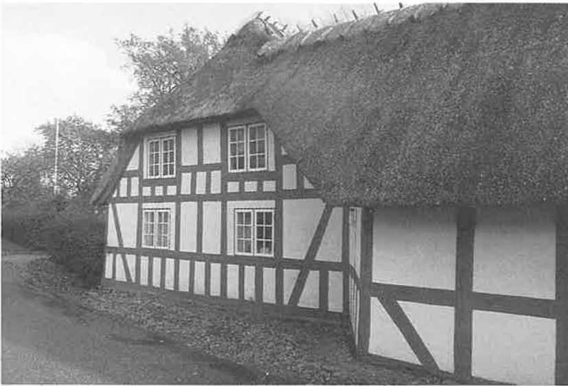
Højbjerggård i Ubberud sogn er en af Fyns største og flotteste bindingsværksgårde. Der er brugt usædvanligt svært tømmer og i rigelige mængder. Tømmeret er rødt og tavlene hvide.
