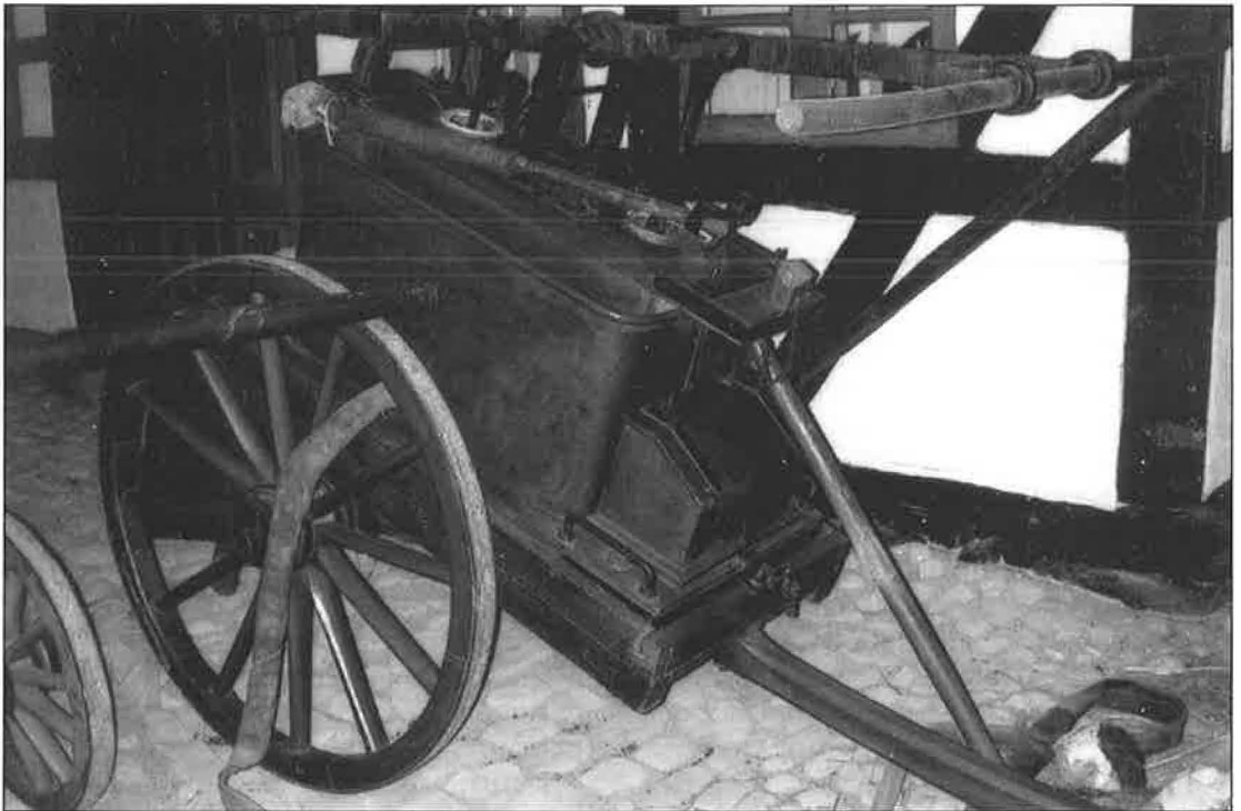
Brandsprøjten på hovedgården Skovsgård. Sprøjten på billedet er angiveligt yngre end den, som omtales i teksten. Kærren kunne hægtes efter en anden vogn. På brandstedet skulle der løbende hældes vand i et tilhørende stort kar, mens fire personer pumpede, og én betjente slangen med strålerør. I øvrigt brændte en stor del af Skovsgårds udbygninger i 1854. Skovsgårds vognmuseum. (Foto: Langelands Museum)
