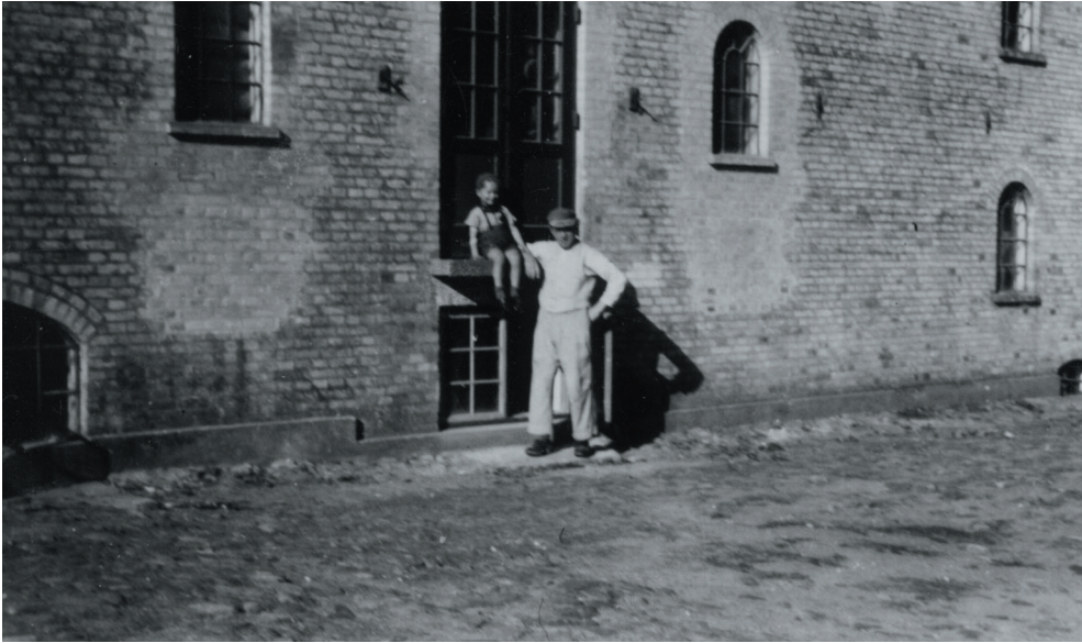
På dette billede ses det meget tydeligt, hvordan vinduer og dør blev flyttet i møllen. Da billedet blev taget omkring 1950, var dette endnu ikke sket i den fjerneste del af bygningen længst til højre. I et par år fungerede den nye turbine og det bageste vandhjul nemlig samtidigt.
