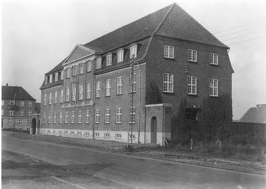
De fleste af de nye danske embeder kunne i 1920 flytte ind i de tyske forgængerembeders bygninger. Den rivende udvikling i telefonvæsnets nødvendiggjorde imidlertid snart en større nybygning til Post- og Telegrafvæsnets 2. ingeniørdistrikt. I 1920 var der således knap 2800 telefonabonnenter i Sønderjylland, i 1926 var der ca. 10.000. Den nye bygning på H. P. Hanssensgade i Aabenraa blev opført i 1925 af arkitekt Jep Fink i en palæliggende stil, som var typisk for tidens offentlige bygninger. Rud. Olsen fot. i Institut for sønderjysk Lokalhistorie.
