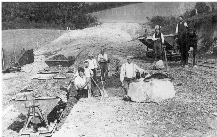
Det var hårdt arbejde at anlægge vej i 1920'erne. Foto fra anlæg af Varnæs-vejen. Foto i Ensted sogns lokalhistoriske arkiv.
