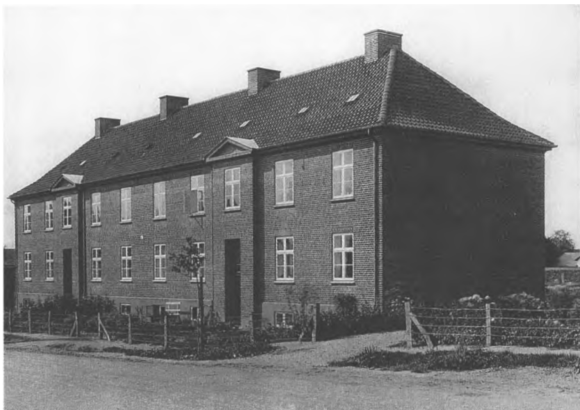
Padborg By. Et af de mange byggerier, der blev opført i den nye Nørregade i Padborg for at skaffe et større antal tjeneste- og lejeboliger til statsbanernes medarbejdere. Opført på de supplerende eksproprierede arealer, hvorom den juridiske kamp blev udkæmpet. Foto i Jernbanemuseet.
