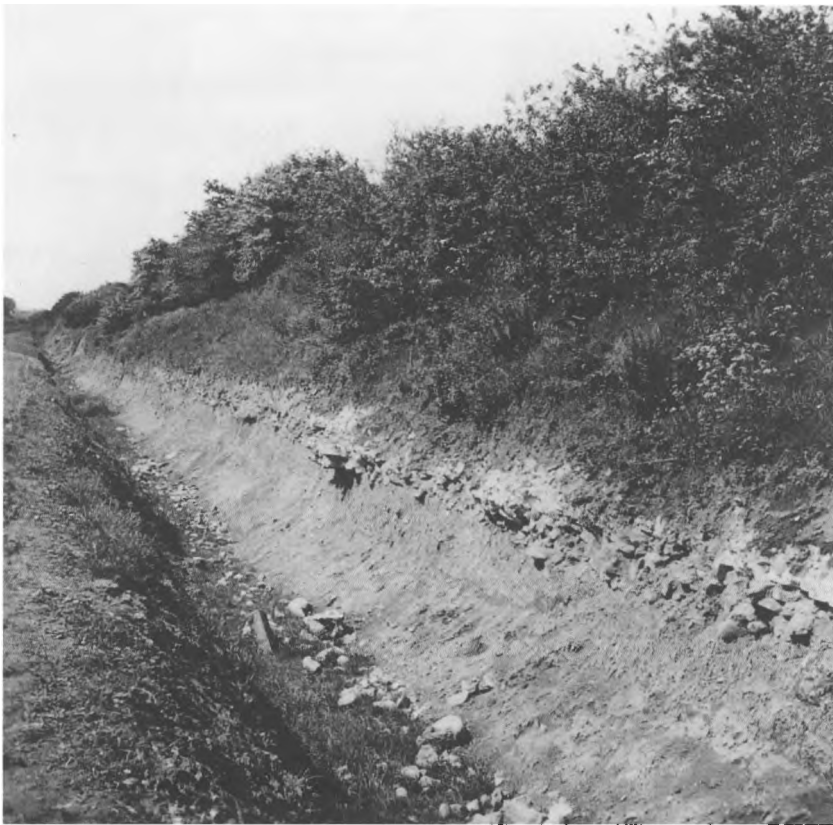
Pansergraven ved Danevirke blev på centrale strækninger anlagt umiddelbart foran de bevarede rester af Valdemarsmuren (ca. 1165-90) hhv. Kampestensmuren (ca. 737-750). Det førte til dels til nedstyrtninger af murbrokker i tankfælden. Foto: Søren Telling, optaget efter krigen i 1945. Kopi findes på Nationalmuseet og Museet ved Danevirke.
