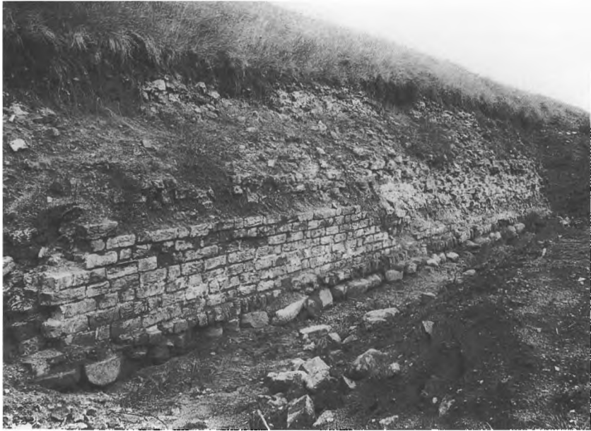
Pansergraven kan på sin vis betegnes som én stor udgravning på langs. Efter krigen kunne danske arkæologer undersøge volden og Valdemarsmuren. Her ses et ganske velbevaret stykke af teglstensmuren, hvor den ydre skalmur er delvist bevaret, og hvor fundamentet af kampesten fremstår tydeligt i udgravningen. Foto: C. G. Schultz 1946, Nationalmuseet.
