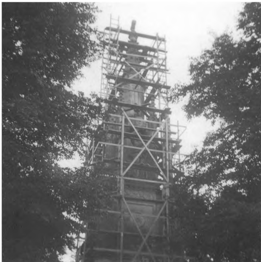
Arnkiel Denkmal under restaureringen 1939. De to sejrsmønstre blev pakket ind i stilladser fra firmaet Wasa A/S, København. Højden på Düppel og Arnkiel Denkmal angives ofte til henholdsvis 22 og 18 meter. Det var formentlig også disse højder, der blev opgivet til stilladsfirmaet. Under opbygningen af stilladset viste det sig imidlertid, at monumenterne var henholdsvis 24 og 20 meter. Det gjorde restaureringen en del dyrere end budgetteret. Foto: Rigsarkivet: SM 3/1946.
