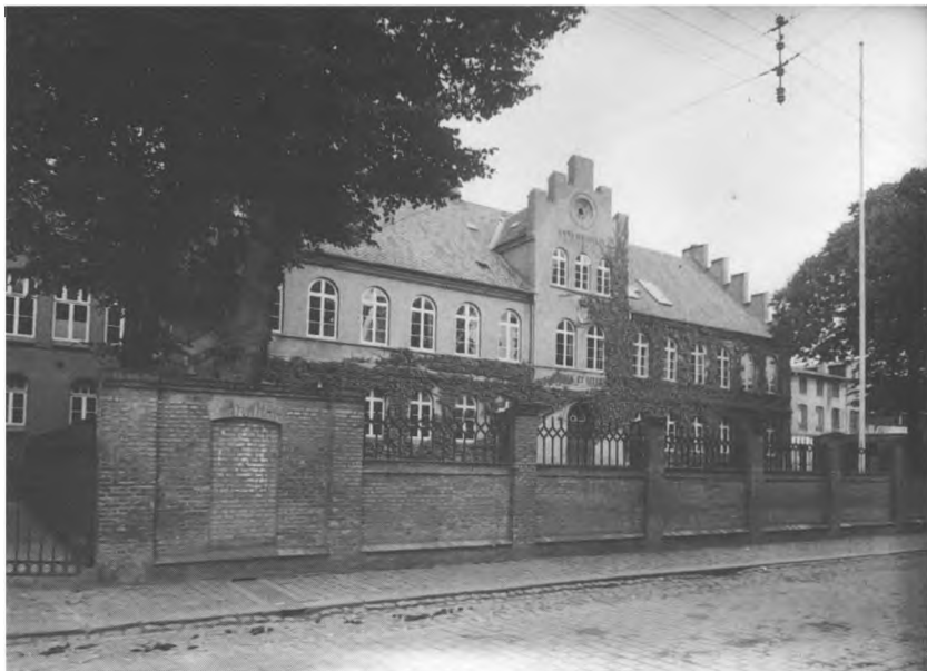
Haderslev Katredalskole omkring 1930. På grund af omfattende reparationsarbejder på bygningerne i Haderslev åbnede skolen her to uger senere end planlagt, nemlig den 7. september 1920. Bygningerne var efter verdenskrigen i så dårlig forfatning, at kontorchef i Undervisningsministeriet, Kai Glahn, ved den første besigtigelse udbrød, at »den er lige til at rive ned og genopføre fra grunden«. Det var imidlertid ikke mindst rektor Karl Mortensens fortjeneste, at den gamle hovedbygning fra 1854 fik lov til at blive stående. Foto: Institut for Sønderjysk Lokalhistorie.
