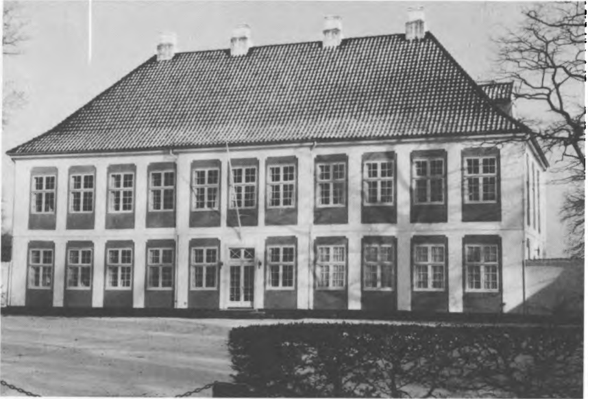
Fig. 16. Sandbjerg, opført 1787-88 af bygmester Chr. Aug. Bohlsmann. Bemærk de hvide liséner med små knæk, de såkaldte »øreliséner«.
