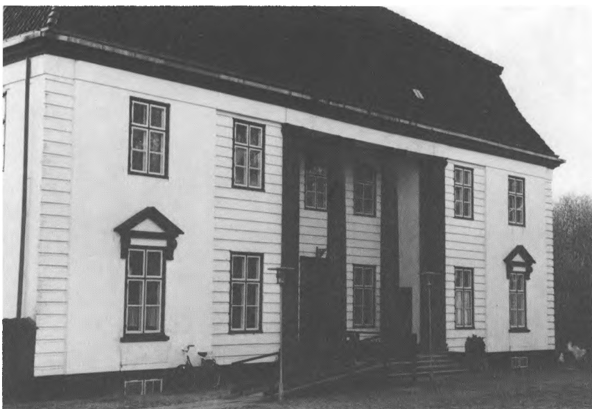
Fig. 24. Palæet i Augustenborg set fra gården. Tegnet af arkitekten Peter Meyn, men ændret noget ved opførelsen ca. 1791-92.
