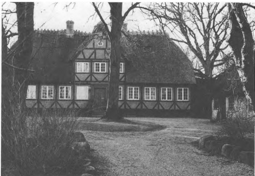
Fig. 19. Hørup Præstegård, opført 1765-69 af bygmester Chr. Aug. Bohlsmann. Det eneste kendte eksempel på Augustenborg-stilen i bindingsværk.
