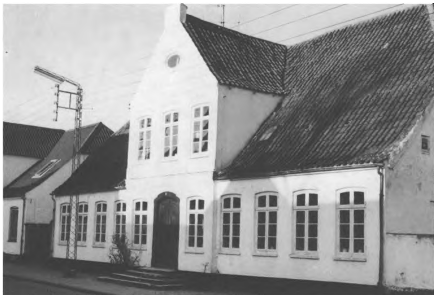
Fig. 18. »Hofrådets Hus«, Storegade 11, Augustenborg. Dette fine borgerhus er opført ca. 1775-80, men facaden er ændret i 1800-tallet (større vinduer).
