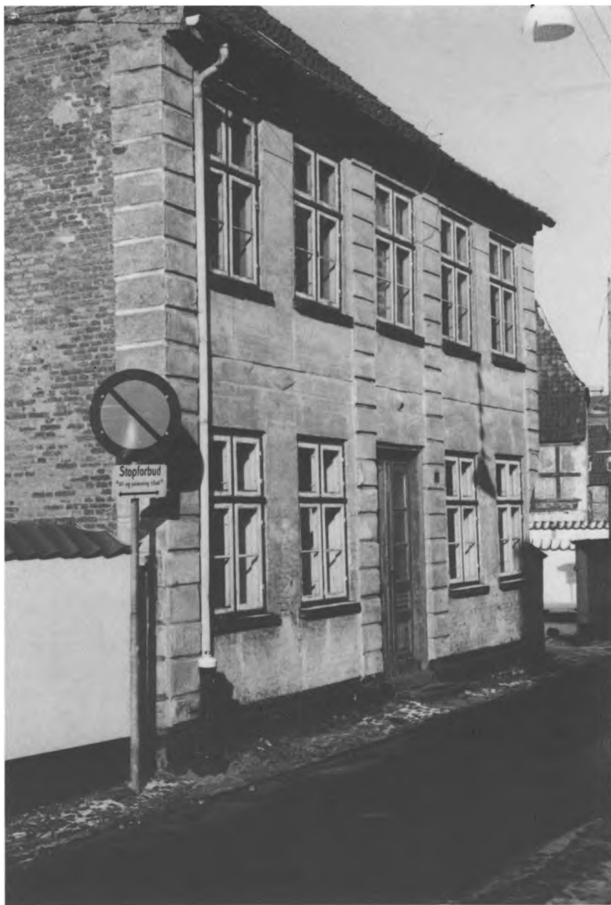
Fig. 29. Et dejligt nyklassicistisk hus med kvaderliséner, Søndergade 7, Sønderborg. Måske opført af J. C. Bleshøj omkring 1810.
