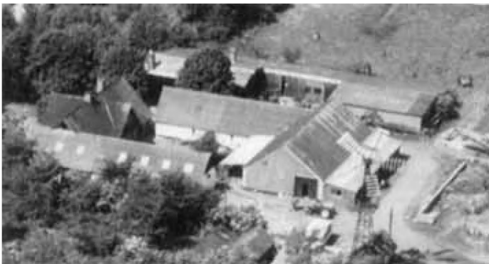
Matr. nr. 14d,14e, "Kærgården", Engebækvej 27
