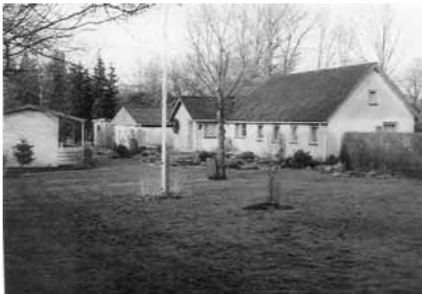
Matr. nr. 17h, "Slotshaven", Nørregårdsvej 66 - Foto H.N. 1999
