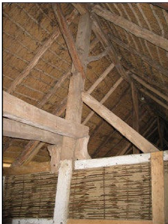
Sulekonstruktion i Fjeldstedgården i Den Fynske Landsby.
