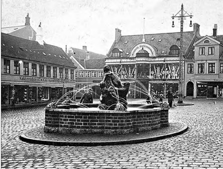
Torvet i Svendborg på postkort fra omkring 1900. Til venstre i billedet ses den bygning, som erstattede familien Bekkers gård midt i 1800-tallet..
