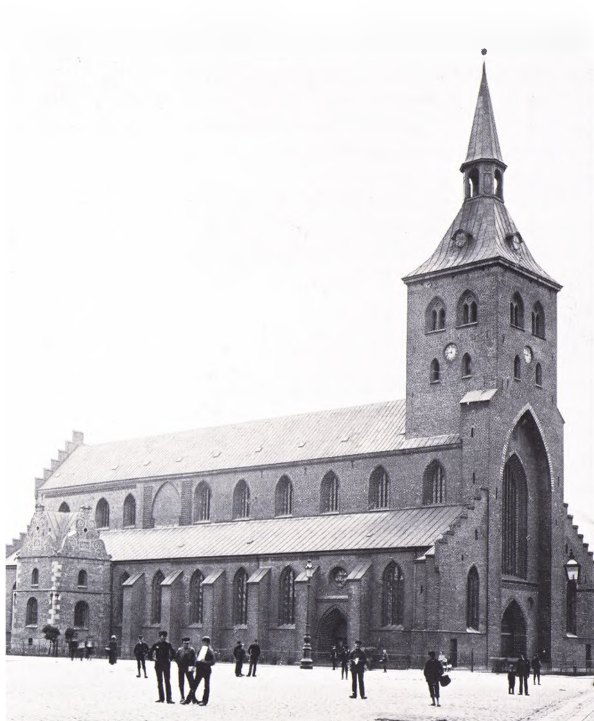
Sct. Knuds kirke er i overvejende grad middelalderlig og det fineste, vi har bevaret i Odense fra den her skildrede periode. Billedet er fra begyndelsen af vort århundrede. (E. Biering fot., Møntergården).
