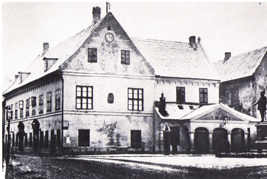
Byens gamle rådhus umiddelbart før nedrivningen 1880. Fløjen mod Vestergade indeholdt rester af det middelalderlige rådhus, der nævnes første gang 1480. (Lars Dinesen fot., Møntergården).
