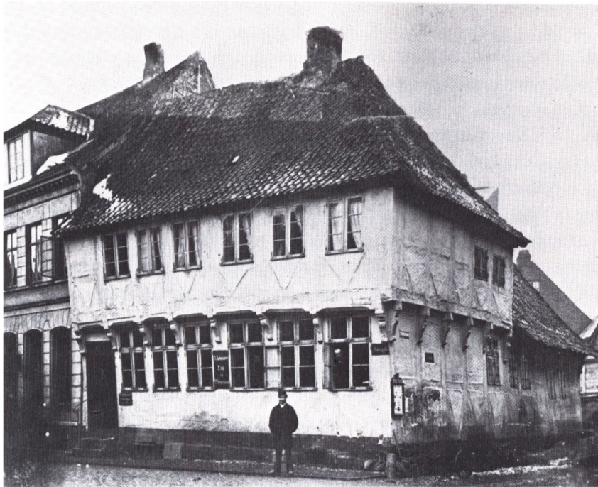
Smedesvendenes herberg på hjørnet af Nedergade og Påskestræde, fotograferet kort før nedrivningen i 1880'erne. Bygningen var formentlig opført omkring 1575. (Møntergården).
