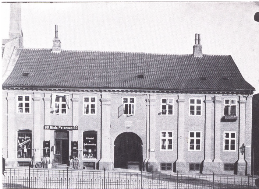
Rebslagergården, Overgade 60, opført 1764 af rebslager og købmand Hans Hansen Leopold. Den vestligste del af facaden blev dog først grundmuret 1816-17. (Hugo Matthiessen fot., Møntergården).
