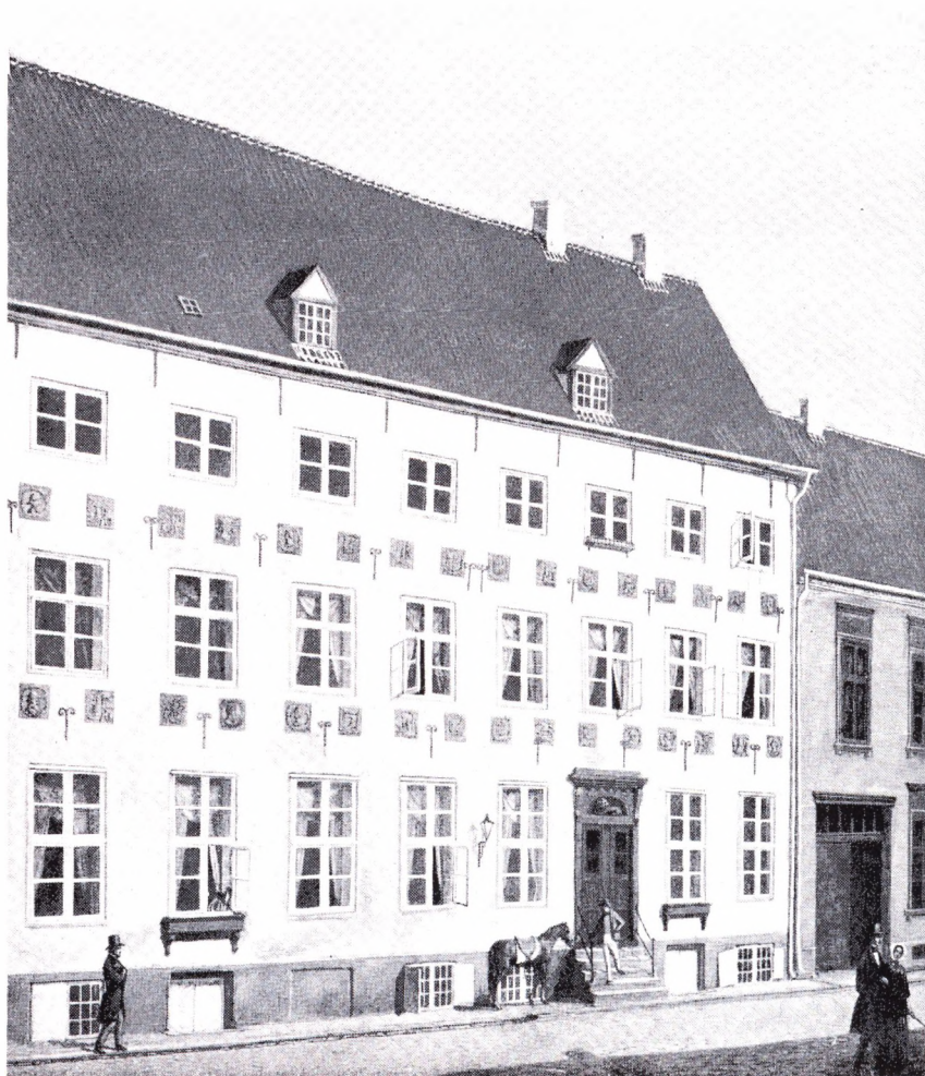
Løveapoteket i Overgade, som det tog sig ud ved apotekerkiftet i 1853, hvor Ernst Gustav Lotze købte apoteket af Jannik Andersen. Allerede samme år gik Lotze i gang med ombygningsarbejder og ændrede bl.a. facaden ud mod Overgade (E. Dam: Odense Løveapoteks historie).
