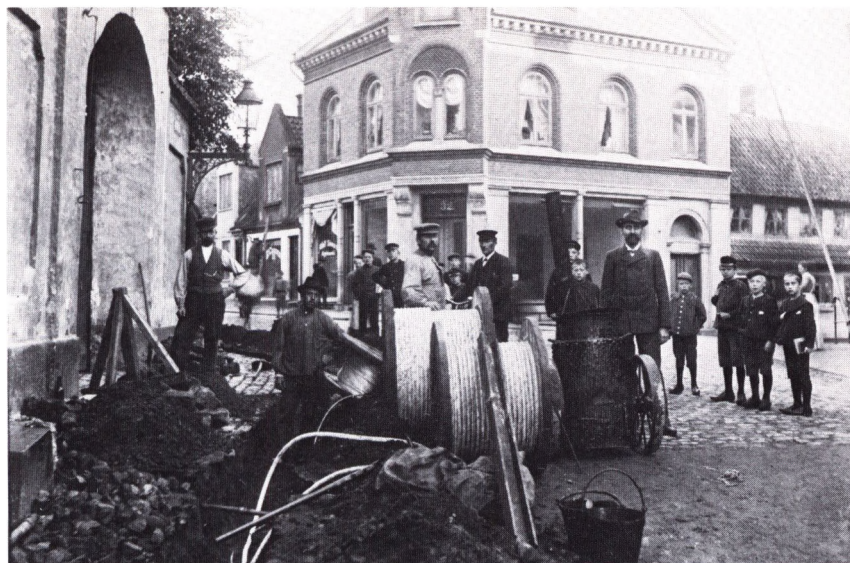
Der lægges elkabler i Klaregade ved Hørsertorvet, formentlig i forbindelse med åbningen af byens elektricitetsværk på Klosterbakken i 1908 (Møntergården).
