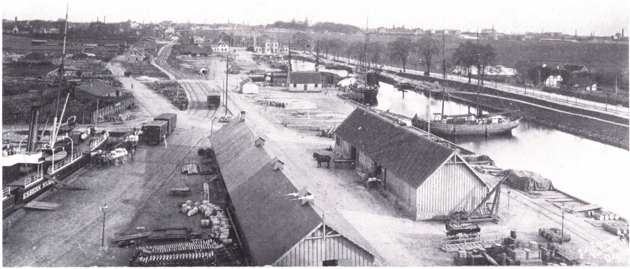
Fra havnen i Odense omkring 1895 med Kanalvej til højre i billedet (Jul. Folkmann fot., Montergården).
