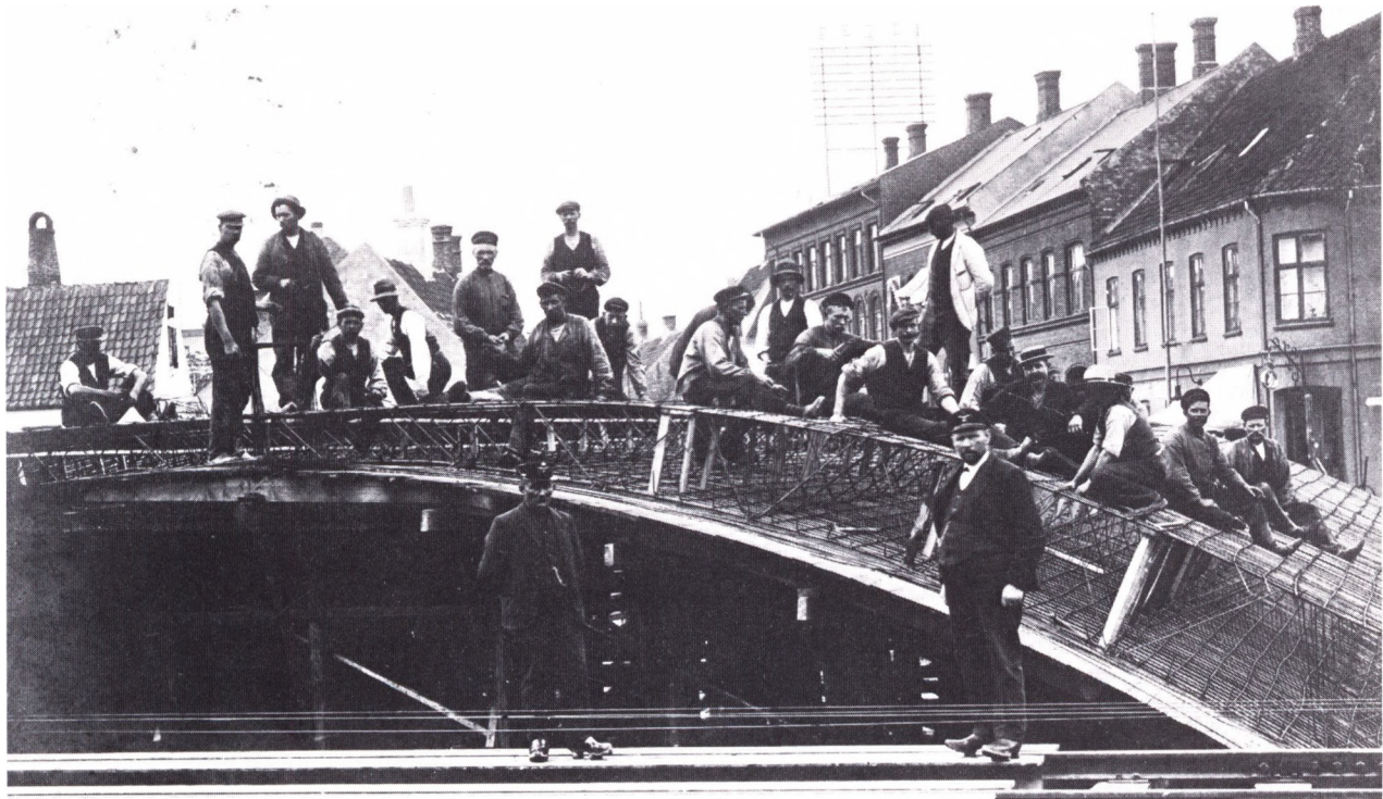
Jernbaneviadukten over Nørregade-Nørrebro under anleg ca. 1911 – tunnellen blev et trafik-kalt knudepunkt i Odense i henved 60 år (Montergården).
