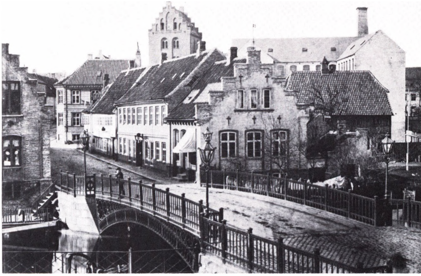
Frederiksbroen – Danmarks ældste vejbro af støbejern – fotograferet omkring 1880. De høje bygninger i baggrunden er Dorchs Klædefabrik, der efter lukningen indrettedes til Teknisk Skole. Skolen kunne tage bygningerne i brug 1879 (Møntergården).
