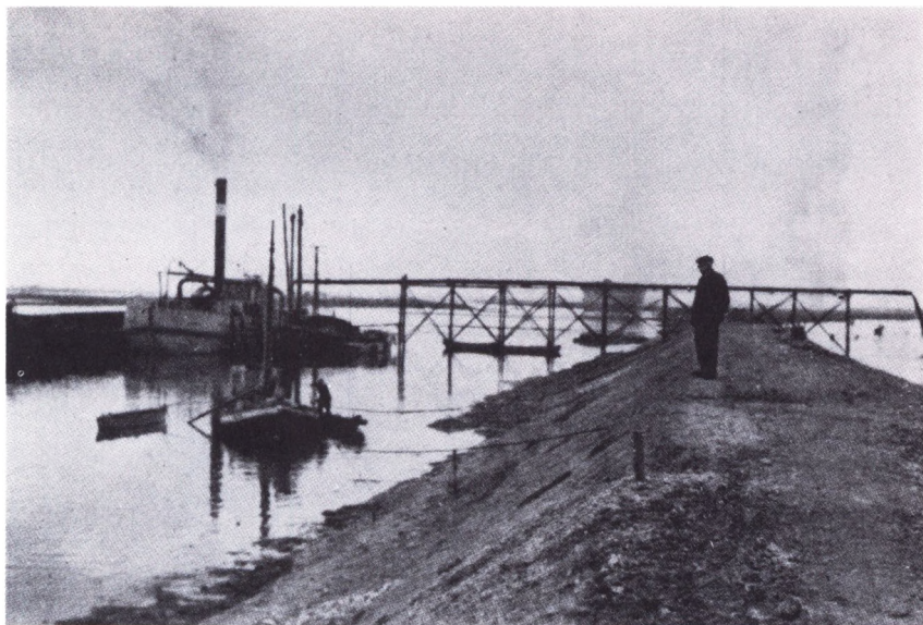
Fra inddæmningsarbejderne ved Lumby Strand. (H. Fischer-Hansen fot.).
