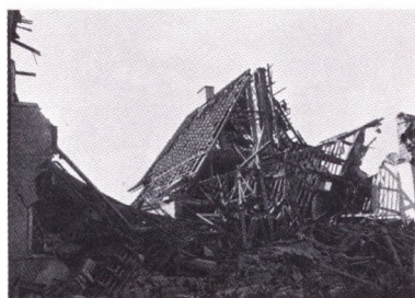
Konsul Haustrups villa, Skovløkke, før og efter ødelæggelsen.
