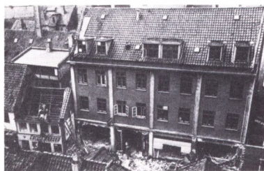
I.G. Jacobsens ejendom og Strøgpasagen efter schalburgtagen. (Rigspolitiets tekniske afdeling fot. og Nørmark fot., Møntergården).
