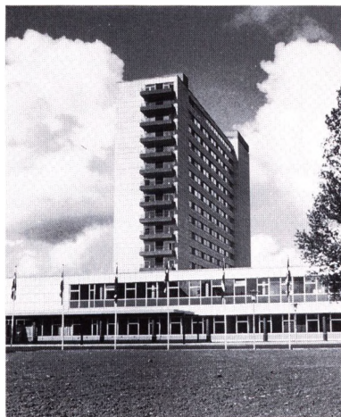
Odense sygehus blev udvidet kraftigt i 1962. Højhuset og den lave bygning foran har endnu ikke fået parkeringsplads ved hovedindgangen (Odense sygehus' historiske arkiv).
