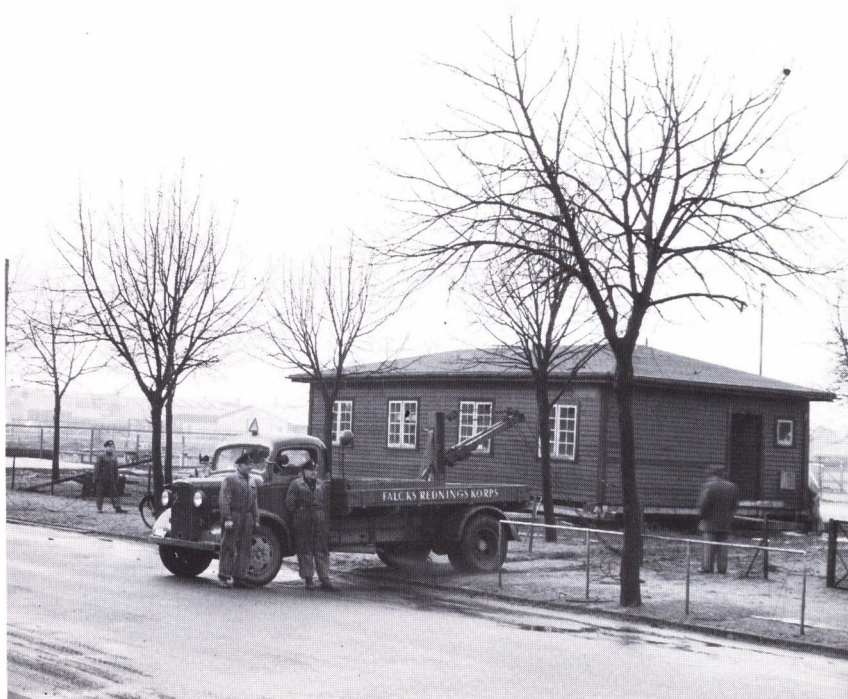
Spejdernes trofshus ved Grønløkkevej under flytning i januar 1951 (Ditlev Jensen fot., Magistratens 2. afdeling, Vej- og spildevandsafdelingen).
