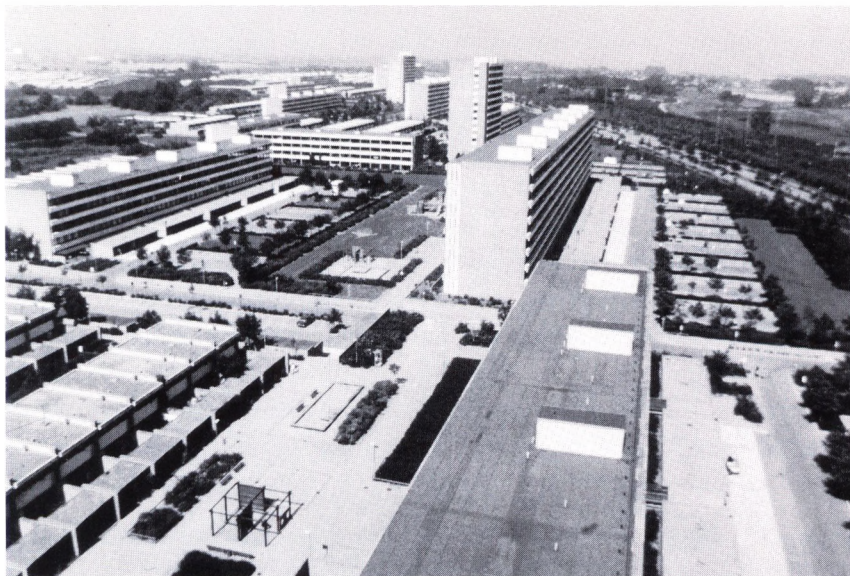
Udsigt over en del af byggeriet langs Vollsrose Allé (Odense Centralbibliotek, Lokalhistorisk Afdeling).
