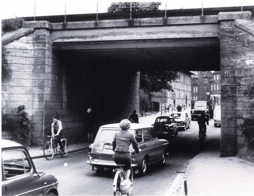
Situation fra Grønlandsgadetunnelen juni 1964. Billedet er taget før tunnelens udvidelse og viser de trafikale problemer på stedet (Magistratens 2. afdeling, Vej- og spillevandsafdelingen).
