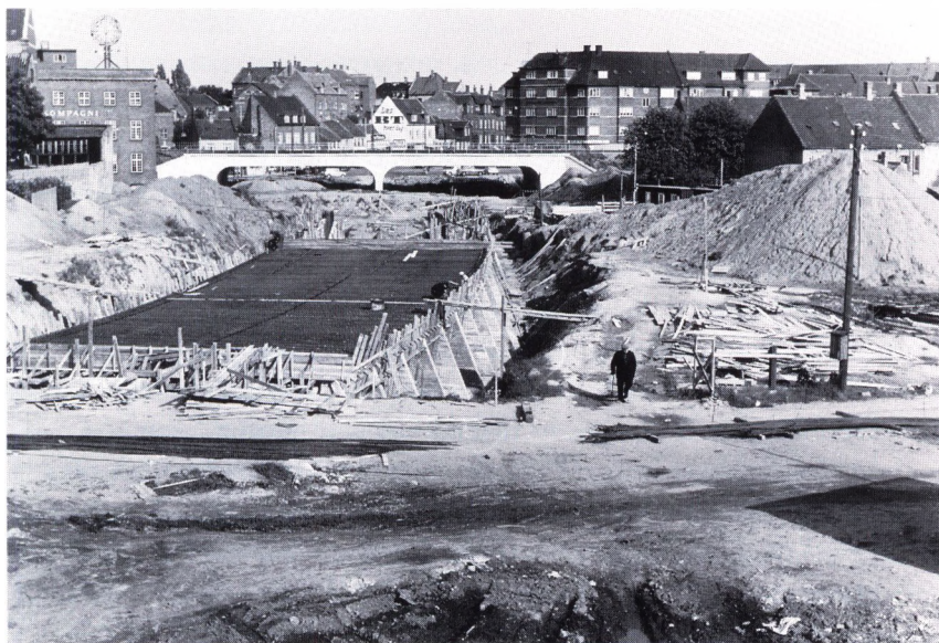
Et rent månelandskab – fra anlæggelsen af Thomas B. Thriges Gade-underkørslen. Billedet er fra september 1961 (Magistratens 2. afdeling, Vej- og spilverandsafdelingen).
