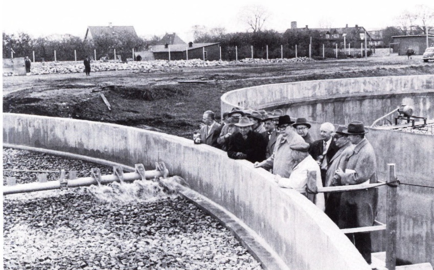
Rensningsanlægget ved Ejby Mølle besigtiges 7. november 1956. Med den mørkeste hat ses borgmester Werner (Ditlev Jensen fot., Odense Centralbibliotek, Lokalhistorisk Afdeling).
