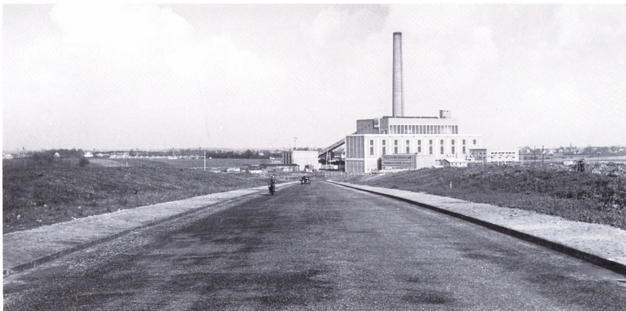
Fynsværket ved Odense kanal, som det så ud lige efter indvielsen i 1953 (Ditlev Jensen fot., Magistratens 2. afdeling, Vej- og spildevandsafdelingen).
