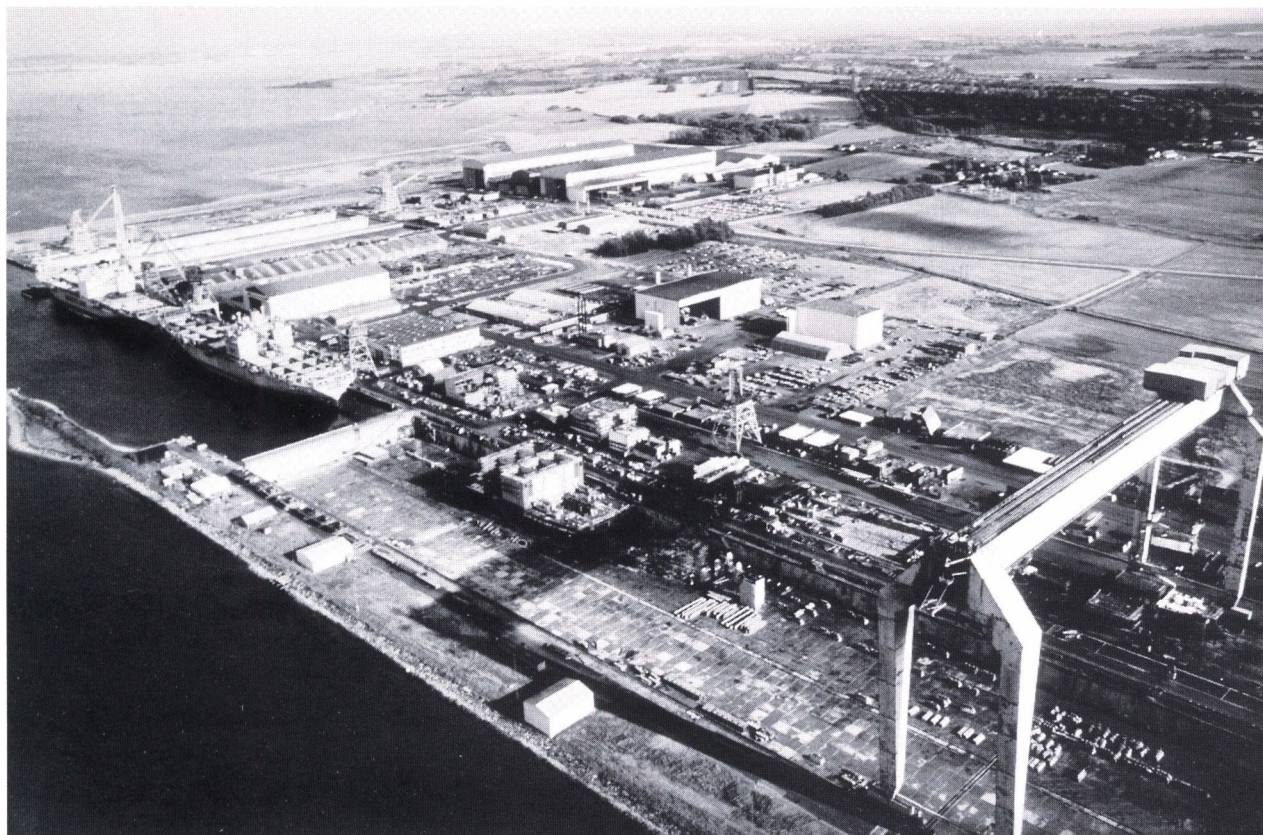
Lindøværftet ved Munkebo, anlagt i slutningen af 1950'erne. Nederst i billedet ses den cirka 100 meter høje portalkran med en løfteevne på op til 800 tons (Odense Centralbibliotek, Lokalhistorisk Afdeling).
