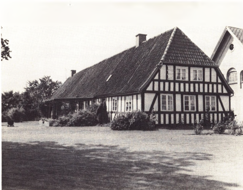
Matr. nr. 3 a i Skovshøjrup (Skovgården), hvis velholdte bindingsværkstuehus er opført 1801 (Fot. Jørn Andersen).
