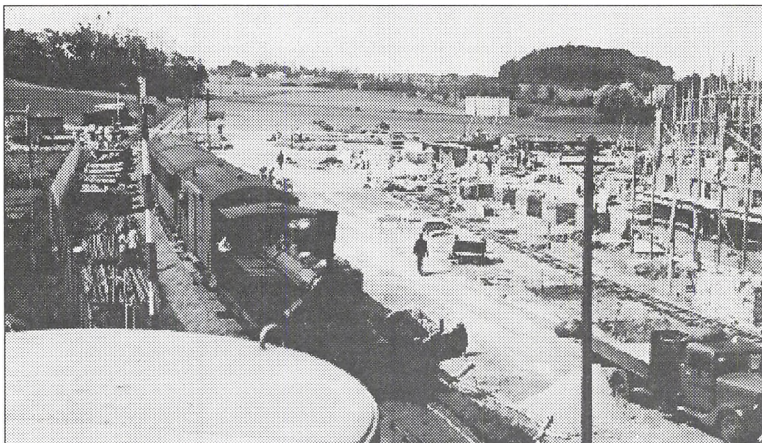
"Odder- ekspressen" kører gennem byggepladsen den 9. juni 1941.
