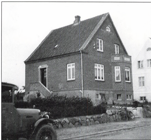
Huset på Bernstorffsvej i starten af 1930'erne. Taget er repareret. Der kom nemlig en skypumpe forbi. Loftetagen blev understøttet af en jernbjælke, som senere viste sig at være en glimrende tv-antenne. Den vendte direkte mod Søsterhøj. De mange sten på grunden er brugt til gærden ud mod vejen.
