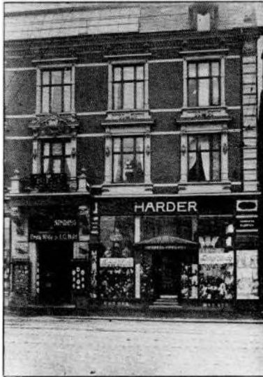
St. Torv Nr. 1, Façade mod Torvet.
