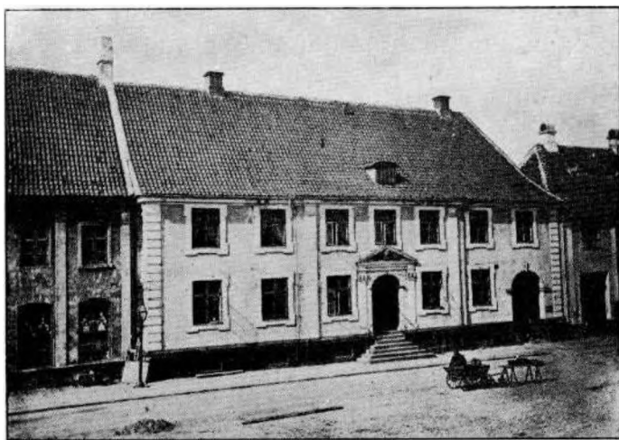
Løveapoteket før Ombygningen.
