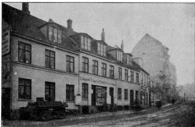
• Høegh Guldbergsgade Nr. 29a og b, m. f.
