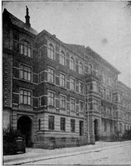
Høegh Guldbergsgade Nr. 55, 57 og 59.
