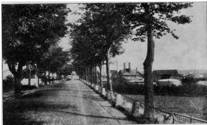
Silkeborg Landevej ind mod Aabyhøj. Tilhøre Vand- Gas- og Elektricitetsværket.
