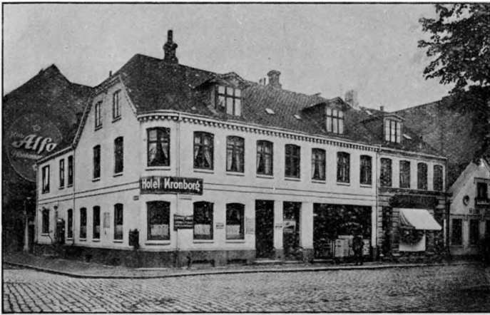
Frederiksgade Nr. 84-86, Hj. af Vesteralle.
