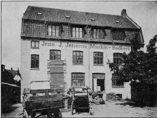
Fabriksbygningen bag Frederiksalle Nr. 140-142.
