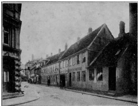
Studsgade Nr. 16, 18, 20 og 22.
