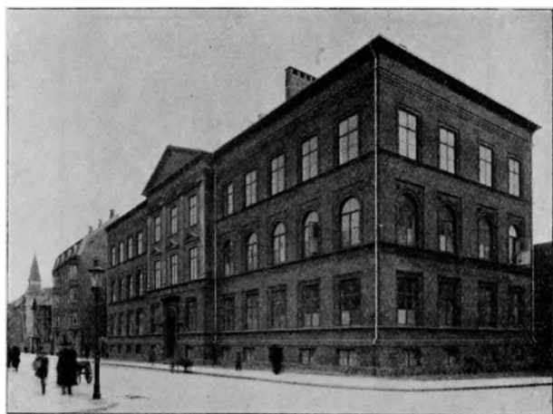
Nørre Alle Nr. 31, Hj. af Munkegade. Teknisk Skole.
