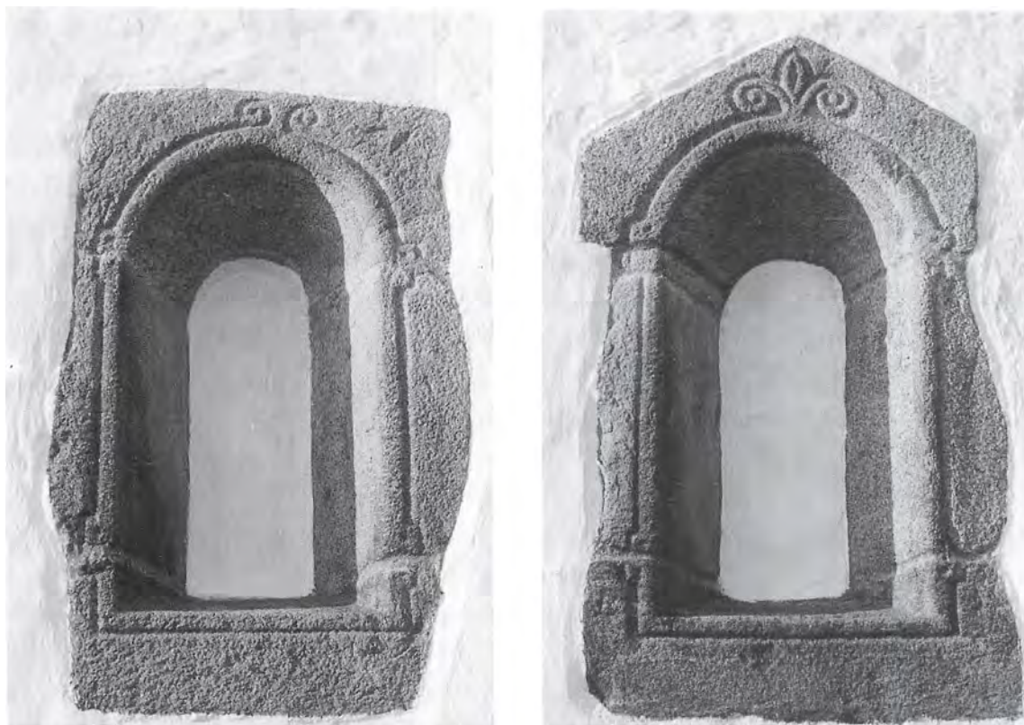
Fig. 10-11. Romanske vinduer i skibets nordside (s. 1655). NJP fot. 1987. – Romanische Fenster in nördlicher Langhauswand.
