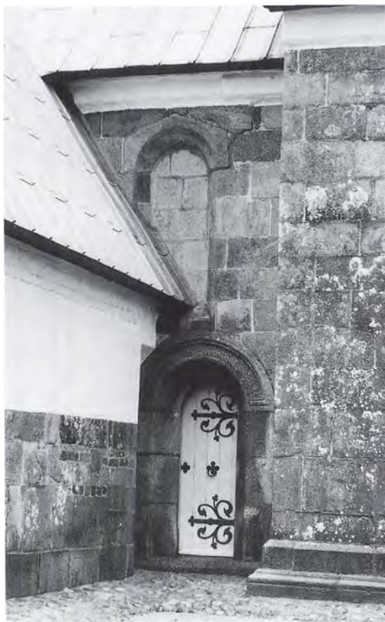
Fig. 12. Korets nordside mellem sakristi og skib med præstedør og tilmuret vindue. NE fot. 1982. – Nördliche Chorseite zwischen Sakristei und Langhaus mit Priestertür und zugemauertem Fenster.
