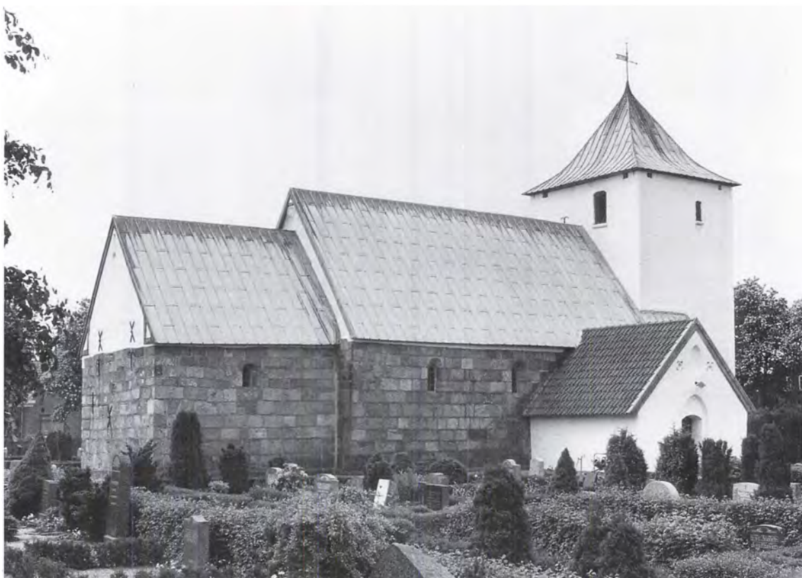
Fig. 2. Kirken set fra nordøst. NE fot. 1983. – Nordostansicht der Kirche.
