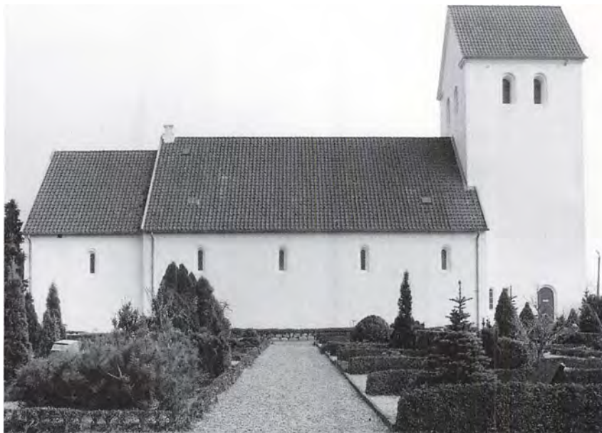
Fig. 3. Kirken set fra nord. NE fot. 1988. – Nordansicht der Kirche.
