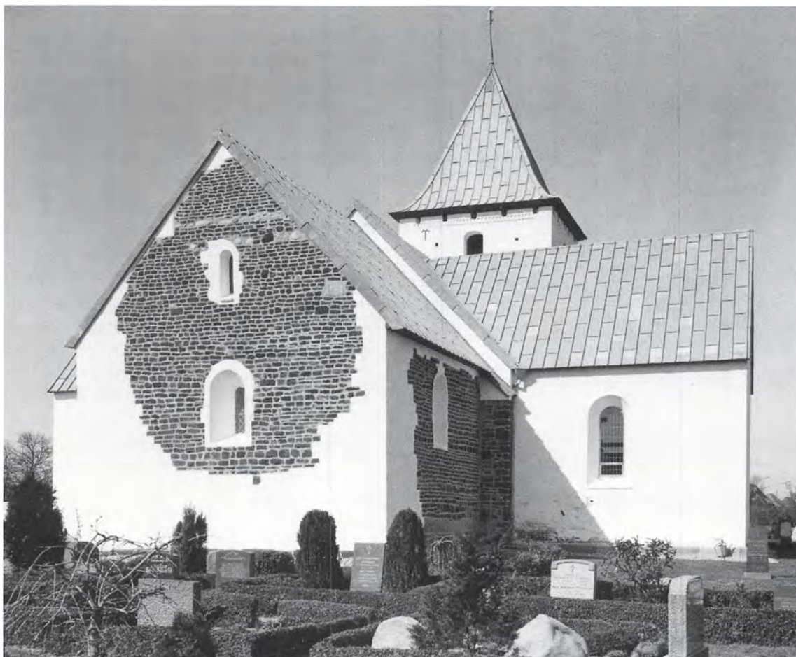
Fig. 6. Kirken set fra nordøst. NE fot. 1982. – Nordostansicht der Kirche.
