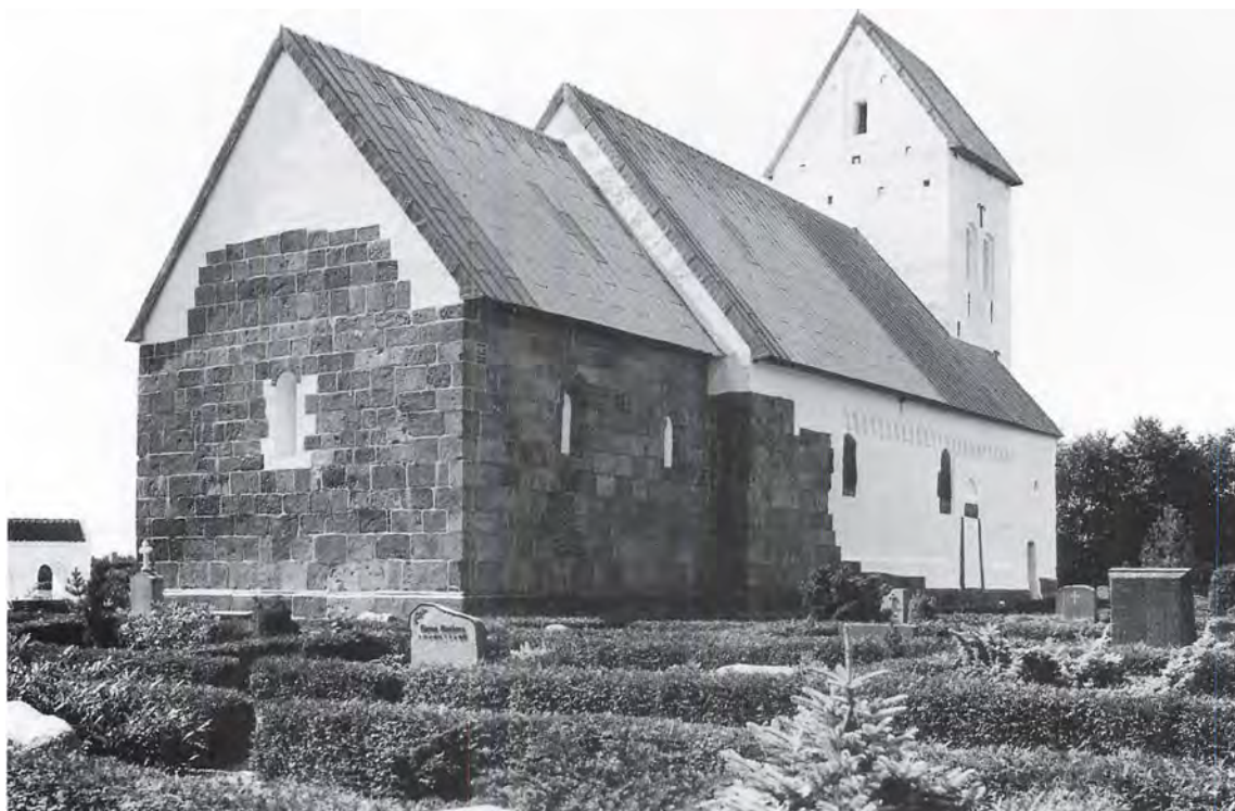
Fig. 9. Kirken set fra nordøst. NE fot. 1982. – Nordostansicht der Kirche.
