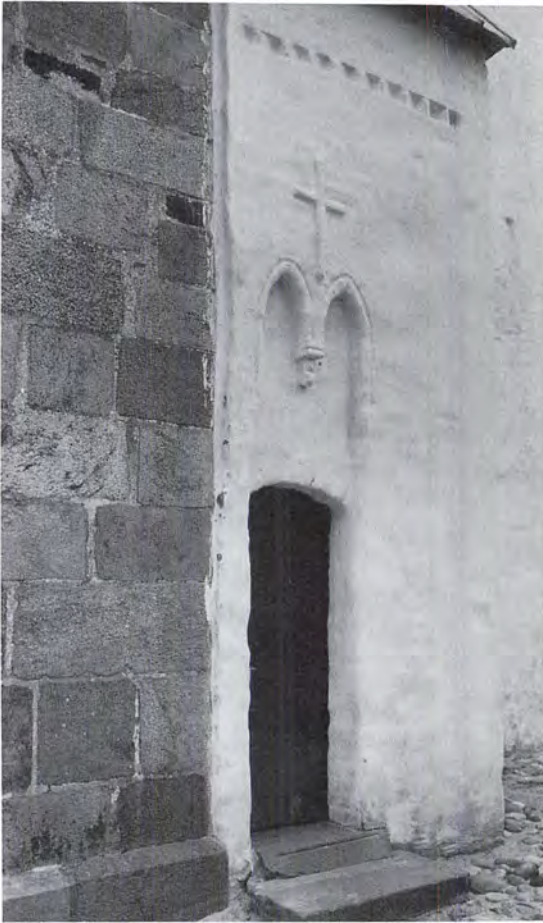
Fig. 11. Tårnets trappehus (s. 1757). NE fot. 1984. – Turm, Treppenhaus.
