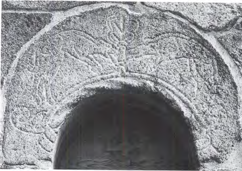
Fig. 9. Dæksten over præstedør (s. 1753). NE fot. 1984. – Sturzplatte über Priestertür.
