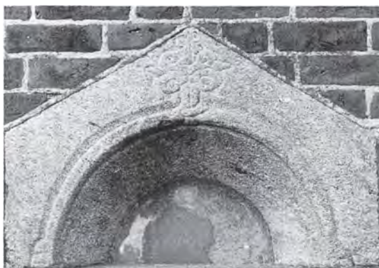
Fig. 8-9. Romanske vinduesoverligger, indmuret i tårnet (s. 1682). NJP fot. 1988. – Romanische Fensterstürze, im Turm eingemauert.
