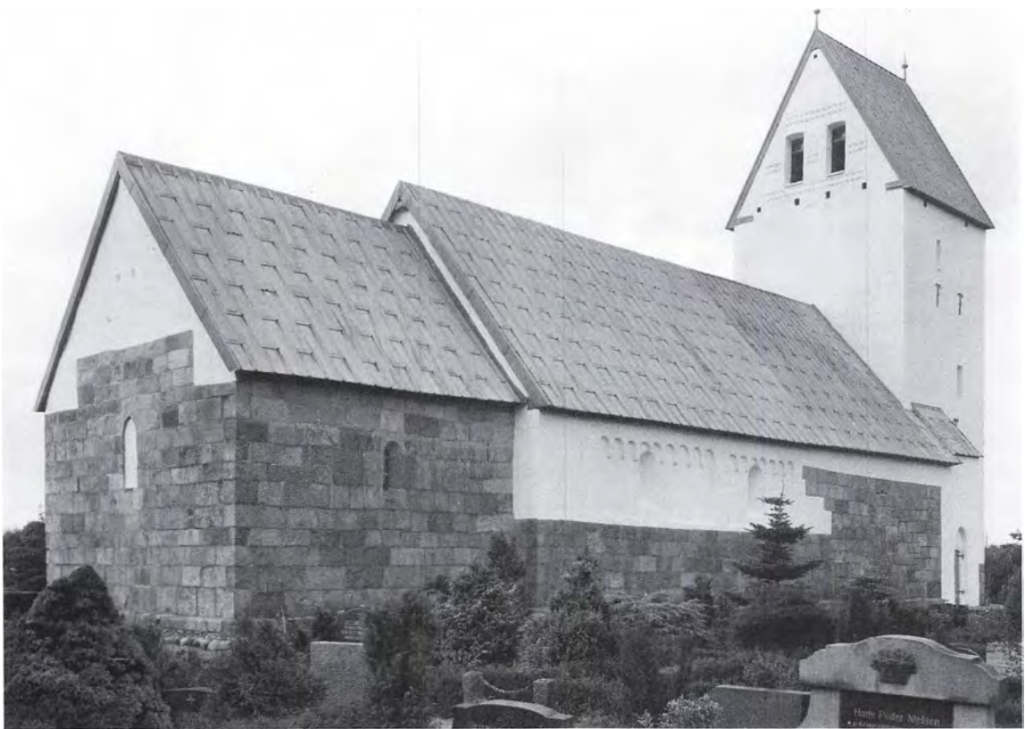
Fig. 1. Kirken set fra nordøst. NE fot. 1983. - Nordostansicht der Kirche.
