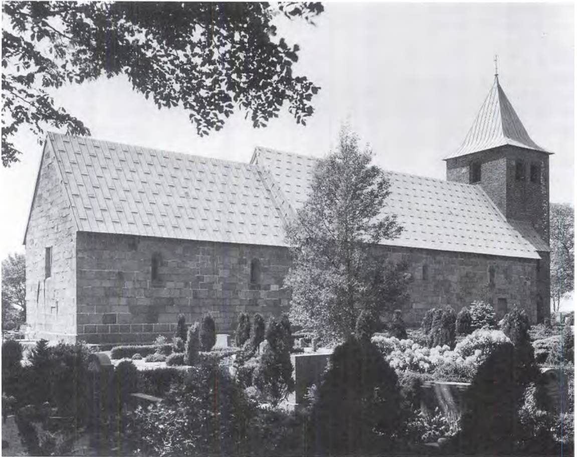
Fig. 11. Kirken set fra nordøst. NE fot. 1983. – Nordostansicht der Kirche.
