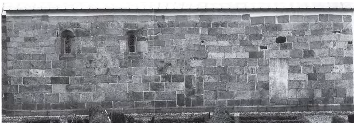
Fig. 4. Skibets nordfacade med romansk vestforlængelse og to dørsteder (s. 1754). To sammenstykkede fotos ved NJP 1988. – Schiffsnordwand mit romanischer Westverlängerung und zwei Eingängen.
