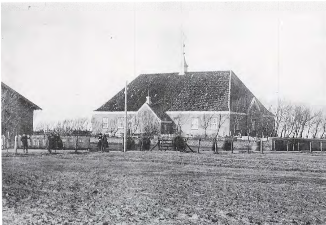
Fig. 7. Kirken set fra sydøst, i tiden mellem 1889 og 1896. Foto i NM. – Südsicht der Kirche in der Zeit zwischen 1889 und 1896.
