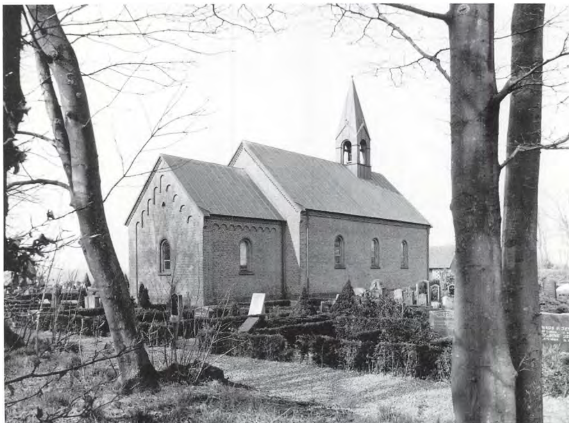
Fig. 1. Kirken set fra nordøst. NE fot. 1988. – Nordostansicht der Kirche.
