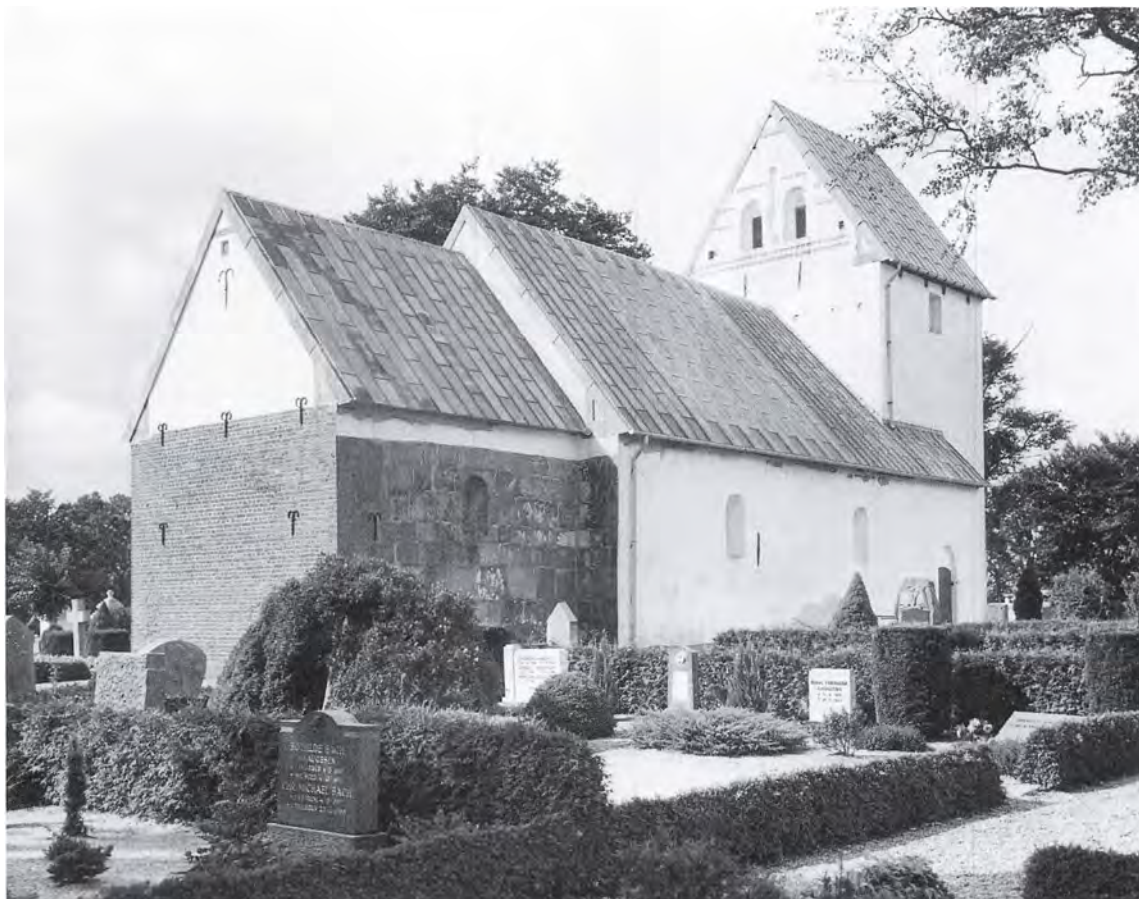
Fig. 13. Kirken set fra nordøst. NE fot. 1982. – Nordostansicht der Kirche.
