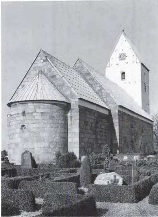
Fig. 11. Kirken set fra nordøst. NE fot. 1982. – Nordostansicht der Kirche.
