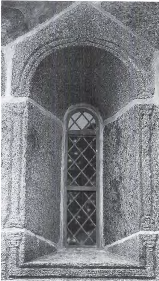
Fig. 6. Romansk vindue i korets nordmur (s. 1753). NE fot. 1984. – Romanisches Fenster in nördlicher Chorwand.
