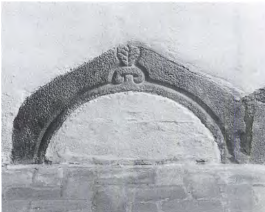
Fig. 22-23. Romanske vinduesoverligger, indmuret i sakristiets vestvæg. 22. Fra koret (s. 1919). 23. Fra skibet (s. 1925). NE fot. 1982. – Romanische Sturze, in westlicher Sakristeiwand eingemauert.
