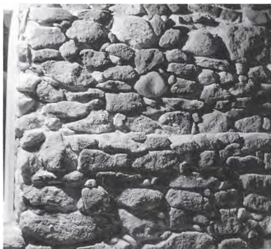
Fig. 8. Skibets østre taggavl, set fra vest. Sandal og marksten (s. 1604). NJP fot. 1987. – Östlicher Dachgiebel des Langhauses, Westansicht. Ortstein und Feldstein.
