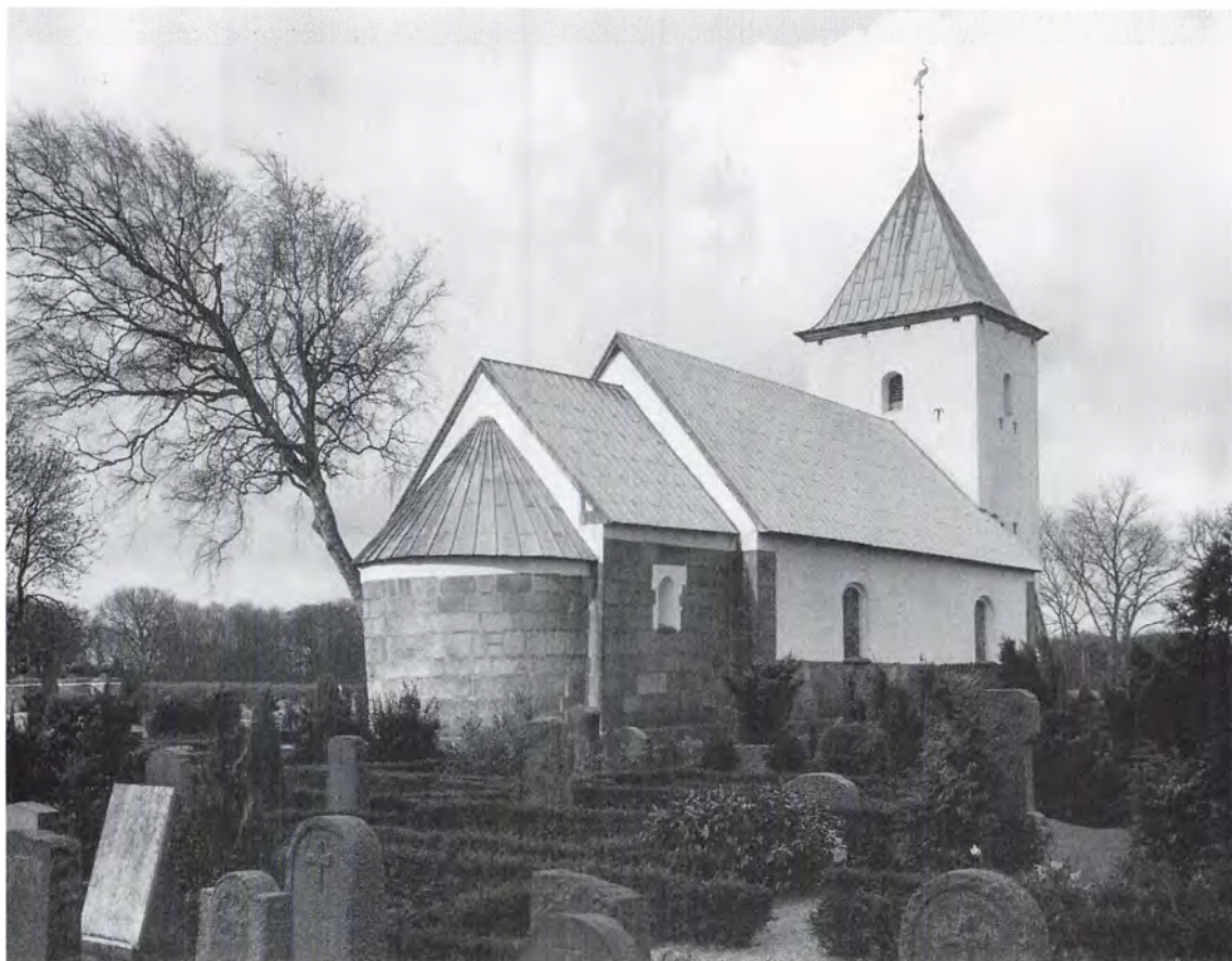
Fig. 5. Kirken set fra nordøst. NE fot. 1982. — Nordostansicht der Kirche.
