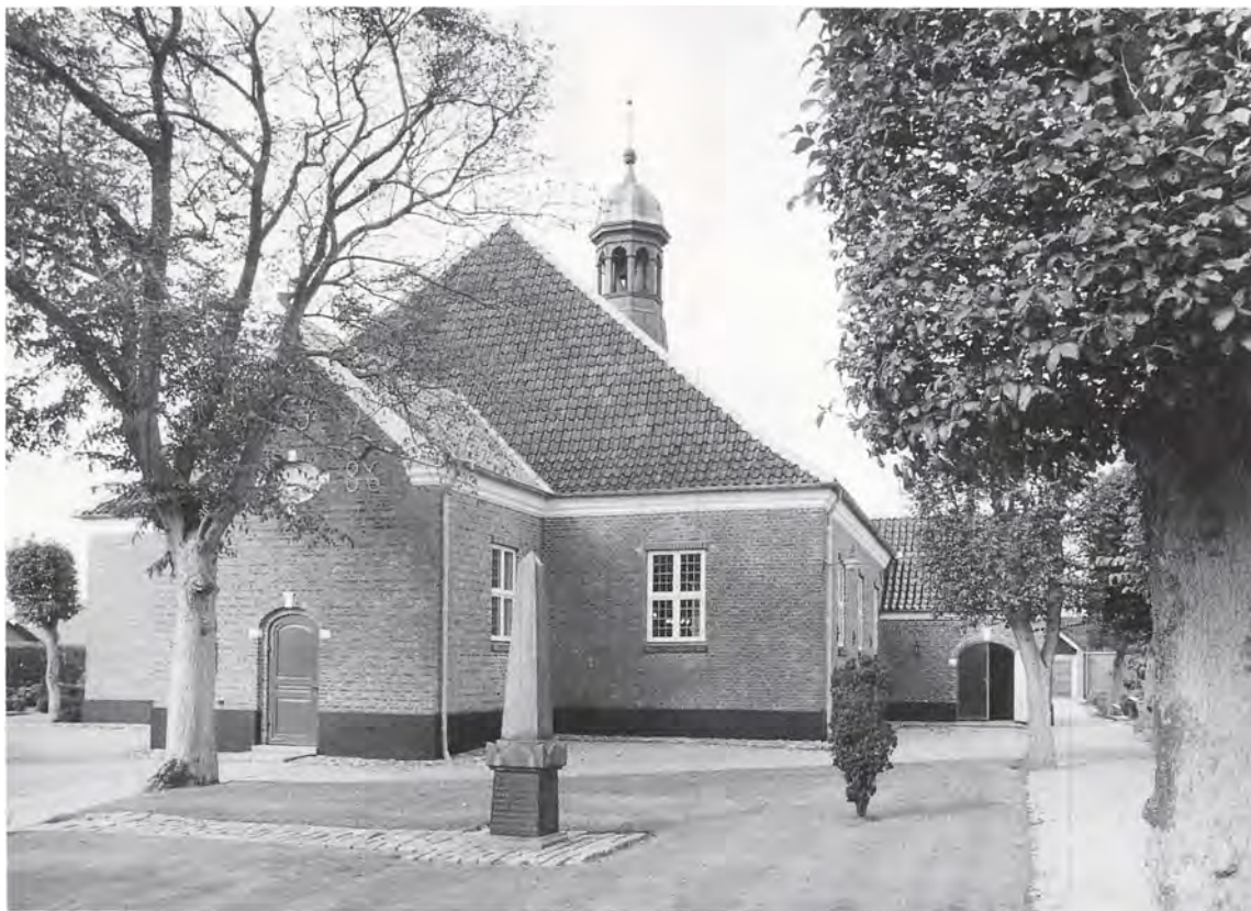
Fig. 5. Kirken set fra nordøst. NE fot. 1984. – Nordostansicht der Kirche.
