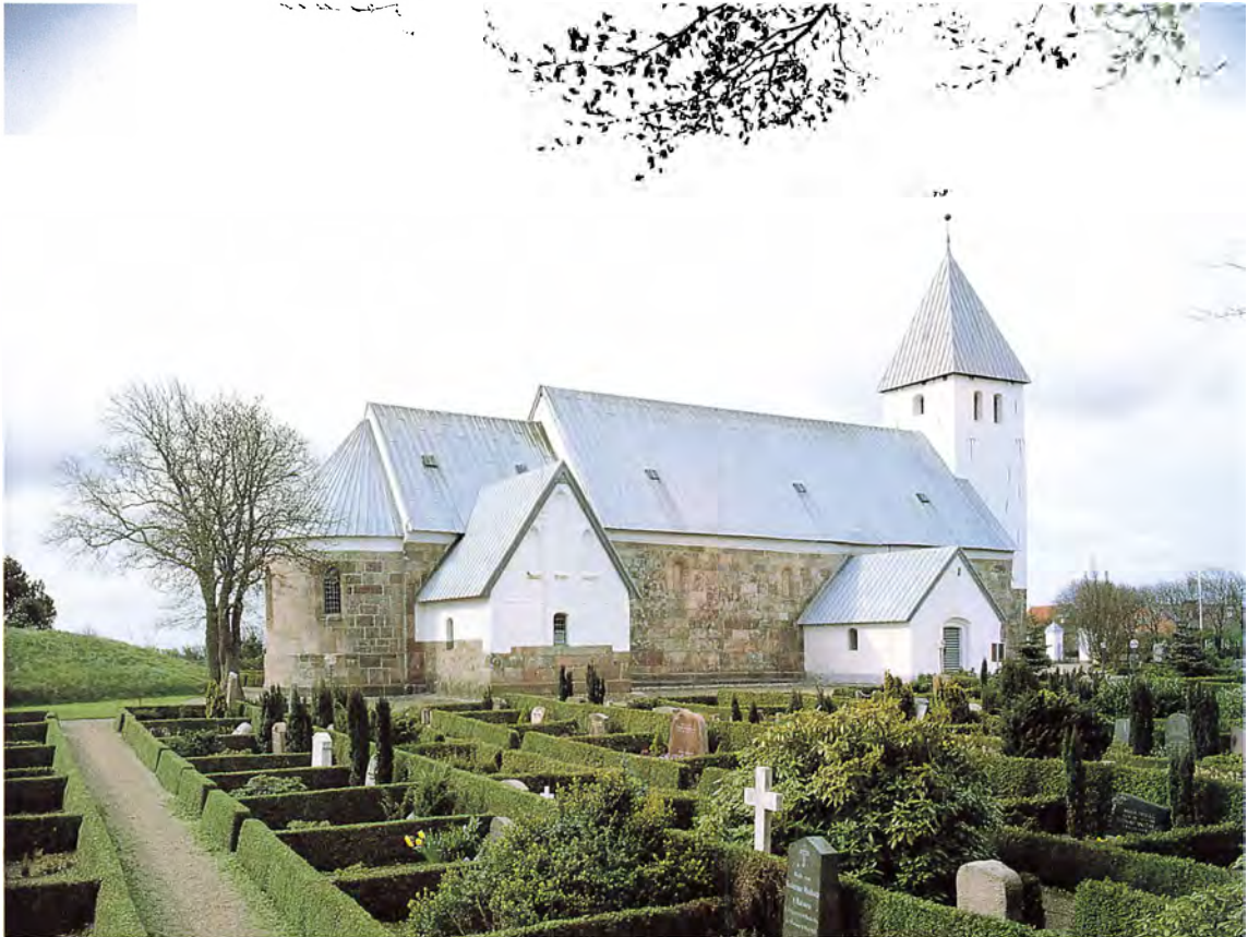
Fig. 1. Kirken set fra nordøst. NE fot. 1989. – Nordostansicht der Kirche.
