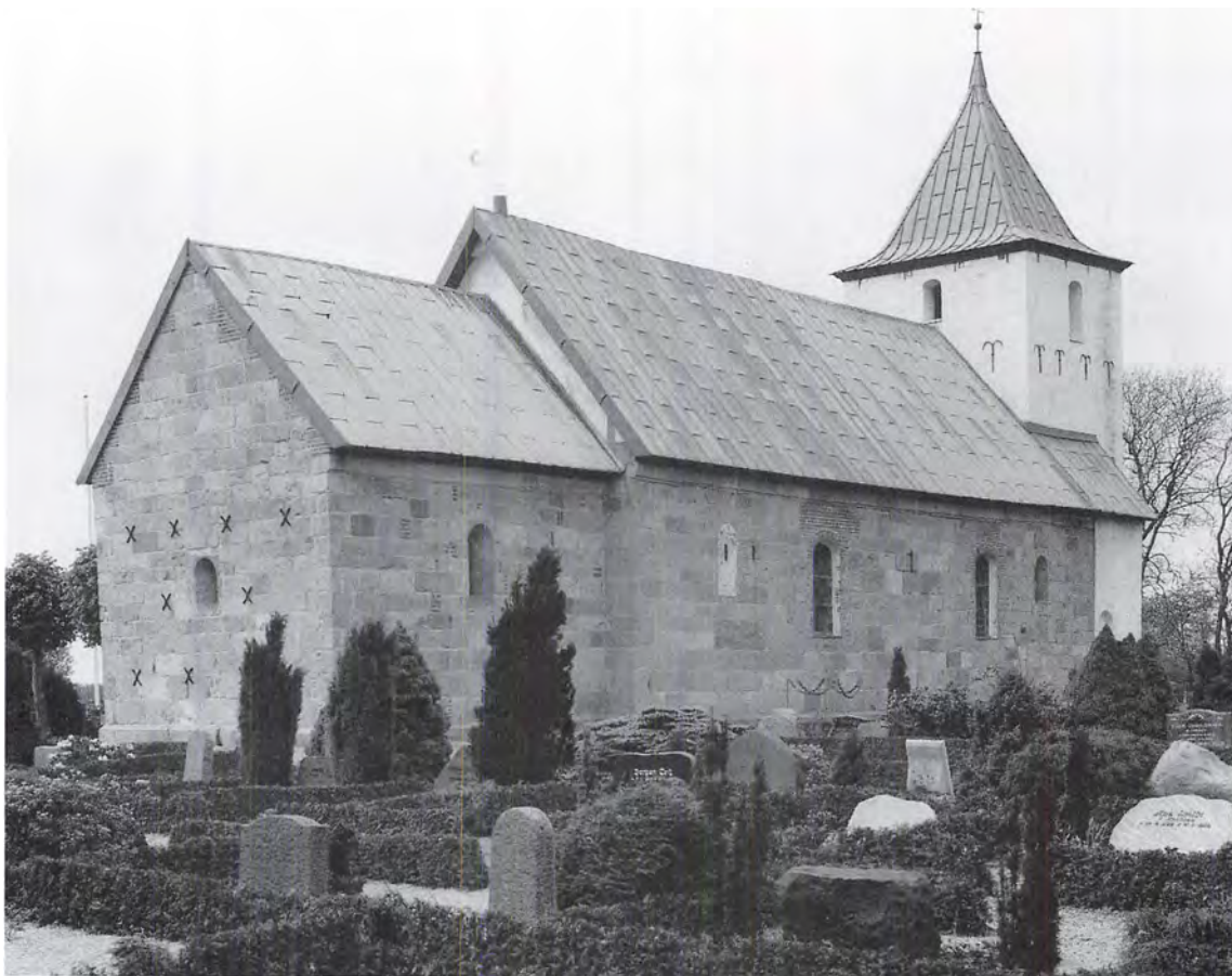
Fig. 11. Kirken set fra nordøst. NE fot. 1986. – Nordostansicht der Kirche.
