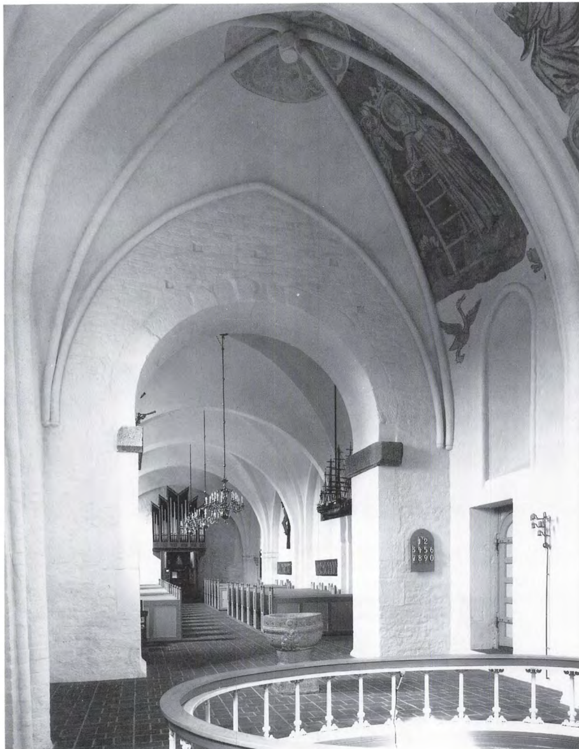
Fig. 15. Korpartiet med korbuen set mod vest. NE fot. 1989. – Westansicht des Chors mit Triumphbogen.
