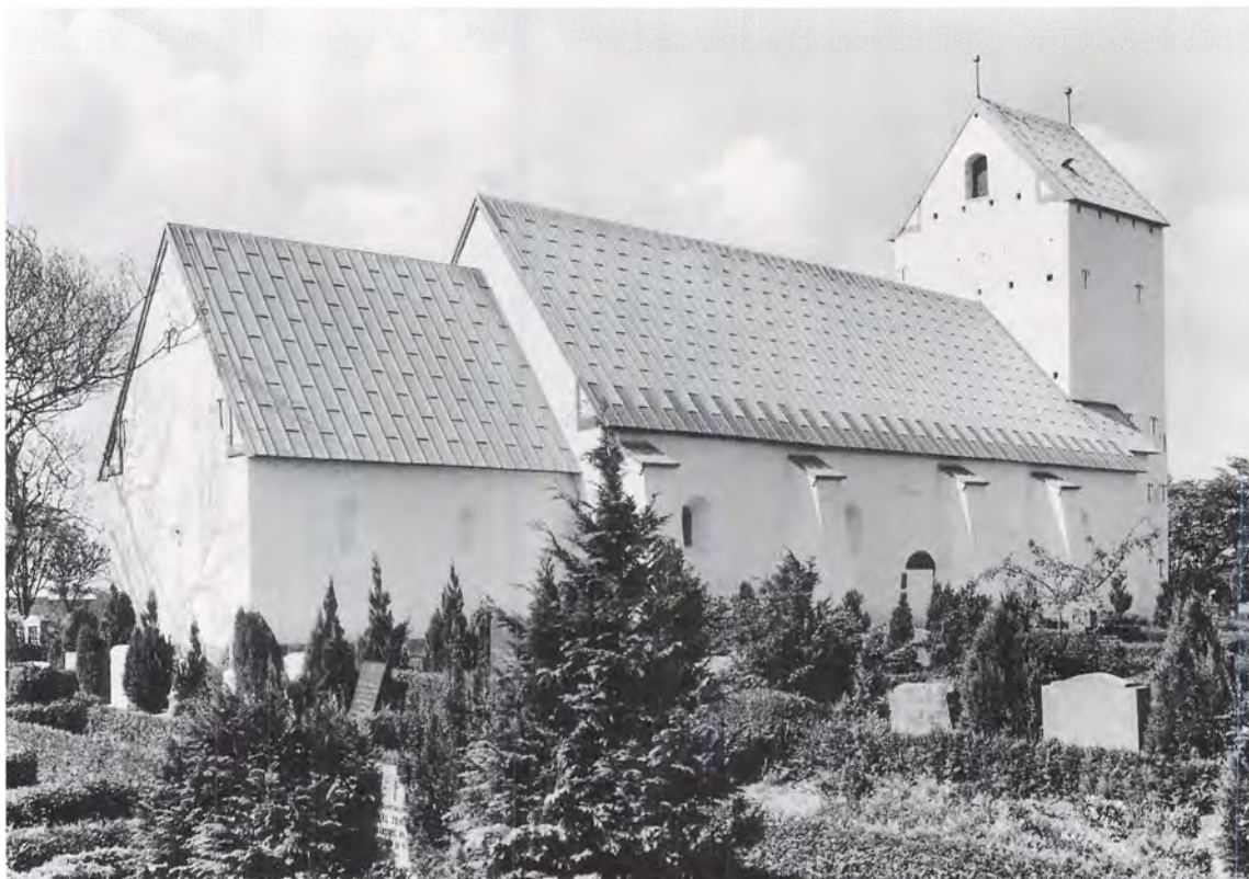
Fig. 10. Kirken set fra nordøst. NE fot. 1986. – Nordostansicht der Kirche.
