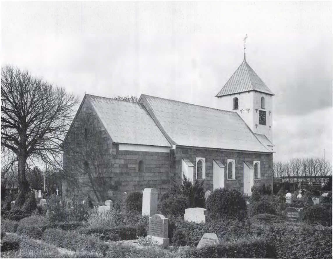
Fig. 2. Kirken set fra nordøst. NE fot. 1982. — Nordostansicht der Kirche.
