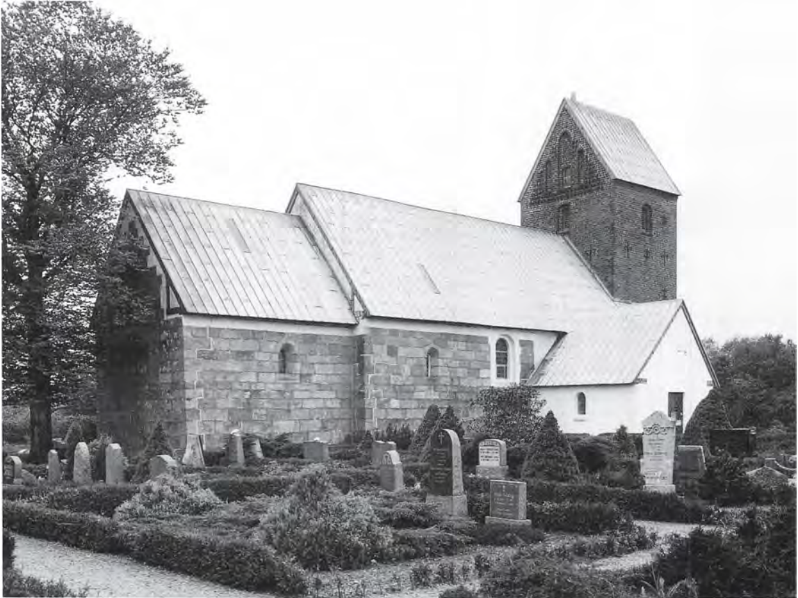
Fig. 1. Kirken set fra nordøst. NE fot. 1984. – Nordostansicht der Kirche.
