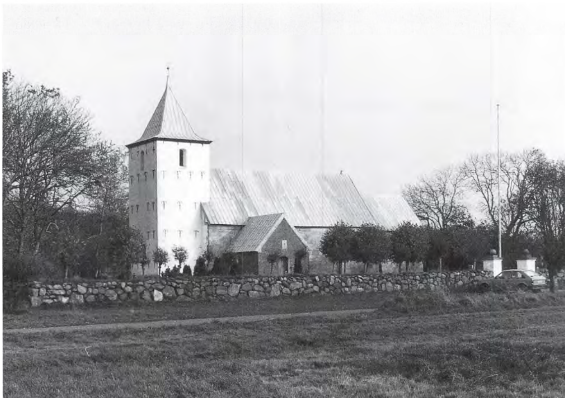
Fig. 1. Kirken set fra sydvest. NJP fot. 1988. – Südwestansicht der Kirche.
