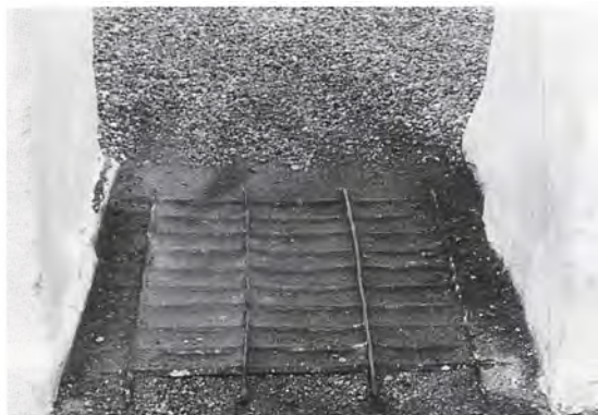
Fig. 4. Kirkerist i kirkegårdens østre portal (s. 2057). NJP fot. 1990. – Roste am östlichen Friedhofsportal.
