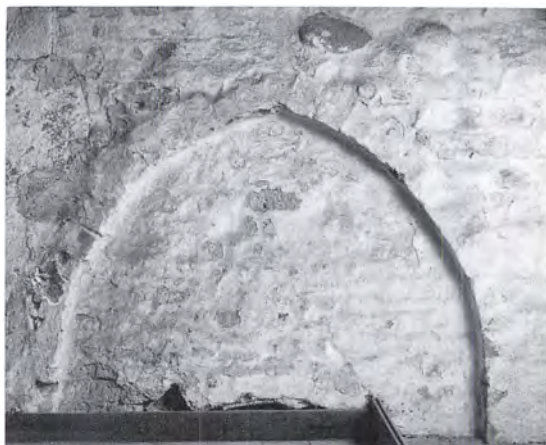
Fig. 12. Spidsbuet spejl over skibets syddør, set fra våbenhusloftet (s. 1783). NE fot. 1989. – Spitzbogen über Südeingang des Langhauses. Blick von Vorhalledachboden.
