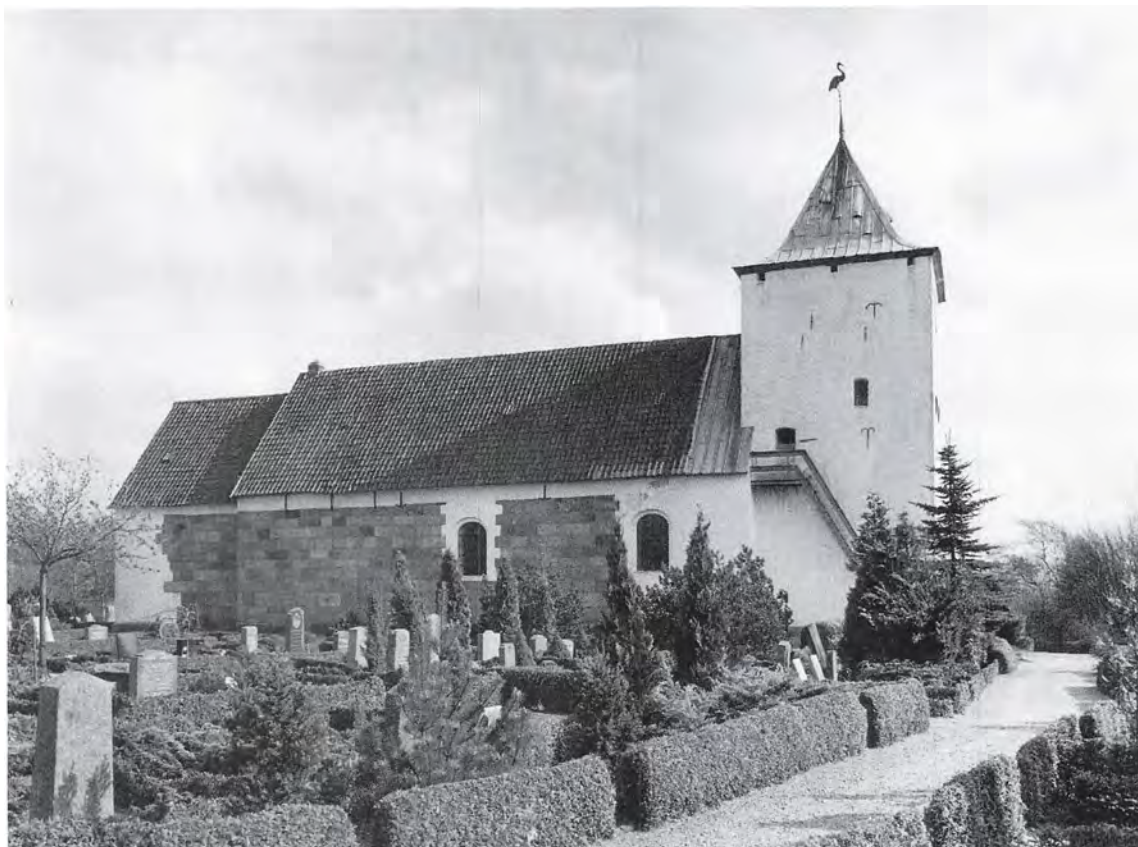
Fig. 7. Kirken set fra nordvest 1982, mens den endnu var tækket med både bly og tegl. NE fot. — Nordwestansicht der Kirche mit Dachdeckung 1982: Blei- und Ziegeldach.
