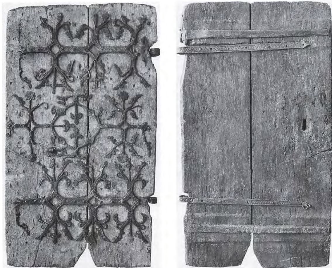
Fig. 29a-b. Dørfløj, middelalderlig, tilstand før restaurering 1952 (s. 1700). a. Forside med jernbeslag. b. Bagside. LL fot. 1949. – Türflügel, mittelalterlich, Zustand vor der Restaurierung 1952. a. Vorderseite mit Eisenbesläge. b. Rückseite.
