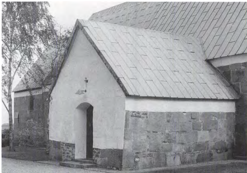
Fig. 12. Väbenhuset set fra nordvest. NJP fot. 1987. – Vorhalle, Nordwestansicht.
