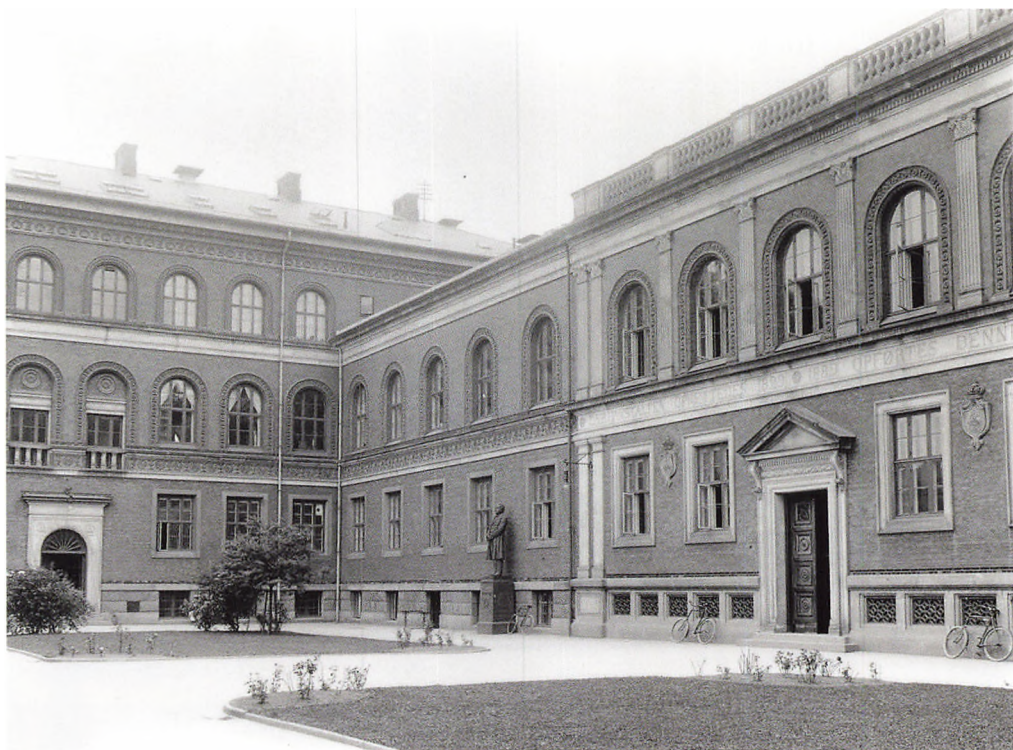
Polyteknisk Læreanstalt. Gården ved Sølvtorvet. (Da jeg første gang kom der i 1958, syntes jeg, at det lignede et fængsel! – JES). Foto modtaget fra Teknologihistorie. (DTU)
