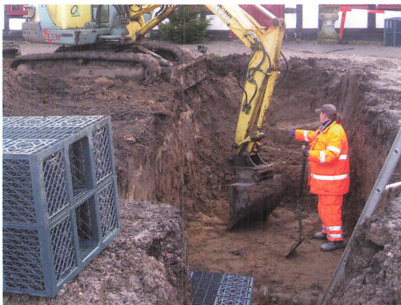
Kloakfirmaet i færd med at renovere Mothsgårdens kloaksystem. De grønne plastkasser nedgraves og fungerer som faskine.
