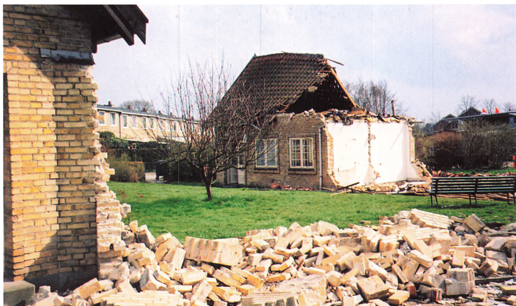
Nedrivningen af ældreboligerne på Byageren i sommeren 2008 blev dokumenteret af Jørgen Berg mellem den 3. juni og 8. juli 2008. (Historisk Arkiv for Rudersdal Kommune = HA)
