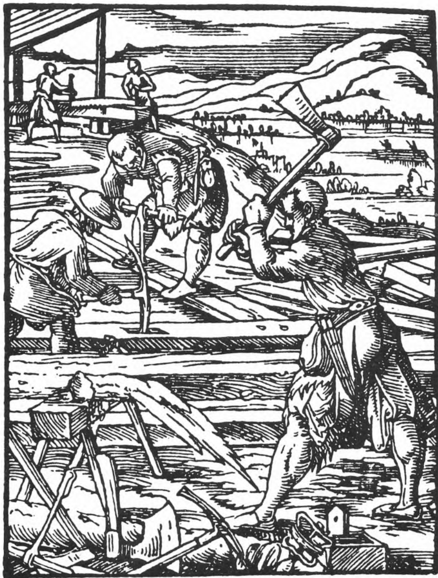
Tomverren. Træsnit af Joost Amman i: Beschreibung aller Stände . Frankfurt 1568. Forskellige okse-typer er i anvendelse: Forrest anvendes bindoksen, mens svenden bagved er ved at hugge et taphul med krydsoksen. Den tredje svend borer et hul med naverboret, mens to svende i baggrunden arbejder med skorsaven. I forgrunden ligger et naverbor, en bindokse, en bredbil og en krydsokse. Ved værktøjskassen ligger et vindsel med tomversnor.
