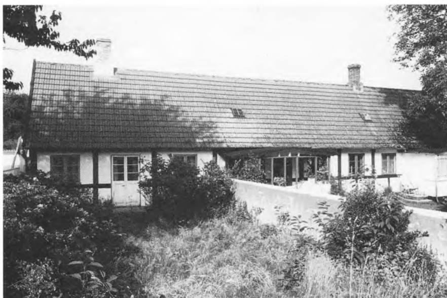
Fig. 81. Mosedalsvej 20 og 18, sydfacaden. Bygningen er opført for fisker Michael Jensen omkring midten af forrige århundrede med klinede tavl og stråtag. Den har tidligere været indrettet som ladehus, senere værksted, i vestenden. Omkring århundredskiftet rummede bygningen tre boliger og er nu opdelt på to selstændige ejendomme.
