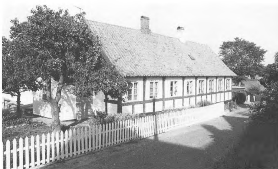
Fig. 10. Bakken 5 (i forgrunden) og Per Sørensengade 4, set fra sydvest. Huset er opført som stuelænge i en ældre avlsbrugerejendom omkring 1830 og blev omkring århundredskiftet opdelt i to boliger.
