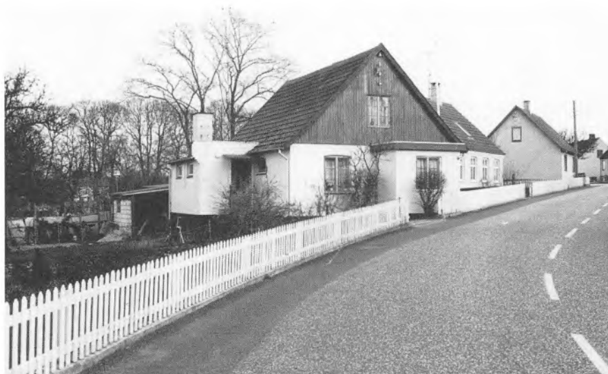
Fig. 27. Hans Thygesensvej 7 er opført af Peter Andreas Hansen i 1914. Gavlbeklædningen er af nyere dato. Førhen var der indgang i et vindfang på gavlen, hvor der nu er karnap.
