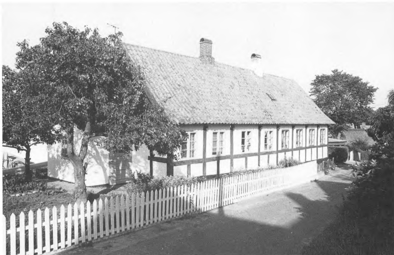
Fig. 92. Per Sørens-gade 4 udgør de fire fjer-neste fag af bindingsværksbygningen, der blev opført som stuehus til en ældre avlsbruger-ejendom omkring 1830 og har byens ældste tegltag.
