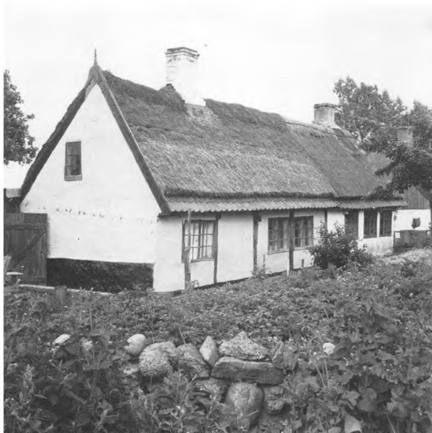
Fig. 112. Strandstien 36-40, set fra sydvest på et fotografi fra 1944. Førhen lå der endnu en lille bolig mellem nr. 38 og 40, og rækken af i øvrigt meget fine skorstenspiber har givet bebyggelsen tilnavnet Firmasteren. Den lange bygning var blevet til ved gradvis udbygning af et mindre hus, der synes at være mere eller mindre identisk med nr. 38, og som kan følges i arkivalierne tilbage til begyndelsen af 1800-tallet.
