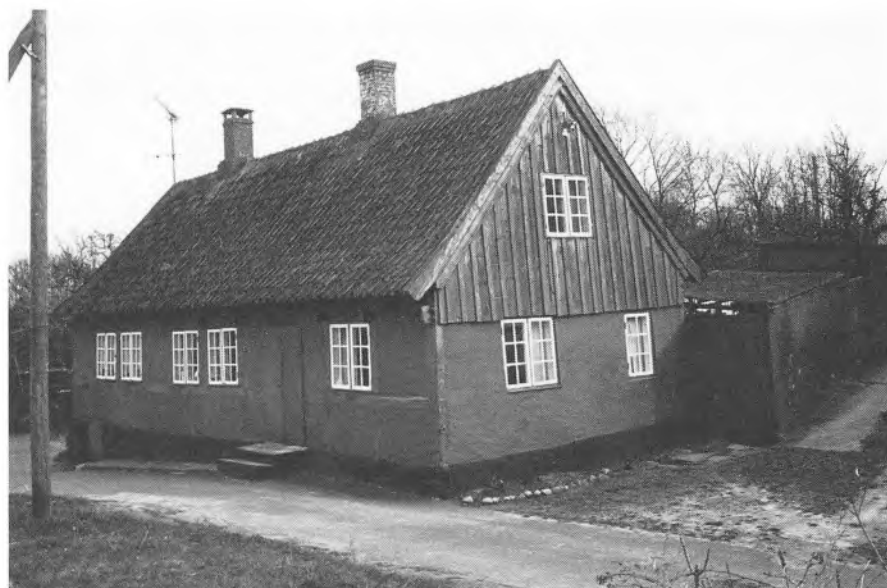
Fig. 4. Anders Monsstræde 3, set fra nord-vest. Huset er formentlig opført i 1840'erne og har tidligere stået stråtækt.
