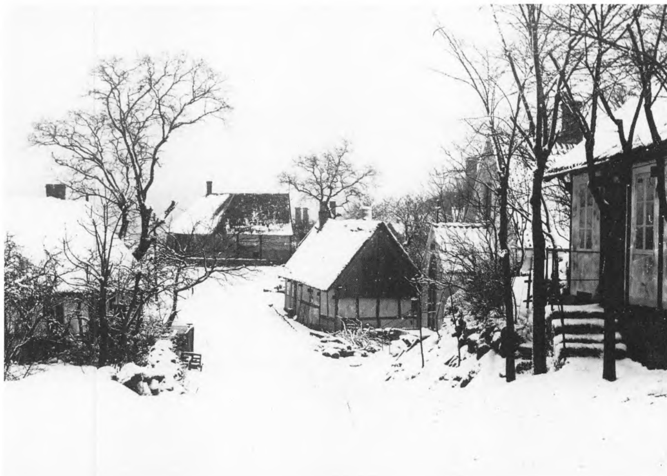
Fig. 72. På Valdemar Myhre billedet fra århundredets første årti ses i forgrunden til højre Mosedalsvej 9 med en senere nedlagt dør og trappe i østenden, sammenlign fig. 71. Bag dette ligger Missionshuset og den nu nedrevne bygning, der omtales under Mosedalsvej 1 og 3; over Missionshusets vindfang skimles røgeriskorstenen på ejendommen Brøddan 2. Vinkelbebyggelsen i baggrunden er Strandstien 2, og til venstre i billedet ses Mosedalsvej 2, der da havde indgang fra gaden i det yderste fag.
