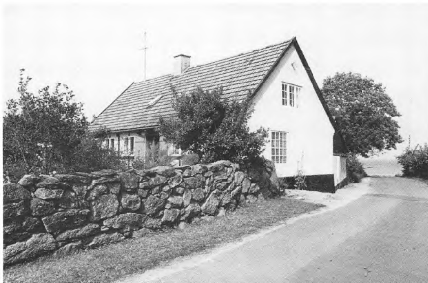
Fig. 107. Strandstien 22, set fra sydøst. Bindingsværkshuset er formentlig bygget for Hans Nielsen i begyndelsen af 1870'erne og har fra opførelsen haft grundmurede tavl og gavle, mens cementstenstaget har afløst et tidligere stråtag.
