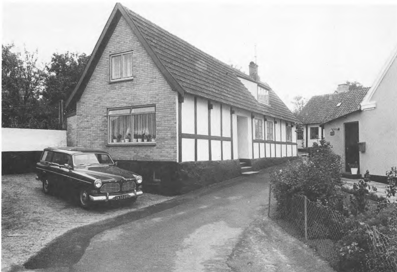
Fig. 25. Hans Thygesensvej 6 stammer formentlig i hovedtræk fra første halvdel af 1800-tallet. Det tidligere stråtag udskiftedes i begyndelsen af dette århundrede med cementsten, og gavlen har fået sin nuværende udformning i begyndelsen af 1950'erne, jævnfør hosstående fotografi.
