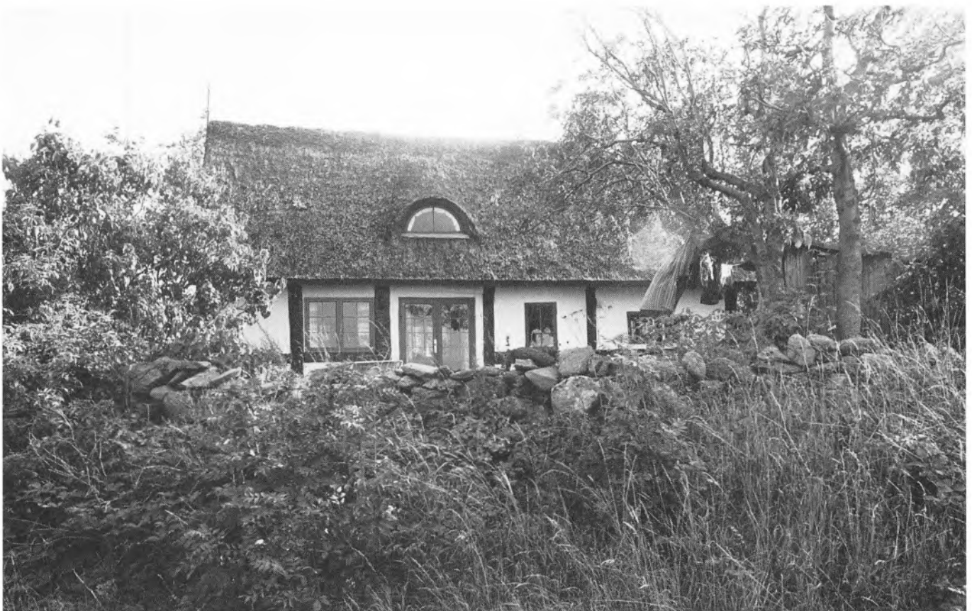
Fig. 61. Mor Markers Gænge 7, nordfacaden. Familien Markers hus ligger endnu ude på pynten, selv om det må formodes at have fået en hård medfart under stormfloden i 1872, hvor et nabohus i vest blev skyllet bort. Husets alder lader sig ikke fastslå, men stedet var i alt fald bebygget i begyndelsen af 1800-tallet. Trods istandsættelser har huset karakteristiske træk, som stråtag og husbrænde samt blysprossevinduer, i behold.
