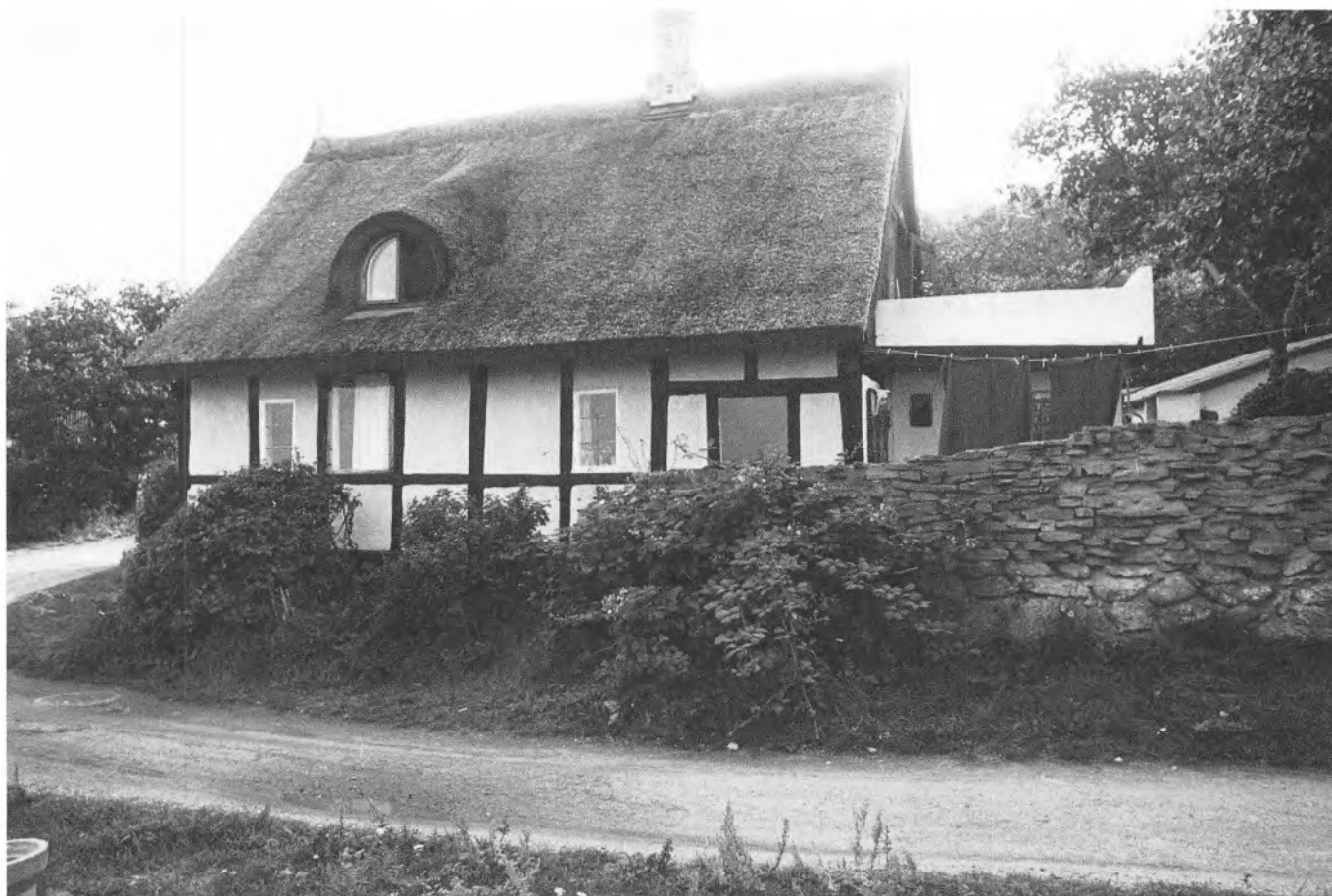
Fig. 58. Mor Markers Gænge 1, her set fra nord, står i hovedtræk som et velbevaret udtryk for byggeskikken omkring midten af forrige århundrede. Bygningen har endnu stråtag og husbrande i behold, men tagkvisten er et nyere indslag, ligesom et par helrudedede vinduer – heraf ét i et tidligere dørfag – har indtaget pladsen ved siden af de traditionelle, énrammede blysporsevinduer. Bemærk det fine gærde.
