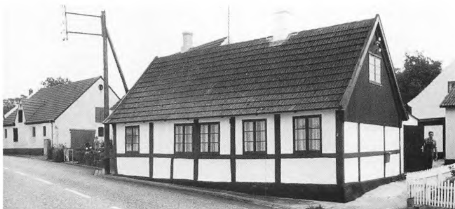
Fig. 23. Hans Thygesensvej 2, set fra nord-vest. Ældre, til dels ombygget bindingsværkshus. Det tidligere stråtag udskiftedes i begyndelsen af århundredet med cementstenstaget, der atter for nylig er udskiftet med tegl. Til venstre i billedet Hans Thygesensvej 8. Sammenlign fig. 20.
