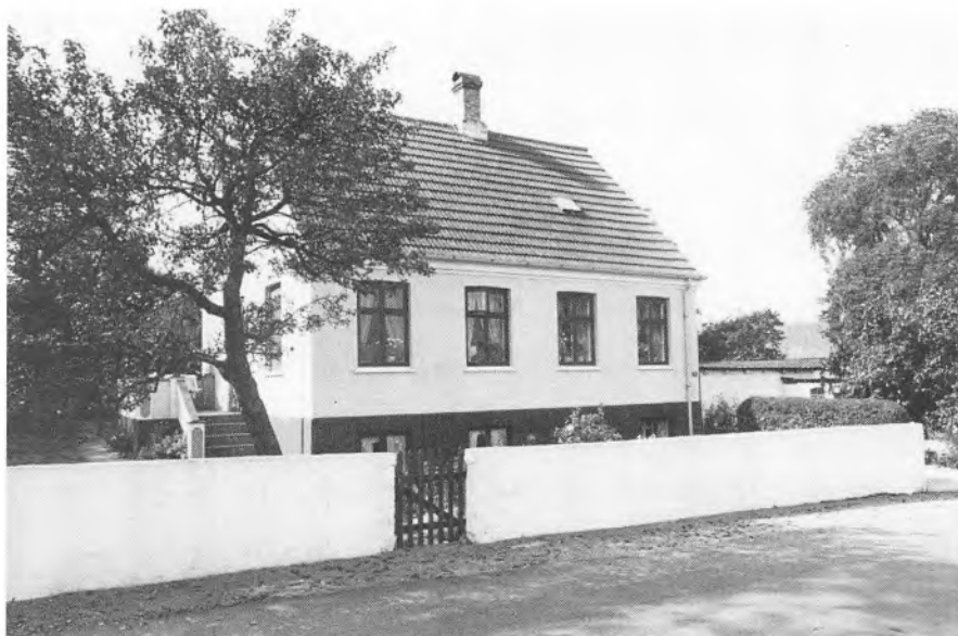
Fig. 106. Strandstien 18, set fra nordøst. Bygningen er opført for fisker Hansinius Nielsen i 1915.
