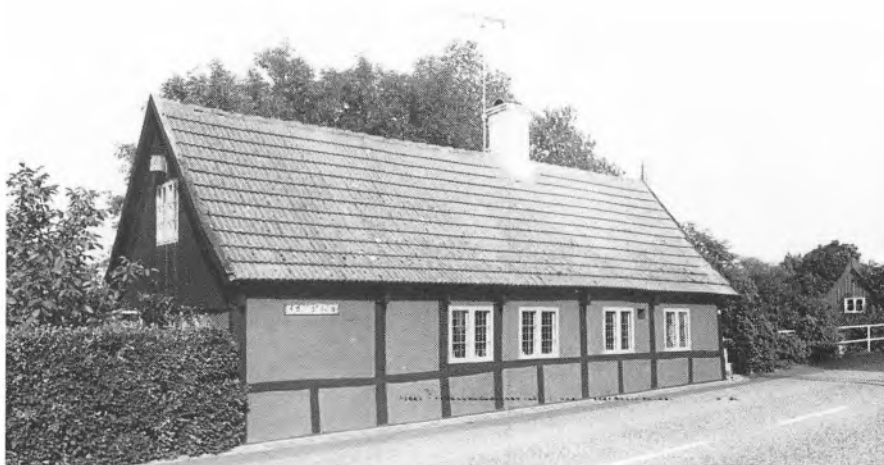
Fig. 73. Mosedalsvej 10, sydfacaden. Bindingsværksbygningen synes at være opført nogle årtier ind i 1800-tallet og har oprindeligt stået stråttækt.
