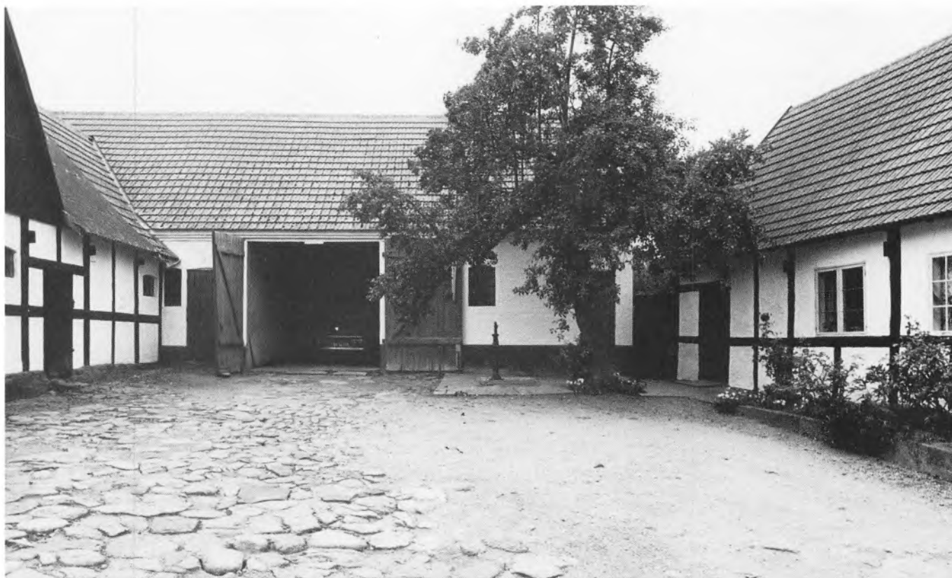
Fig. 39. Til højre stuehuset – og ved køkkendøren vandpost og træet, der også ses på ældre billeder, men som nu er fældet. Midt for den nye vestlænge fra 1930 og til venstre i billedet sydlængen, der synes at være opført i 1860'erne.
