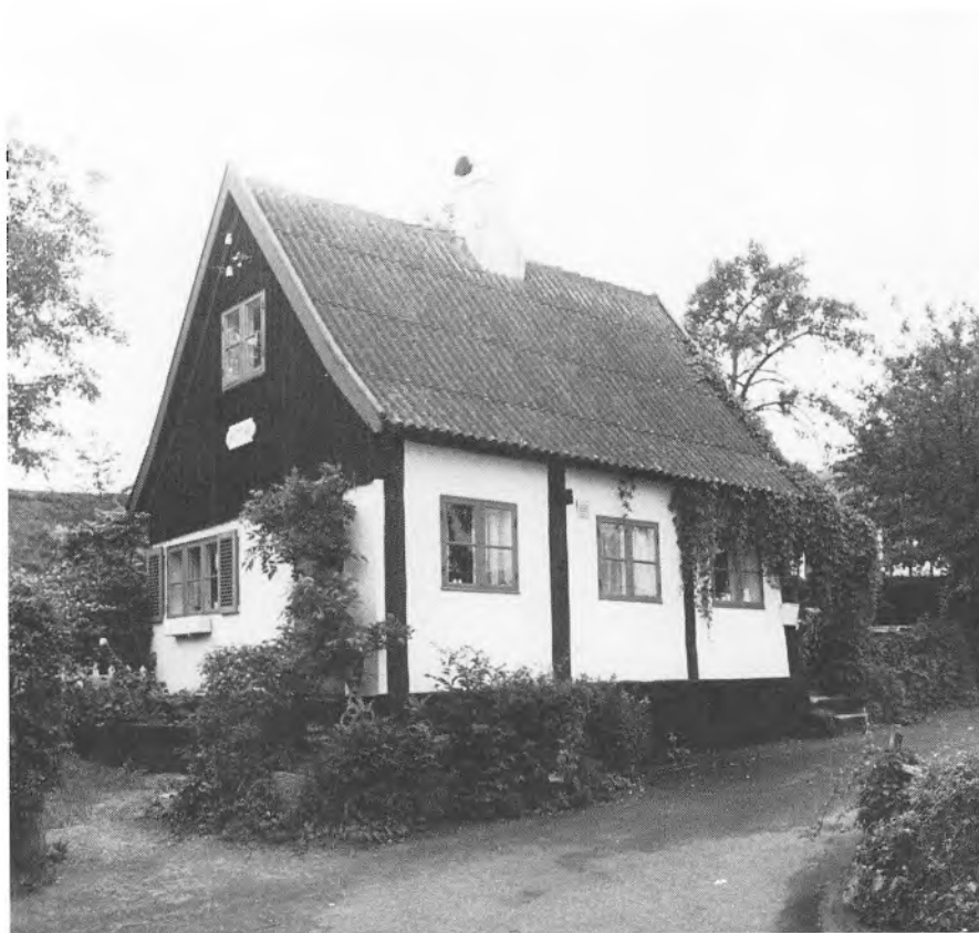
Fig. 33. Hans Thygesensvej 14 ved Anders Monsstrædes begyndelse. Bygningen blev udskilt fra hovedejendommen med nuværende adresse Per Sørensengade 2 i begyndelsen af 1800-tallet og udgjorde oprindeligt en tværføj til en større bygning. Huset præges af istandsættelsesarbejder i dette århundrede. Sammenlign hosstående fotografi.
