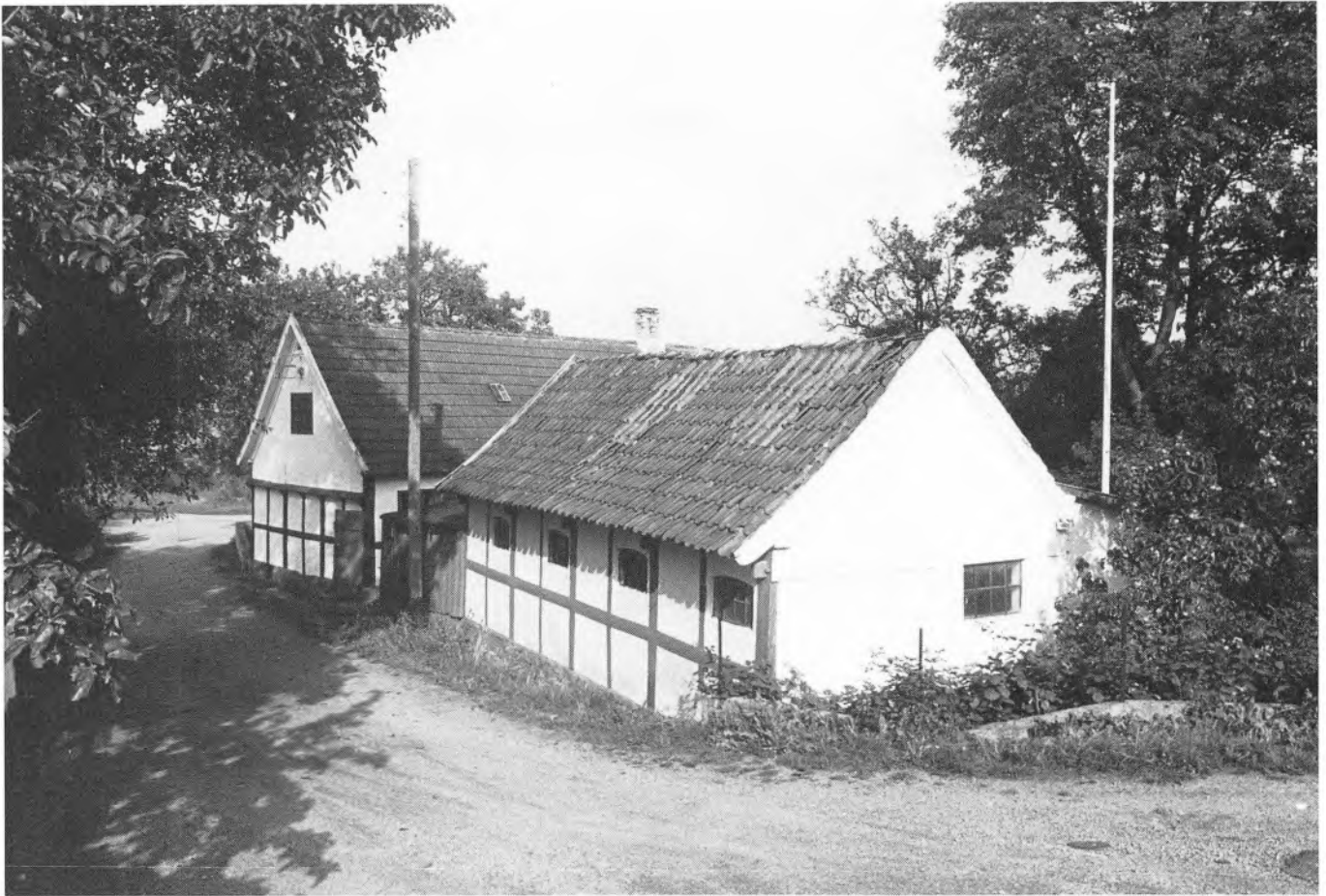
Fig. 59. Mor Markers Gænge 3, set fra syd-vest – sammenlign fig. 57. Beboelseshuset i nord fik cementstenstag i 1920, og efter sigende ophørte røgerivirksomheden på ejendommen i 1922, hvorefter bygningen i forgrunden indrettedes til svinehus.
