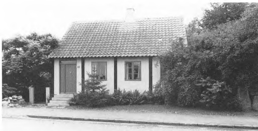
Fig. 54. Hans Thygesensvej 42, set fra nord. De tre vestre fag er opført for søstrene Ottoline og Augusta Jensen omkring 1890, og østfaget er tilbygget inden for den følgende snes år.
