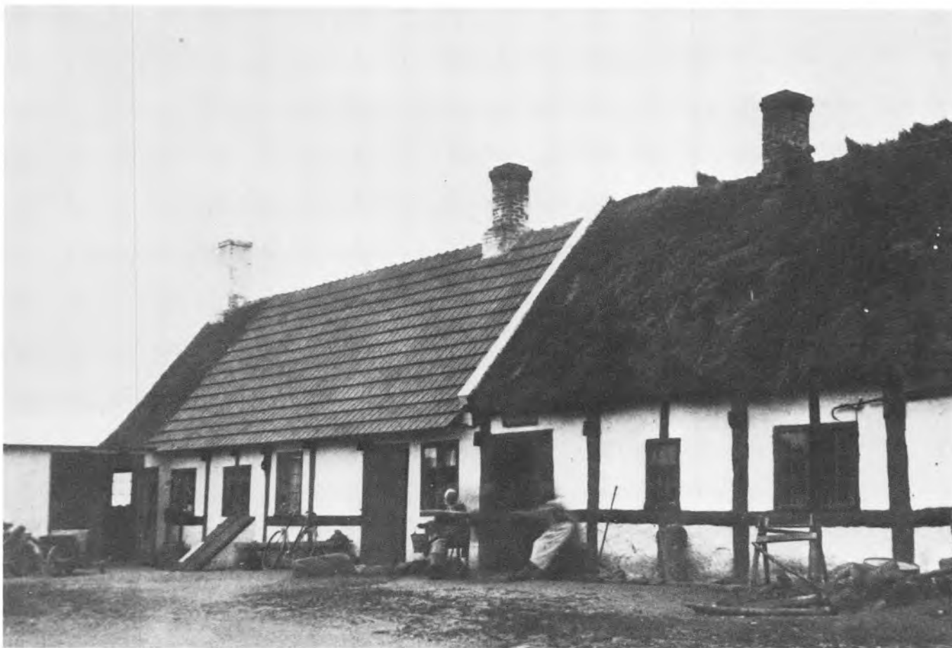
Fig. 106. Per Jørnsvej 6-8, set fra nord. Per Jørnsvej 6 i forgrunden udgør en del af den bygning, der ses indtegnet på stedet på matrikelkortet fra 1818. På det gengivne fotografi, der stammer fra begyndelsen af dette århundrede, har huset de fleste af sine oprindelige træk i behold. I bindingsværkskonstruktionen indgår fyldtømmer, både løsholter og oplængder, og højst sandsynligt er tavlene klinede. Taget er stråttækt, og vinduerne har blysprosser, det ene, med ni ret små, aflange ruder, er énrammet – en meget udbredt vinduestype endnu omkring midten af forrige århundrede. Fyldingsdøren er knapt så gammel. Det bagved liggende Per Jørnsvej 8 er overvejende opført i sidste halvdel af 1800-tallet. Bygningens fjerneste skorsten var tilsluttet et røgeri. (Fot. ca. 1920, tilh. Holger Beyer).
