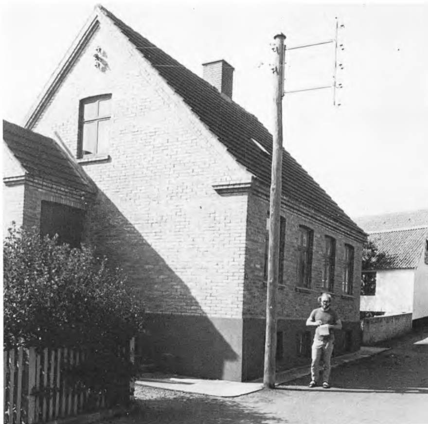
Fig. 111. Skarvigen 4 er opført så sent som i 1928, men tilslutter sig i sin fremtræden ganske naboejendommen, Skarvigen 6 fra 1910, se fig. 113. Bygherren var da også en broder til ejeren af dette hus, ligesom grunden var blevet udskilt derfra. (Fot. NM, 1974).
