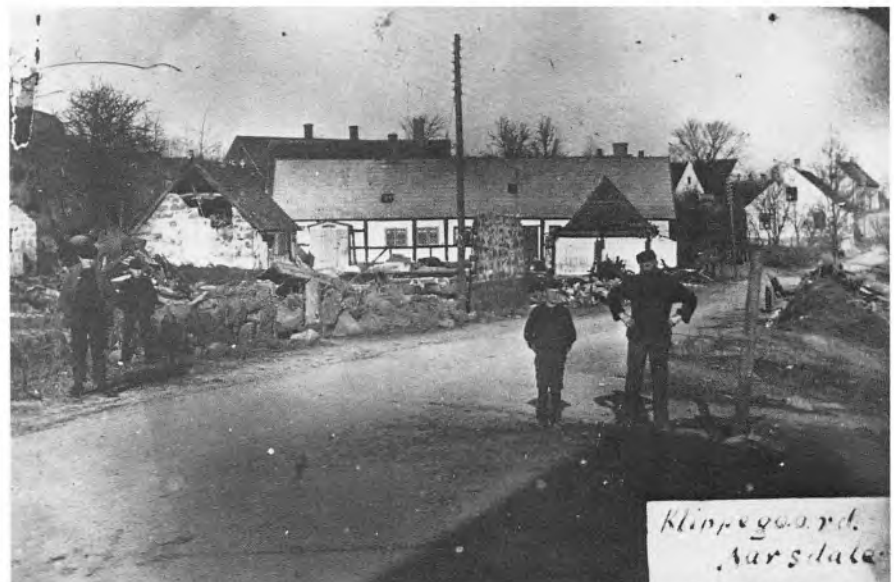
Fig. 140. Strandvejen 9, Klippegaard, fotograferet umiddelbart efter branden i 1921. Avlsbygningerne er alle nedbrændt med undtagelse af en mindre del af den lange bindingsværkslænge ud mod vejen, som ses på fig. 139. Det gamle stuehus har derimod overlevet branden, formentlig som følge af, at stråtaget nogle år tidligere var blevet udskiftet med cementsten. (Fot. 1921, tilh. Holger Beyer).
