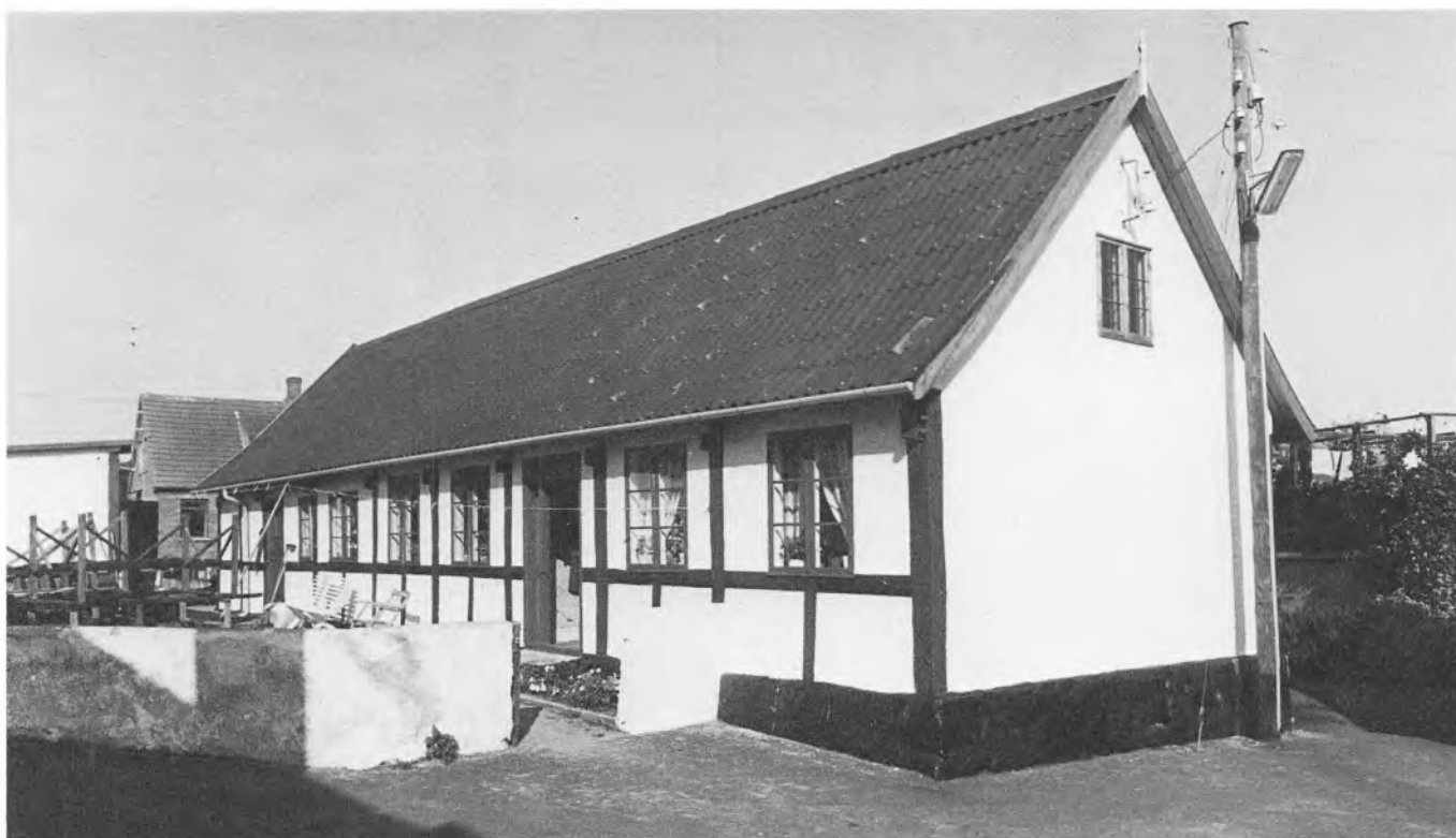
Fig. 22. Brugsebakken 18, set fra sydøst. Bygningen er antagelig fra omkring 1800, og den strakte sig førhen længere mod vest. Den oprindelige byggemåde med klinede tavl og stråtag er ændret efterhånden som vedligeholdelsen har krævet indgreb. Nu er tavl og gavle murede, og som så mange andre bindingsværkshuse i byen fik dette cementsten på taget omkring århundredskiftet. Tagklædningen er atter udskiftet til eternit i de senere år; ved denne omlægning har man holdt traditionen med de pyntelige husbrande i hævd. Ligeledes kan det fremhæves, at man har isat traditionelle, smårudede blysprosevinduer ved vinduesudskiftningerne i gavlene. (Fot. NM, 1974).
