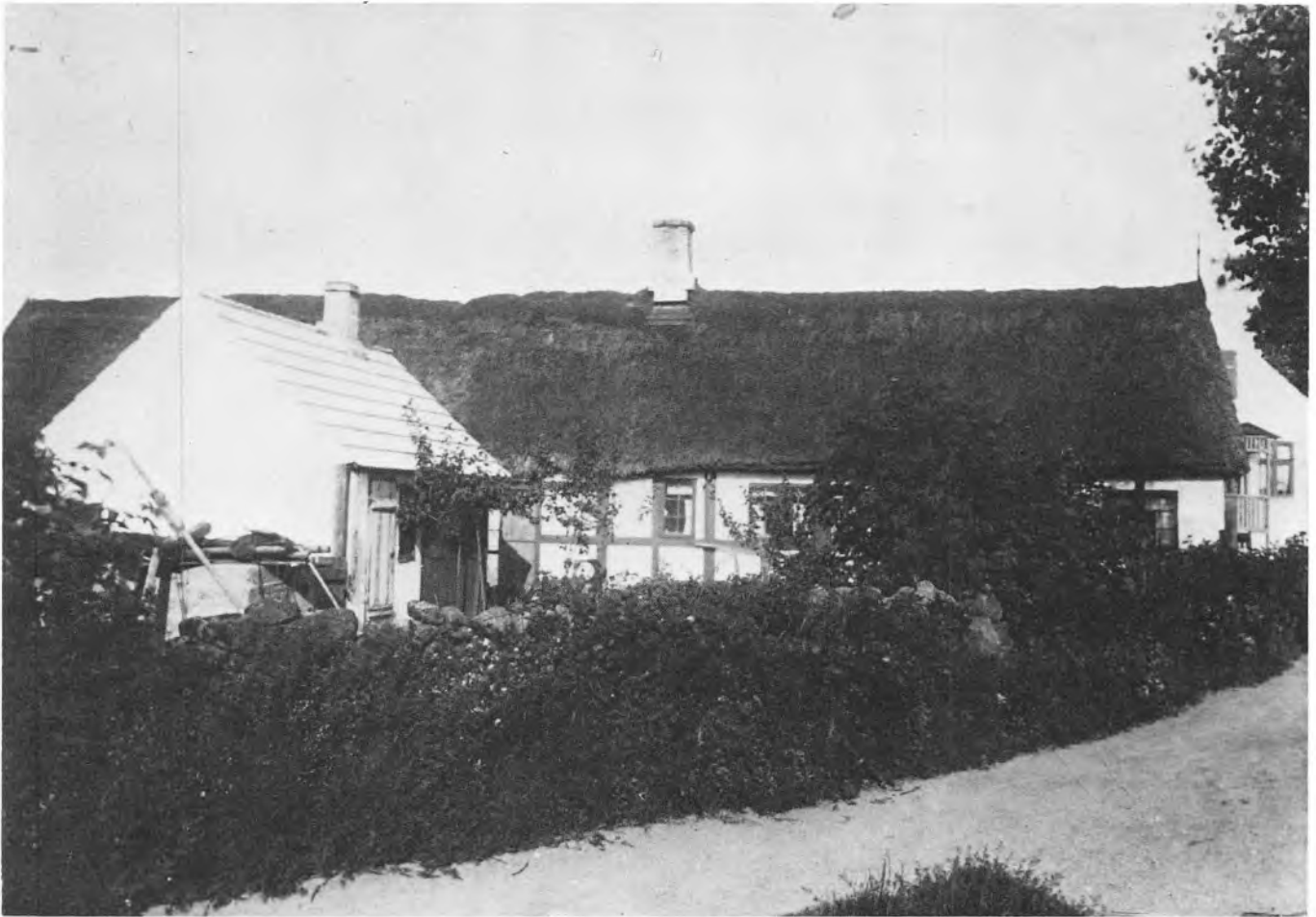
Fig. 12. Brugsebakken 11, set fra vest, o. 1910. Huset ses i sin oprindelige bindingsværksfremtræden og med blysprossevinduer og revledør samt stråtag og husbrand på sydgavlen. Grunden er afgrænset ud til et af byens gamle stræder (gøjnager) med et stengærde, formentlig det samme, som er markeret på kortet fra 1818. (Fot. ca. 1910, tilh. Holger Beyer).
