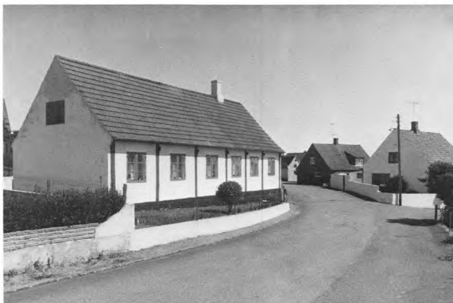
Fig. 100. Nørre Næbbe 6, der her ses fra sydvest, er bygget omkring midten af forrige århundrede, hvor der i øvrigt hørte en stubvejrmølle til ejendommen. Fjernelse af løsholter og oplængder i facaden og gavlenes opmuring er senere forandringer, ligesom oplægningen af cementtagstenene i stedet for strå. (Fot. NM, 1979).
