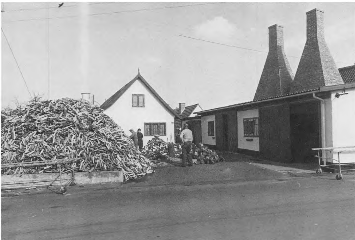
Fig. 21. »Hjorths røgeri« i Brugsebakken er grundlagt o. 1920 af Vilhelm Andreas Hjorth Hansen. Røgeriskorstene er opmurede i flammede sten, som det var almindeligt på den tid; de ældre skorstene i byen var pudsede eller vandskurede og kalkede. »Galleriet« er ombygget til større højde for nogle år siden. Billedet er fra april 1979, umiddelbart før sæsonens start. Det kløvede brænde (elletræ) tårner sig op, og »bæringerne« er kørt ud. (Fot. NM, 1979).
