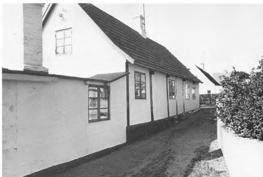
Fig. 66. Nordfacade af Gavlegade 11, der har sin oprindelse i et gammelt vagthus – et led i Bornholms kystbefæstning. Vagthuset var kun på to fag, og bygningen er således stærkt ombygget og udvidet, efter at den er overgået til privat beboelse. (Fot. NM, 1974).
