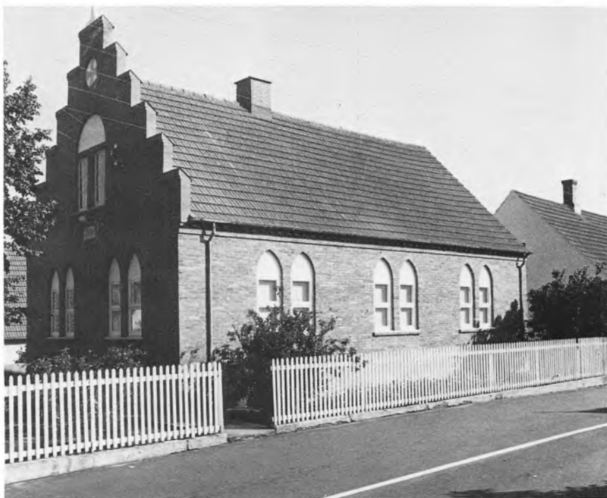
Fig. 38. Gaden 19, missionshuset »Bethel«, tilhørende Indre Mission. Bygningen er opført i 1923 og har med sin kamtakkede vestgavl og de rund- og spidsbuede blændingsfelter over dør og vinduer et åbenlyst kirkeligt tilsnit. I byen er desuden et missionshus for Bornholms Forening til Evangeliets Fremme, jfr. Møllevej 12. Sammenlign også fig. 1. (Fot. NM, 1974).
