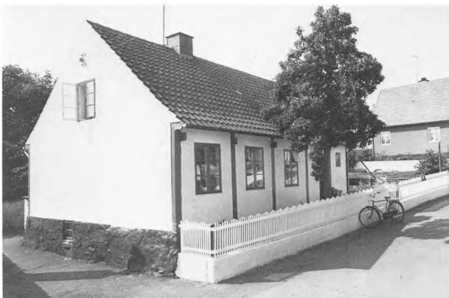
Fig. 129. Skolebakken 7, set fra nordøst. Huset er opført på lejet grund fra Klippegaard i 1880'erne. Bygherren, Andreas Hansen, fik dog skøde på grunden få år senere. Huset er blandt de senest opførte bindingsværkshuse i byen og af samme type som eksempelvis Nørre Næbbe 1 og 3 – jfr. fig. 98 og 99. De to vestre fag er tilbygget i 1955. (Fot. NM, 1974).
