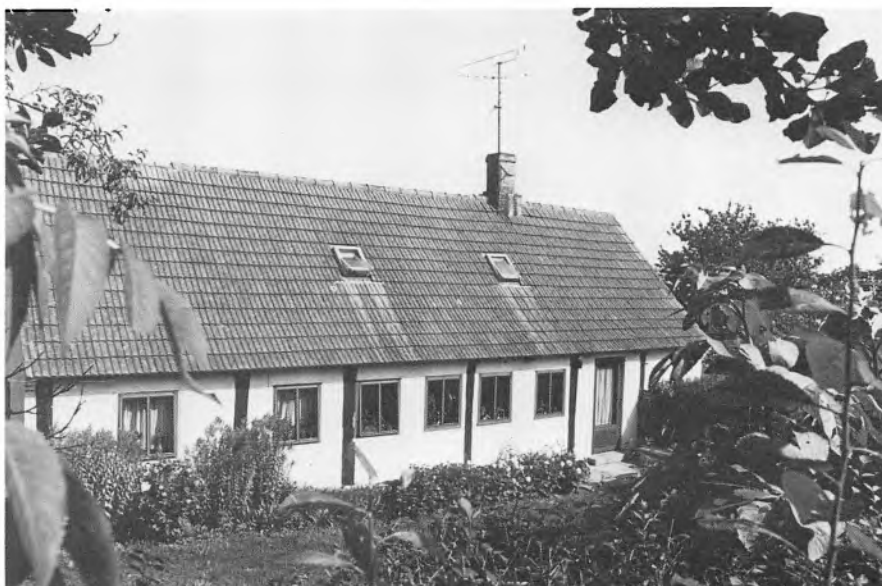
Fig. 86. Sydfacade af Møllevej 1 som det tager sig ud i dag, sammenlign fig. 85. Skorstenen i vestfaget er sløffet, men der ses stadig spor efter den i tagryggen. De oprindelige torammede, tværsprossede vinduer er udskiftet med tophængte rammer med en kraftig lodsprosse, der illuderer post, også havedøren er udskiftet. (Fot. NM, 1974).
