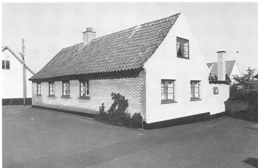
Fig. 103. Per Jørnsvej 1, set fra sydøst. Bag den gule skalmursfacade står huset i bindingsværk som ved opførelsen for ca. 140 år siden; i bagsiden er denne oprindelige byggemåde endnu synlig. Huset opførtes af fuldtømmer og med tegltag, hvorved det skilte sig ud fra samtidens gængse, stråttækte byggeri. Bygherren var Peder Jørgen Nielsen, efter hvem gaden har fået navn. Sammenlign fig. 26 og 27. (Fot. NM, 1974).
