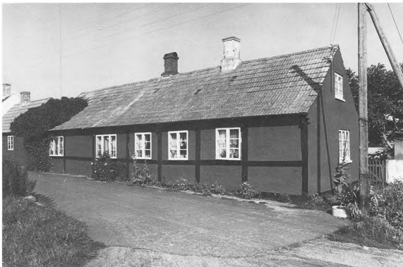
Fig. 62. Sydfacade af Gavlegade 3, formentlig opført i begyndelsen af 1800-tallet, men senere udvidet i vest. (Fot. NM, 1974).
