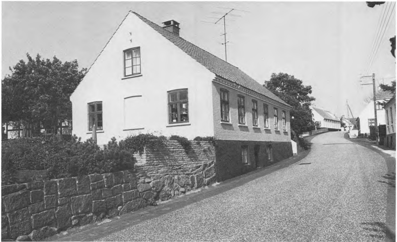
Fig. 143. Strandvejen 15, set fra sydøst. En fornem bygning med den for bornholmsk byggeri så karakteristiske høje fodmur, der bl.a. tjener til udjævning af terrænforskelle i klippegrunden. Huset er bygget o.1880 på en tidligere haveplads til ejendommen med nuværende adresse Laksegade 2. Der har tidligere været indgang i andet fag fra nord. Hovedgesimsen har en murstenssat bort med skiftevis sav- og tandsnit, der også ses på andre huse fra perioden – jfr. eksempelvis fig. 56; i bagsiden er en tandsnitsgesims. (Fot.NM, 1974).
