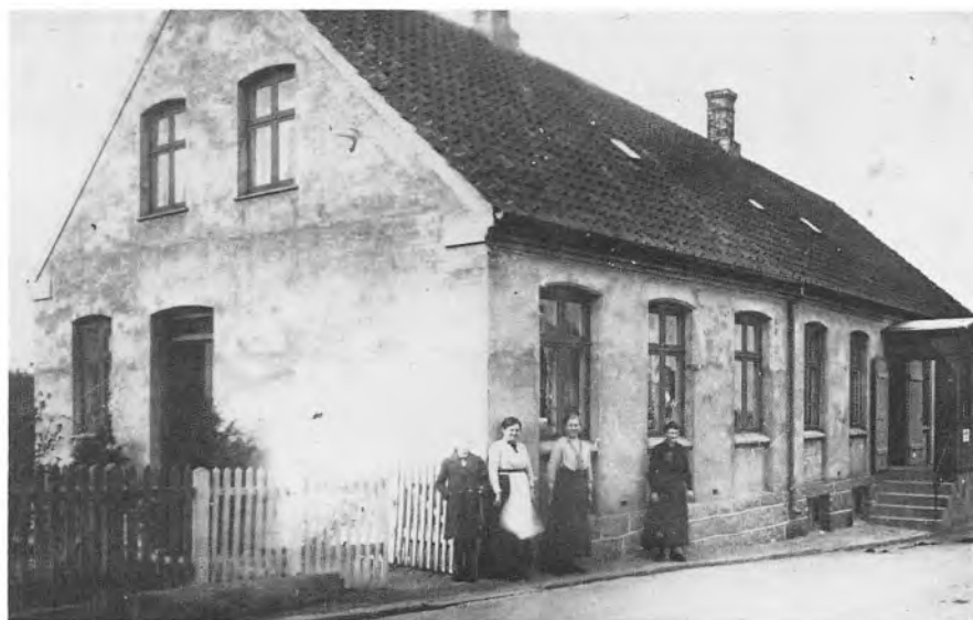
Fig. 6. Billedet gengiver Aarsdale Forbrugs- eller Husholdningsforenings bygning o. 1920. Huset er siden udvidet med fire fag mod sydvest. Dobbeltløbstrappen med overdækket indgang havde afløst en oprindelig ligeløbstrappe. Foran huset har uddeler Nielsens kone og datter samt to butiksjomfruer taget opstilling. (Fot. ca. 1920, tilh. Holger Beyer).
