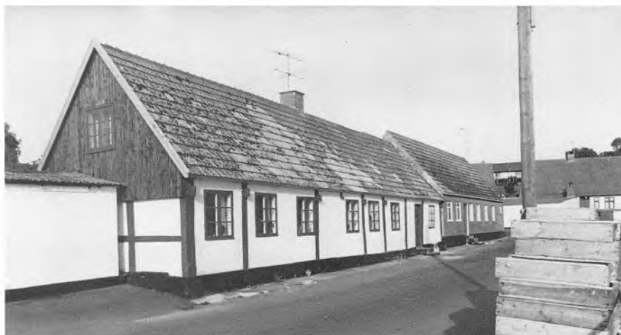
Fig. 76. Laksegade 6 og 4, set fra nordøst. Laksegade 6 er formentlig gadens ældste hus, men det kan ikke følges i arkivalierne længere tilbage end til begyndelsen af 1800-årene. Fjernelse af fyldtømmer og oplægning af cementsten på taget har i nogen grad ændret bygningens karakter, men husets dimensioner og tømmerets beskaffenhed vidner om en anseelig alder. I baggrunden ses Laksegade 4, der er bygget o. 1850 og skalmuret til gaden omkring midten af dette århundrede. (Fot. NM, 1979).
