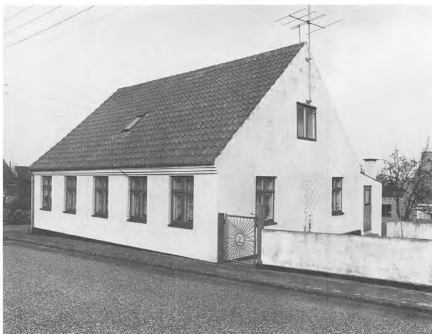
Fig. 109. Skarvigen 2, der her ses fra Gaden, er opført i 1860'erne og er således et af de ældste grundmurede huse i byen. Den aftrappede hovedgesims genfindes på Laksegade 14, ligeledes fra 1860'erne og Gaden 37 fra 1875. Huset er opført af snedker Johs. Hansen, fiskerlejets senere formand, der erhvervede byggegrunden i 1862 og selv beboede huset. (Fot. NM, 1979).
