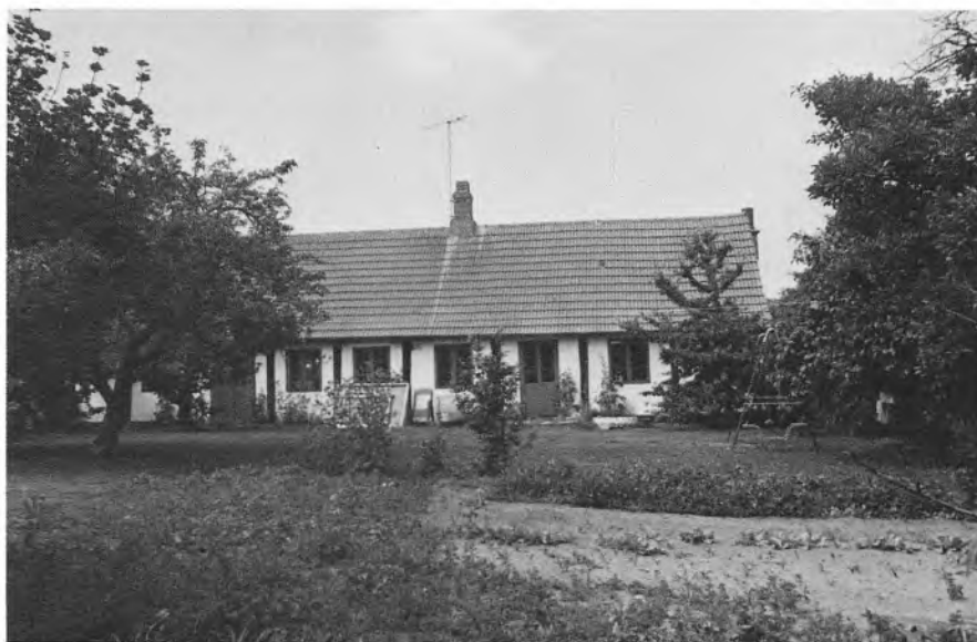
Fig. 47. Gaden 25, formentlig opført i begyndelsen af 1800-tallet. Indtil 1930'erne hørte der avlsbrug til ejendommen, og bygningen rummede ladehus i øst og beboelse i vest. Sydfacaden, som ses her, står endnu helt i bindingsværk; cementstenene på taget er oplagt omkring århundredskiftet – tidligere havde bygningen stråtag. (Fot. NM, 1979).
