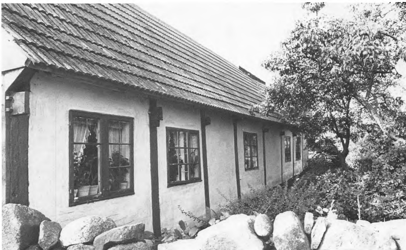
Fig. 119. Skarvigen 11, nordfacade. I forgrunden stengærdet om den ret store have. (Fot. NM, 1974).
