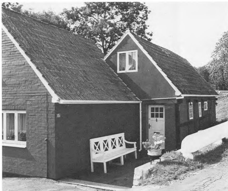
Fig. 134. Det gamle beboelseshus til Skolebakken 15 hører til den ældre del af bebyggelsen i dette område af byen, idet huset synes at være opført i 1830'erne. Et lille udhus, der tidligere lå nord for hovedhuset, blev nedrevet i forbindelse med en vejudvidelse, og i stedet opførtes den ret dominerende bygning i billedets forgrund. (Fot. NM, 1974).
