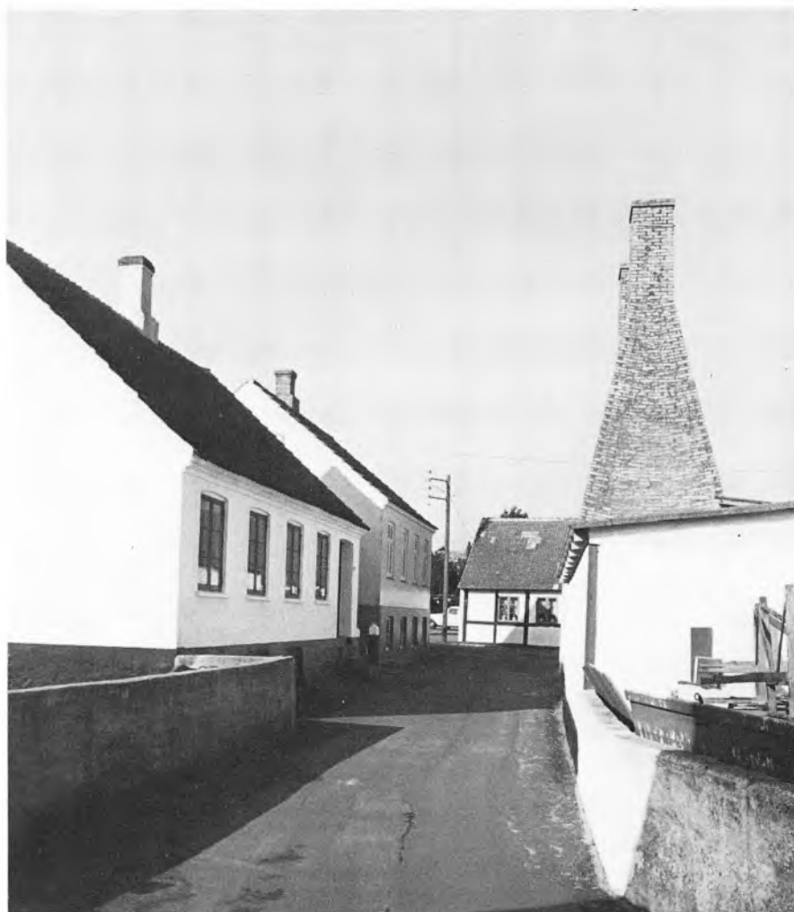
Fig. 104. I forgrunden til venstre Per Jørnsvej 2 og bag dette Brugsebakken 16. Til højre i billedet knejser de to skorstenspiber fra Hjorths røgeri i Brugsebakken 18. Per Jørnsvej 2 er bygget i begyndelsen af 1880'erne og står i alt væsentligt uændret i dag; jfr. i øvrigt omtalen af denne type grundmurshuse ved fig. 77. På fig. 20 ses husets sydside. (Fot. NM, 1974).
