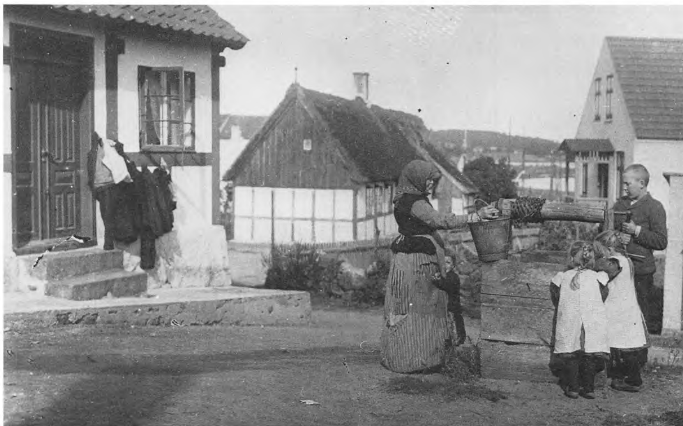
Fig. 19. På billedet ses fra venstre mod højre Brugsebakken 14, 11 og 16 – i baggrunden et kig mod nord ud over havnen. Ved brønden står Jørgen Espersens kone, bosiddende i nr. 14, omgivet af børnebørn fra nr. 16 og en større dreng. Bemærk, at Brugsebakken 14 (fra 1860'erne) endnu har sin oprindelige skikkelse med tegltag og fyldtømmer samt bly-sprossevindue(r) med vindjern og fyldingsdør – sammenlign fig. 18. Ligeledes står den noget ældre bygning, Brugsebakken 11, endnu i sin traditionelle skikkelse med karakteristisk, pyntelig gavls samt en af de førhen så almindelige hodder. Brugsebakken 16, opført o. 1900, ses med falstagsten, de er siden udskiftet med vingetaststen – ligeledes i cement. (Fot. Valdemar Myhre, ca. 1910).
