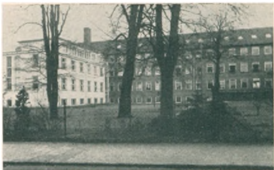
Den moderne Fabriksbygning
