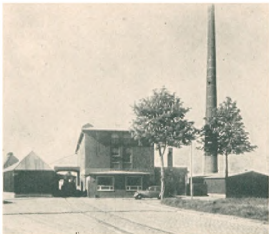
Virksomhedens Facade mod Kastelsvej
