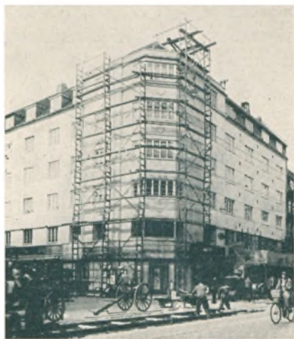
Arbejde under Udførelse hos Martin Bank, Amagerbrogade
