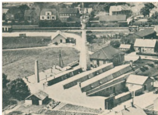
Hovedfabriken i Hedensted, som den ser ud efter Ombygningen 1951
