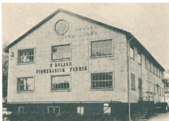
Den moderne Fabriksbygning
