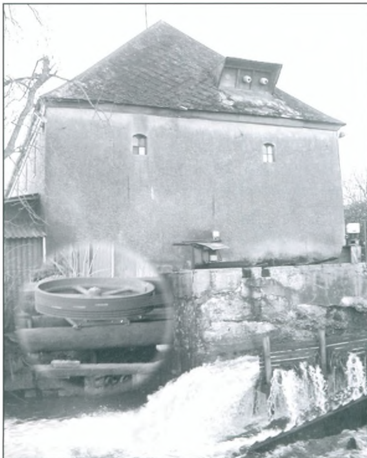
Ganer Mølle i dag. På taget ses stadig isolationsklokkerne, hvorfra strømmen blev ført til Bølling. På det indklippede billede ses et svinghjul med lodret aksel til en vandturbine - svarende til forholdene i 1924.
