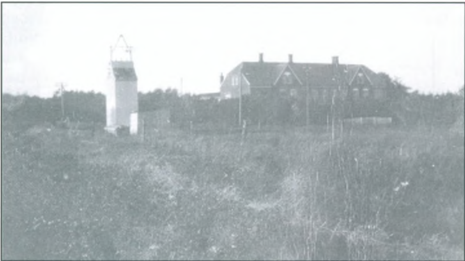
Transformortårnet i Bølling. I baggrunden ses skolen.
